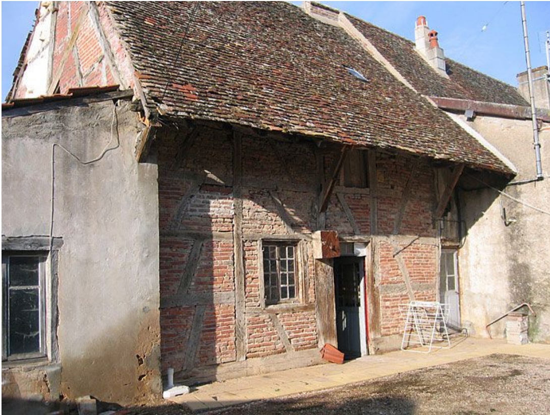
Vue de la partie gauche de la façade.
