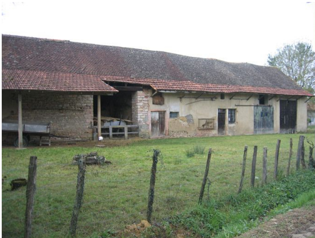
Vue de la partie droite de la façade.
