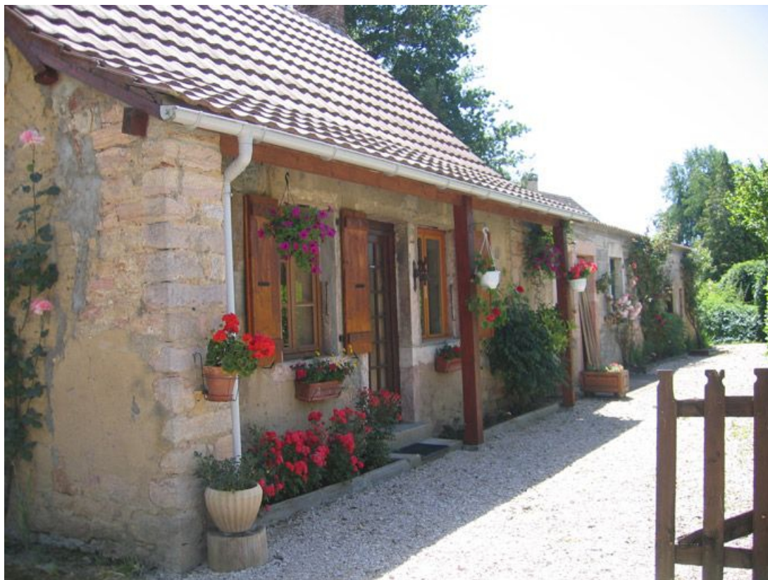
Vue d'ensemble de la façade.
