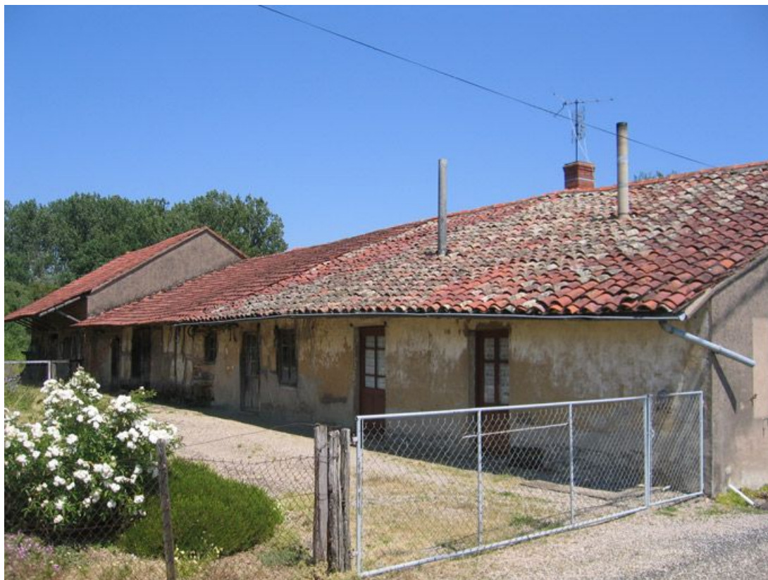
Vue d'ensemble de la façade.
