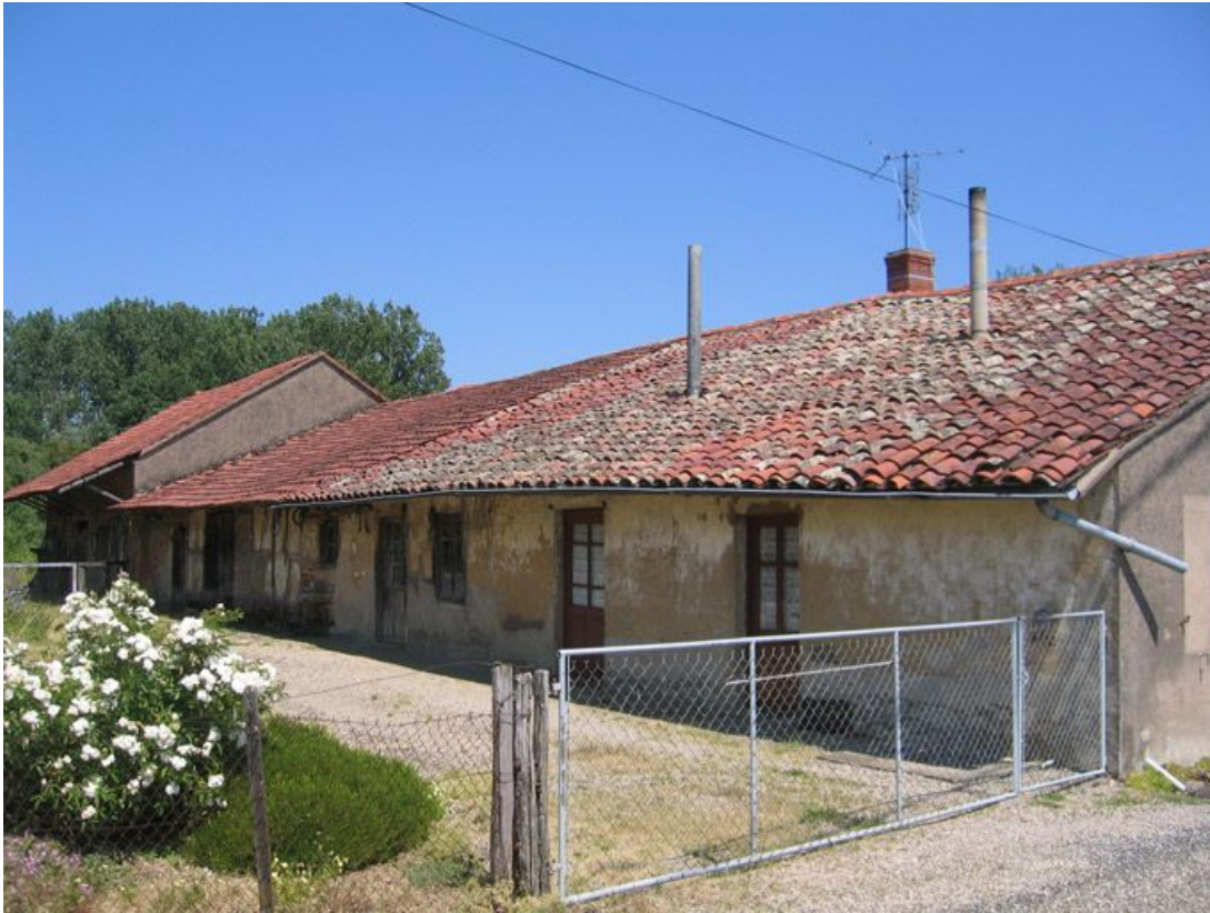
Vue d'ensemble de la façade.
