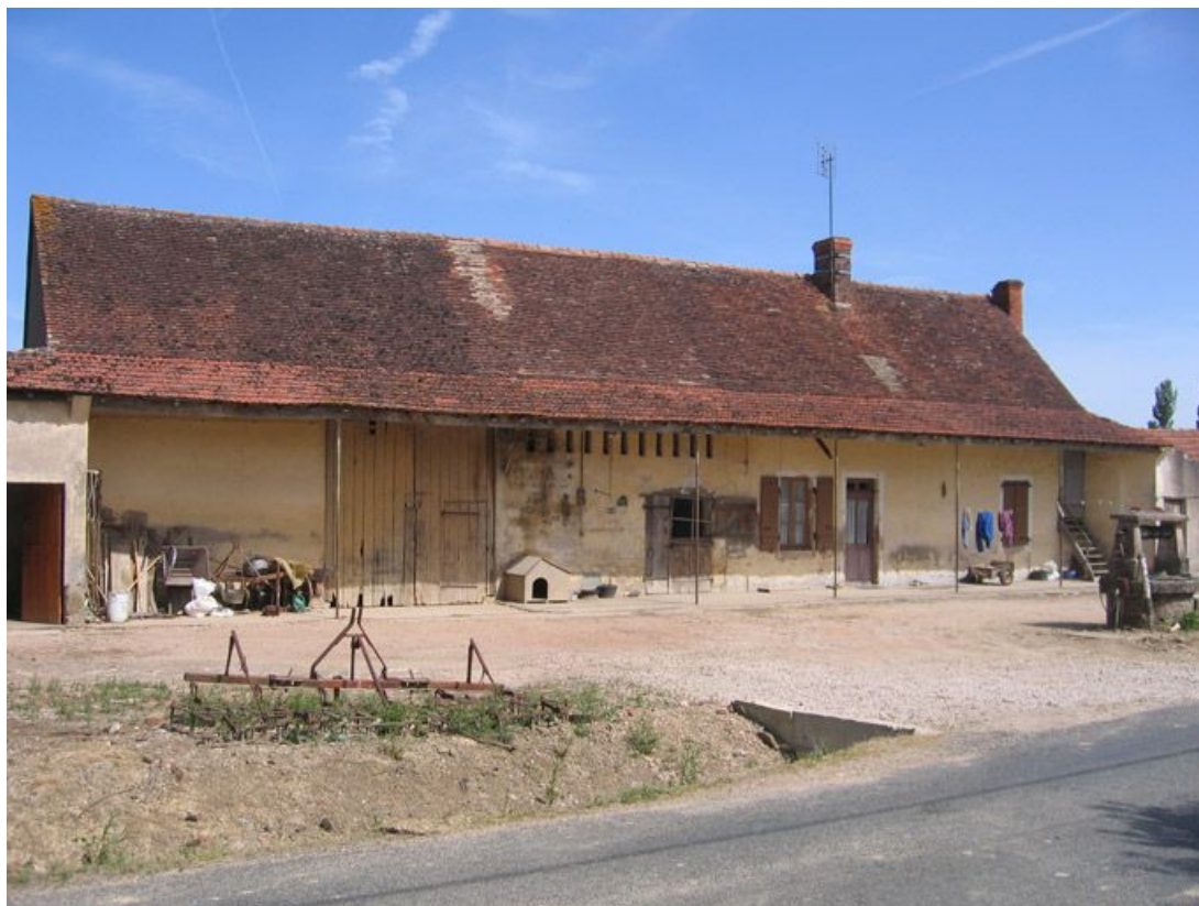
Vue d'ensemble de la façade.
