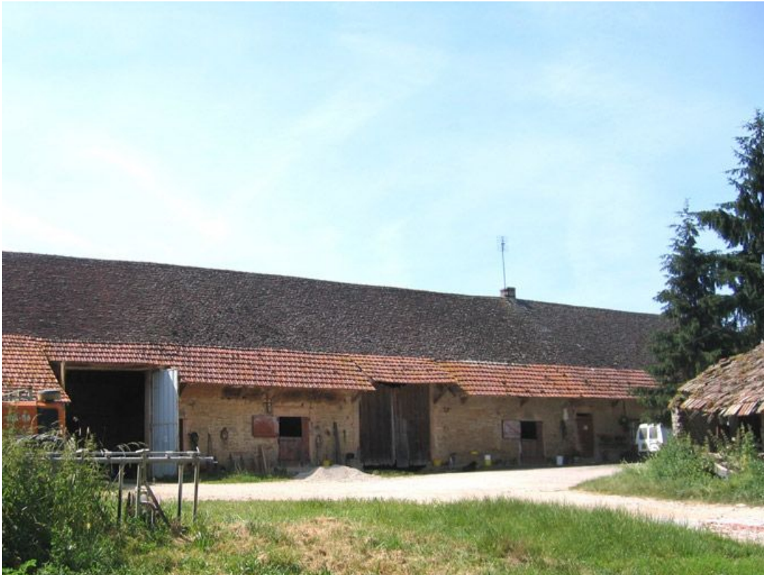
Vue d'ensemble de la façade.
