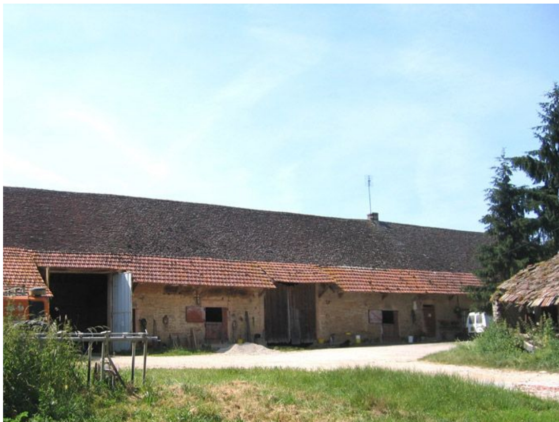
Vue d'ensemble de la façade.
