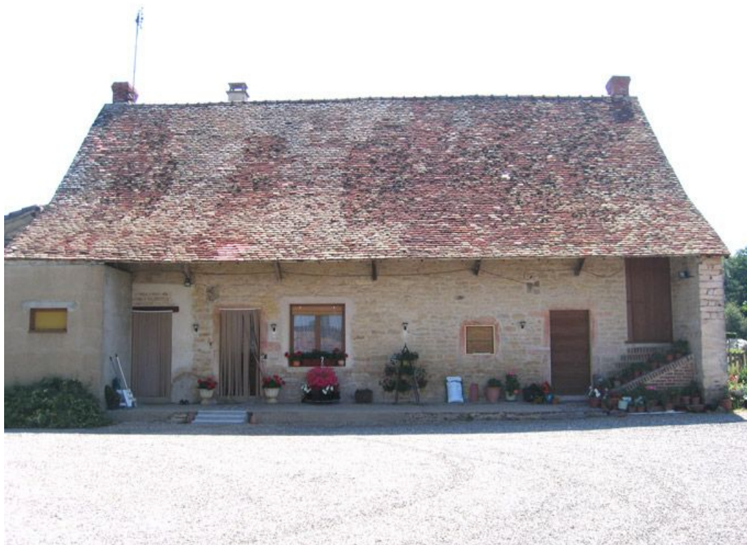
Vue d'ensemble de la façade.
