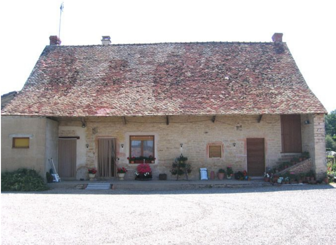
Vue d'ensemble de la façade.
