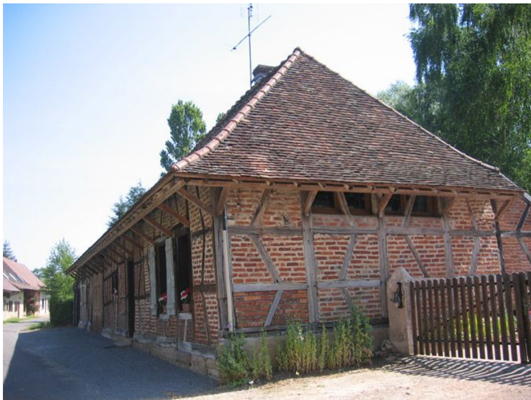
Vue d'ensemble de la façade.
