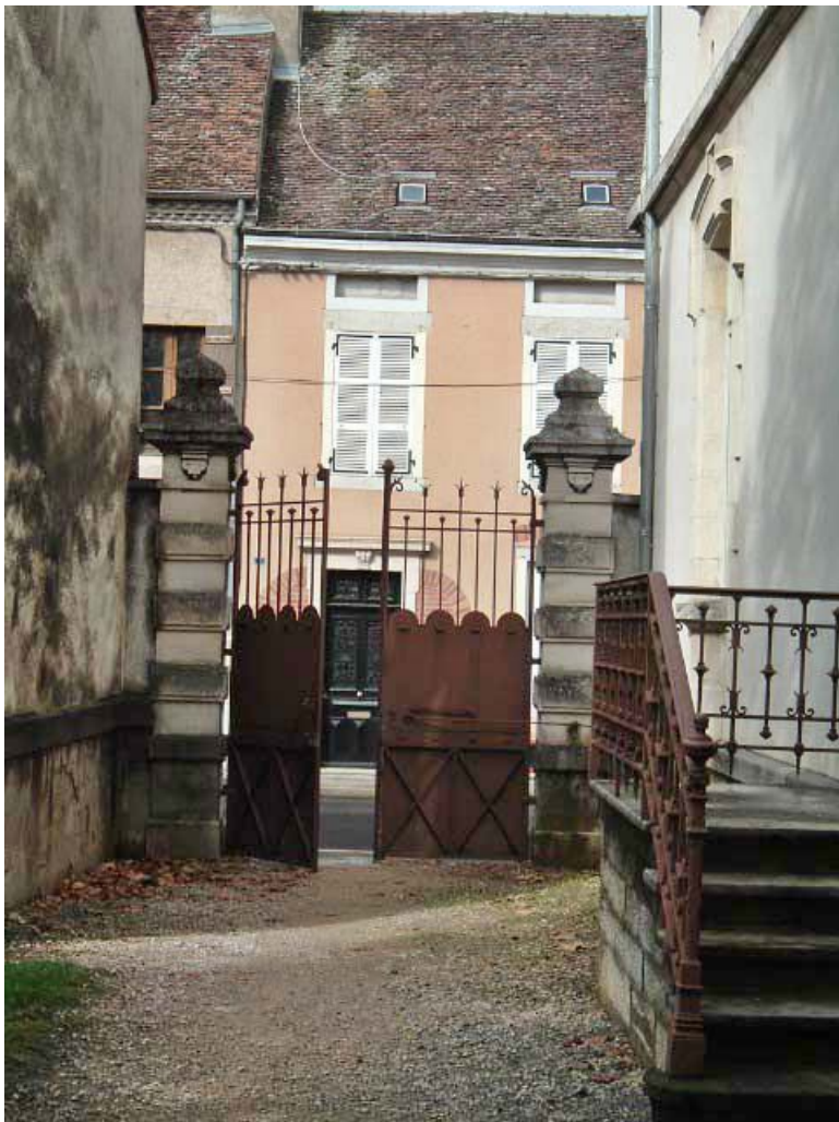
Vue du portail, de la grille et de l'escalier en fonte de l'entrée située sur la façade postérieure de l'établissement. 71, Louhans, 12 rue Ferdinand Bourgeois
