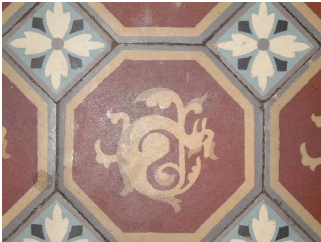
Vue de détail du carrelage du rez-de-chaussée.
