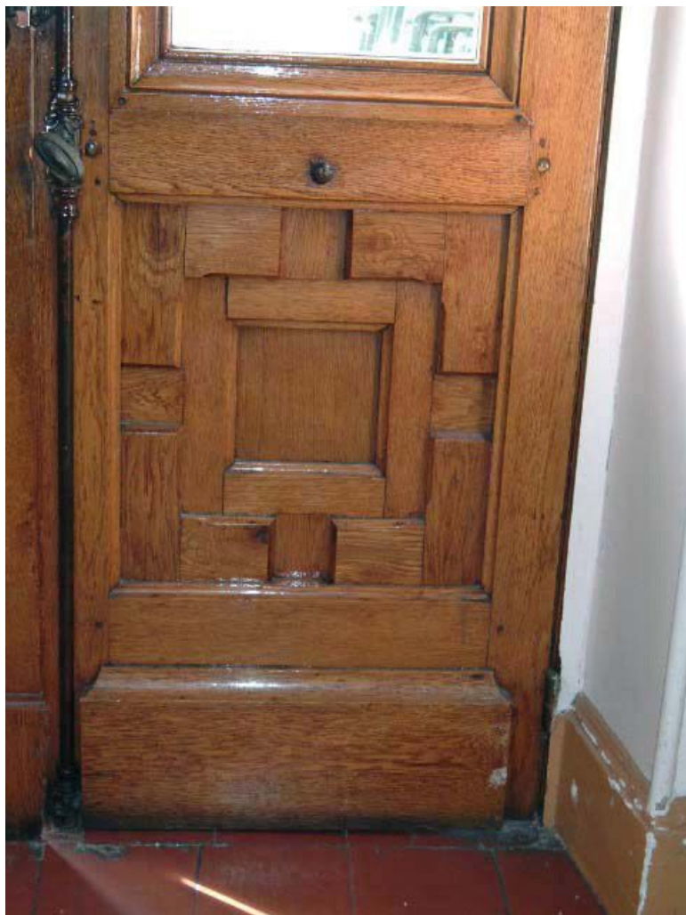
Vue de détail d'un panneau bois d'une porte d'entrée, assemblage vu de l'intérieur du bâtiment. 71, Louhans, 12 rue Ferdinand Bourgeois
