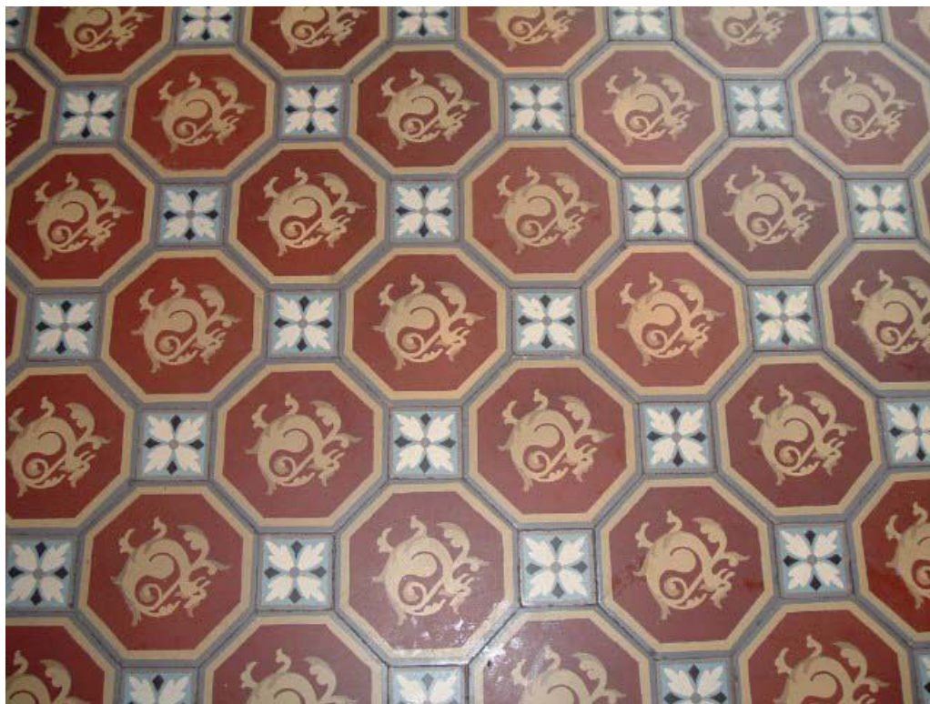
Vue de détail d'un ensemble de carreaux de ciment du rez-de-chaussée.
