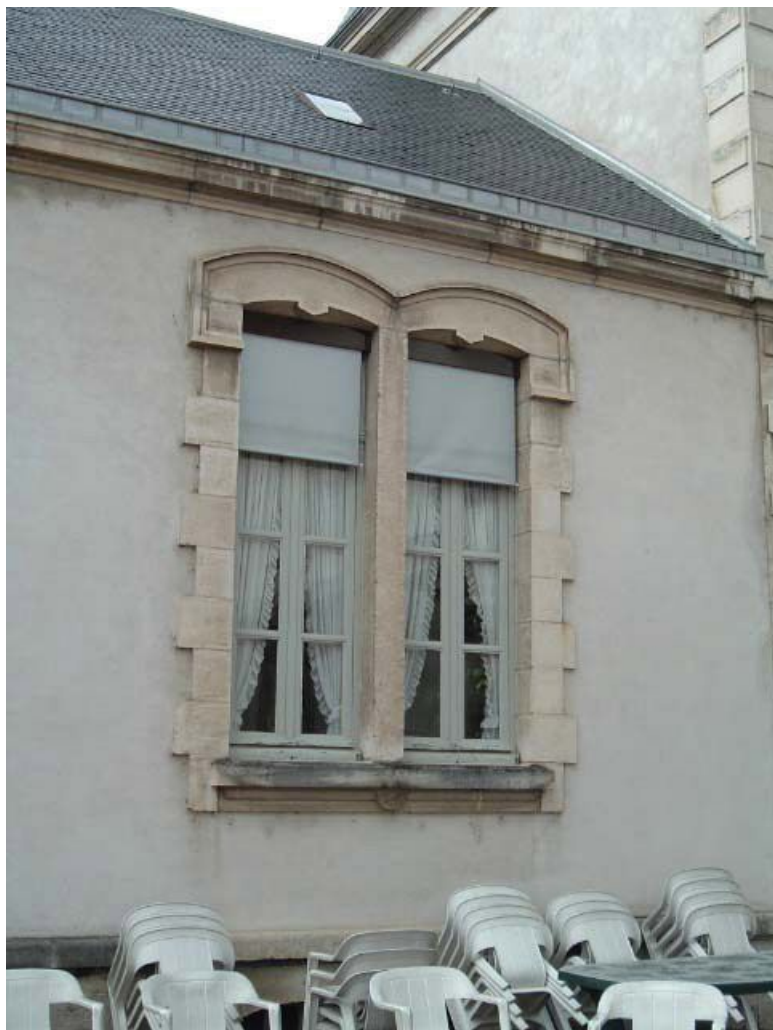
Vue de détail d'une baie géminée (aile gauche surbaissée).
