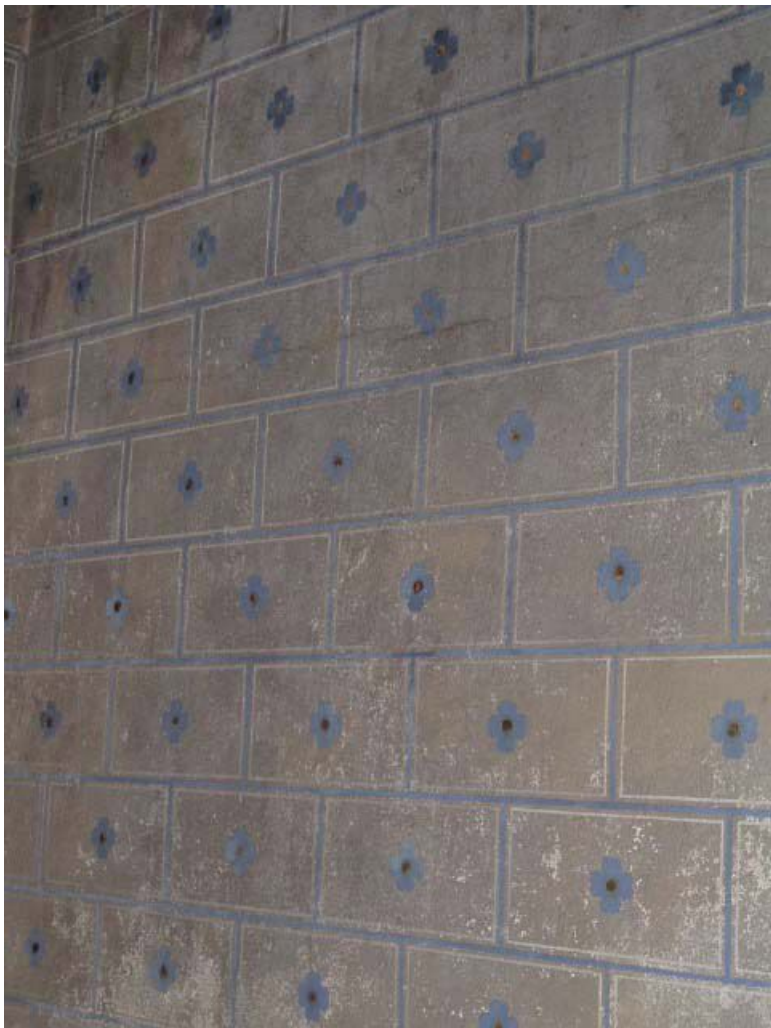
Vue de détail de la peinture murale de l'oratoire (décor polychrome faux joints et fleurette).
