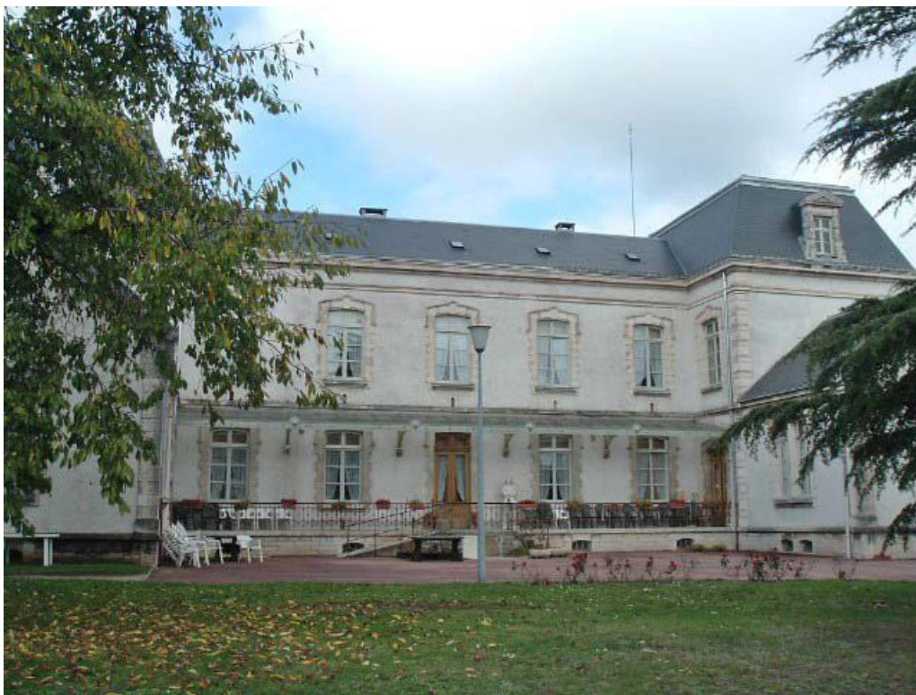
Vue générale de la façade antérieure.
