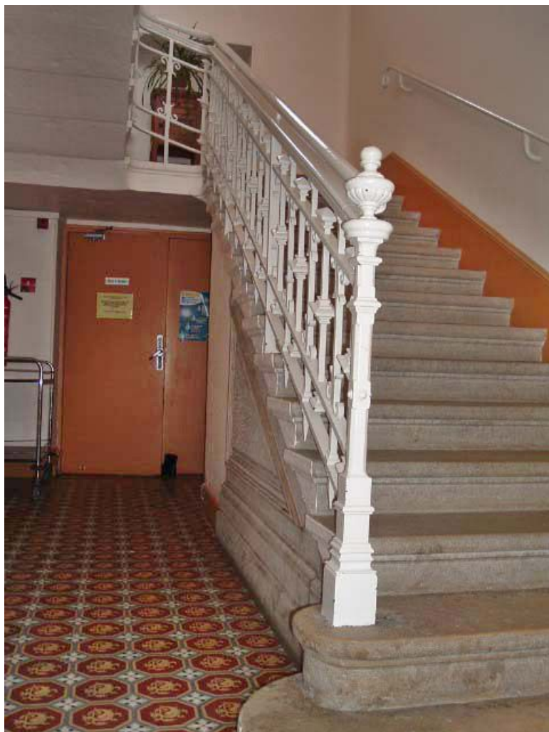
Vue intérieure, escalier en fonte au départ du rez-de-chaussée et carrelage en ciment. 71, Louhans, 12 rue Ferdinand Bourgeois
