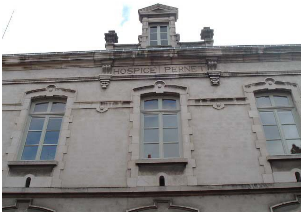
Vue de détail de la façade postérieure, étage carré, inscription HOSPICE PERNET.
