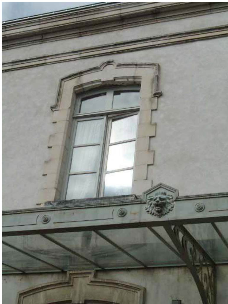
Vue de détail d'une fenêtre de la façade antérieure.
