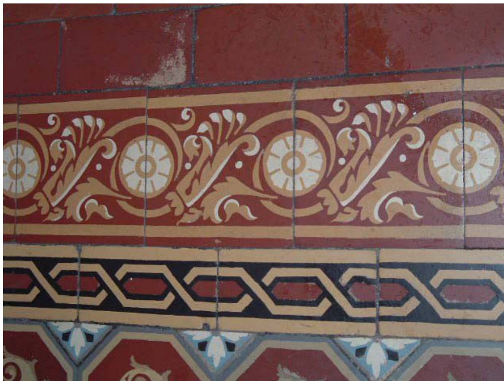
Vue de détail de la frise extérieure du carrelage en ciment, rez-de-chaussée.
