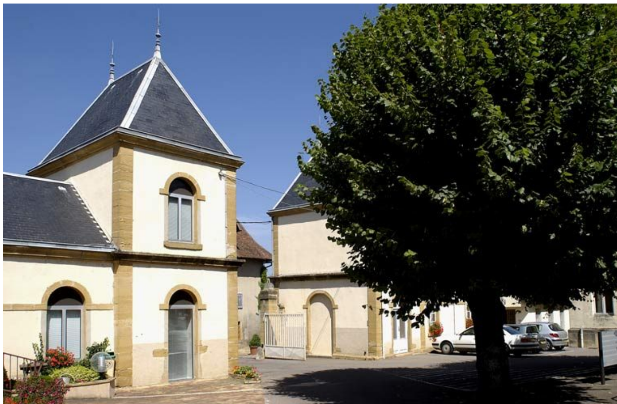
Pavillons d'entrée, vue générale depuis la cour. 71, Charolles, 6 rue du Prieuré
