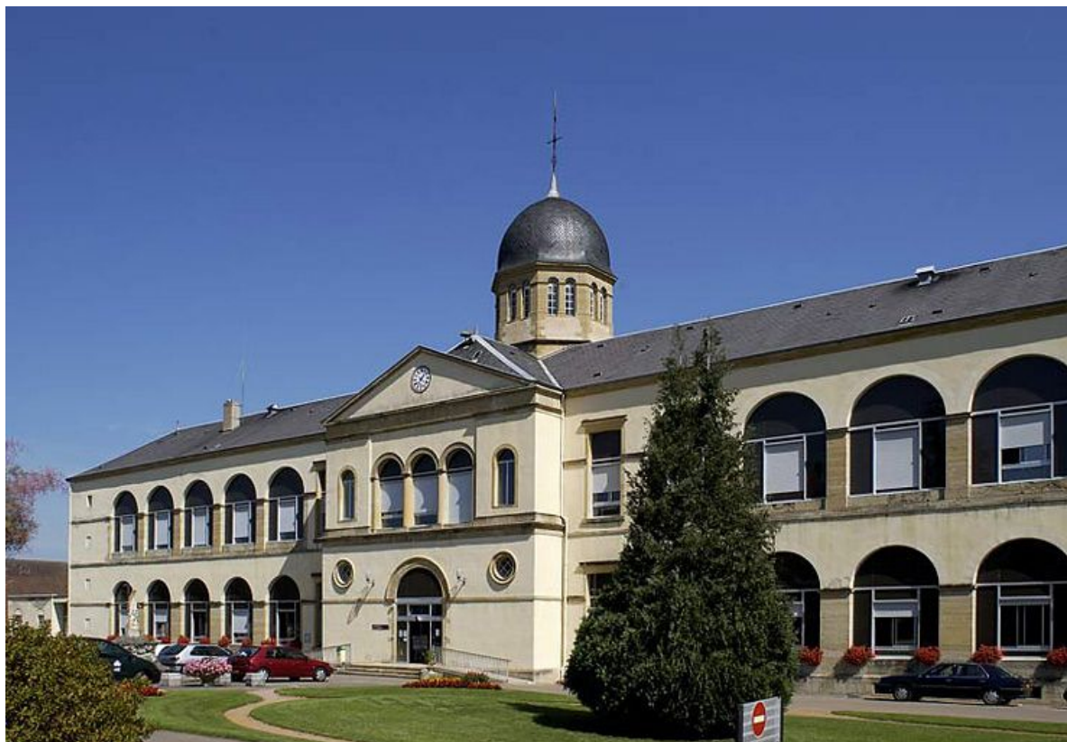
Façade antérieure, vue d'ensemble de la partie gauche.
