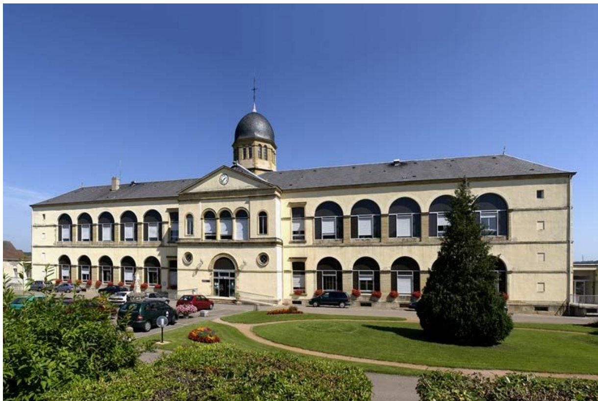
Vue générale de la façade antérieure.
