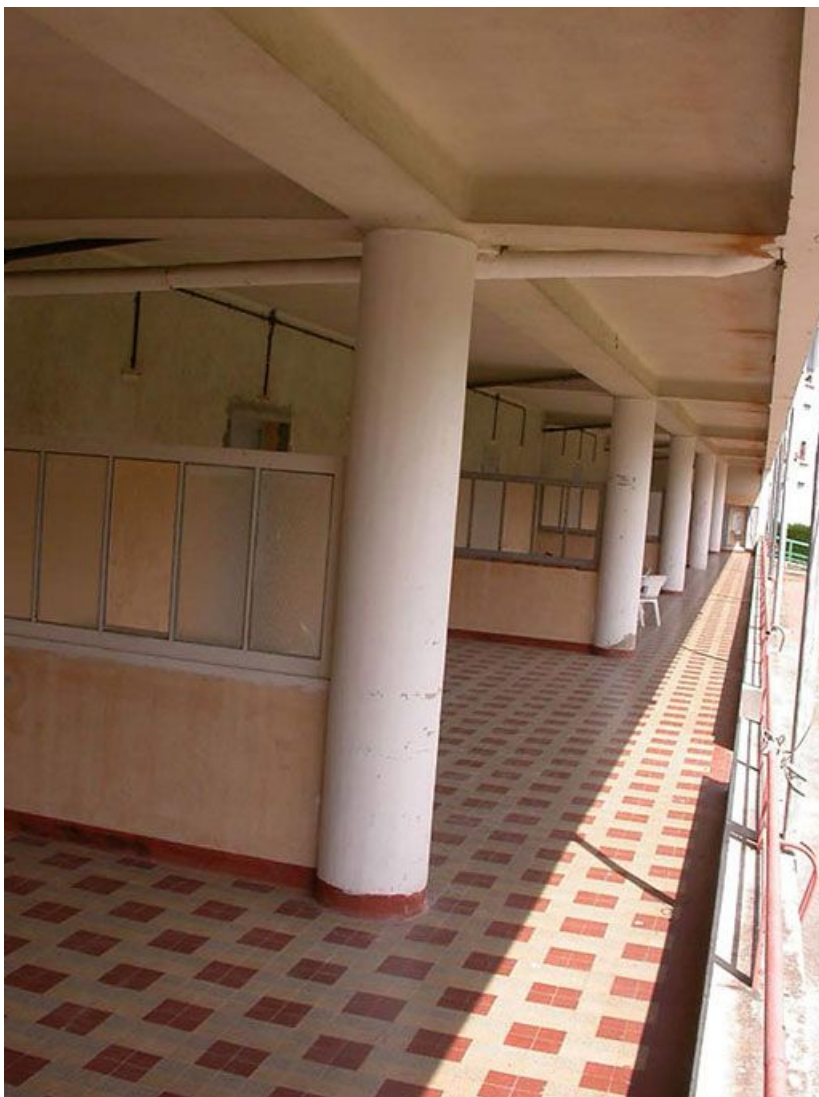
Galerie de cure sud, au rez-de-chaussée : détail des alcôves. 71, Bergesserin Bois de la Châtelaine, lieudit : bois de la Châtelaine
