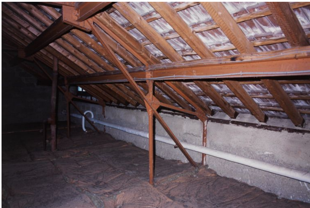
Combles : structure métallique et tuiles plates mécaniques de Saint-Romain.
