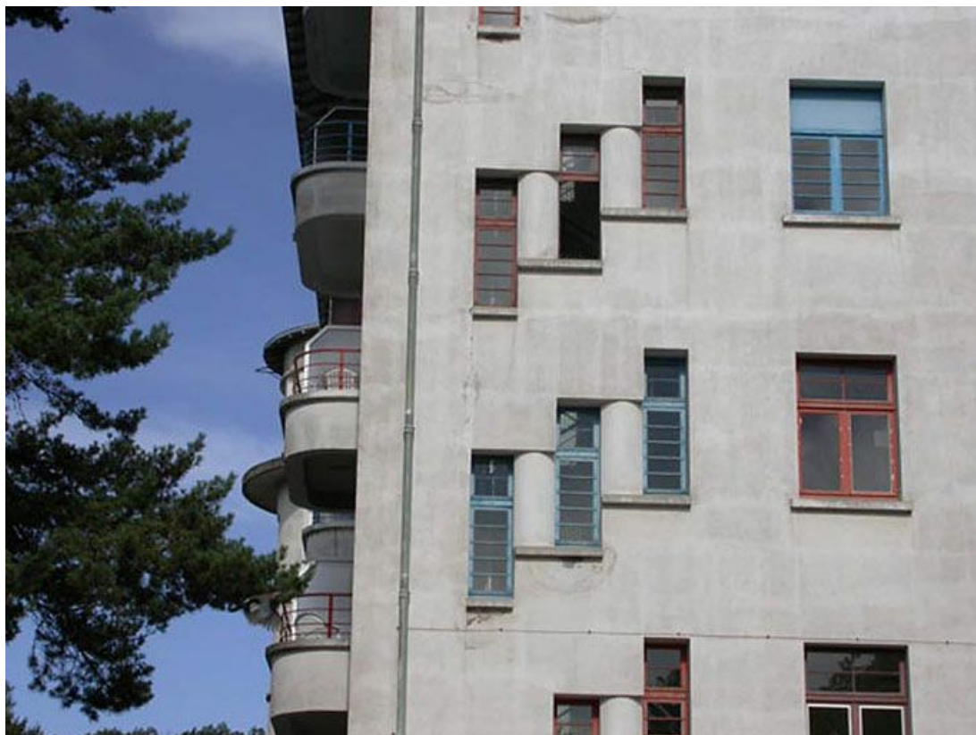
Aile des soins médicaux : vue rapprochée des baies.
