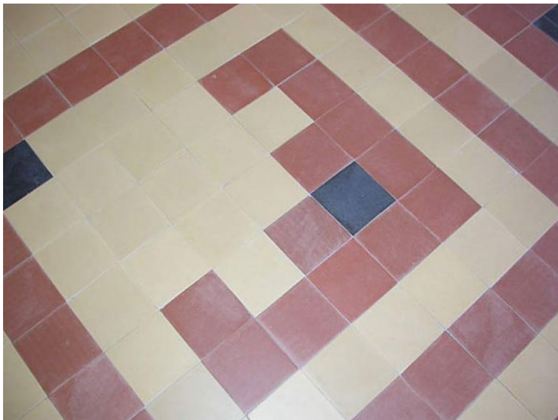
Détail du sol en grès cérame de la salle à manger.
