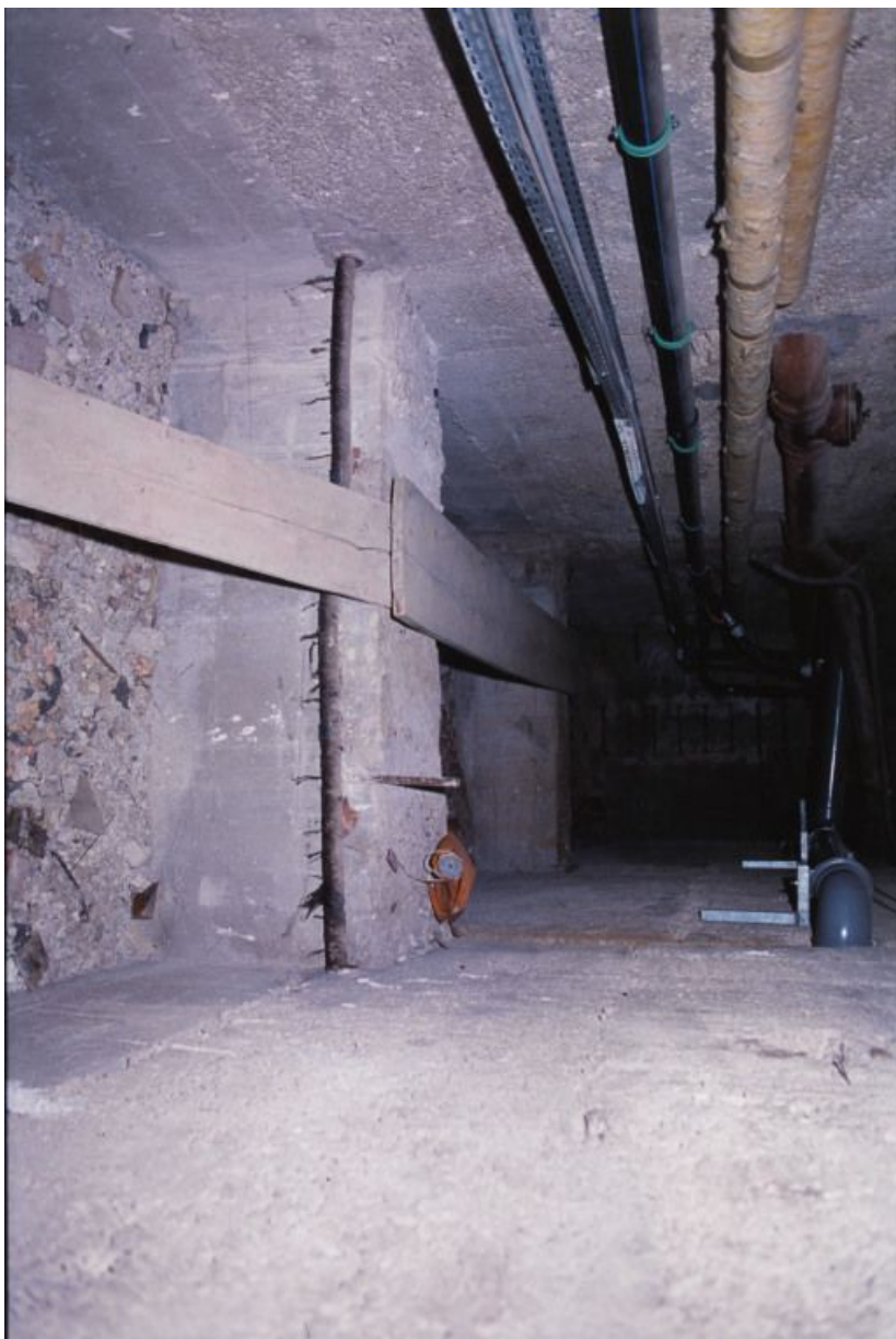
Chaufferie : vue intérieure de la galerie de visite.
