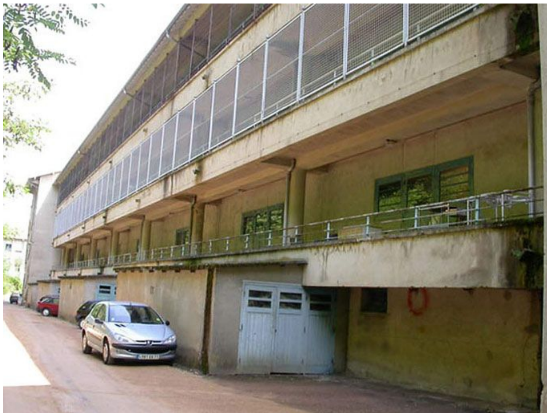
Galerie de cure nord, dite "froide", vue d'ensemble extérieure.
