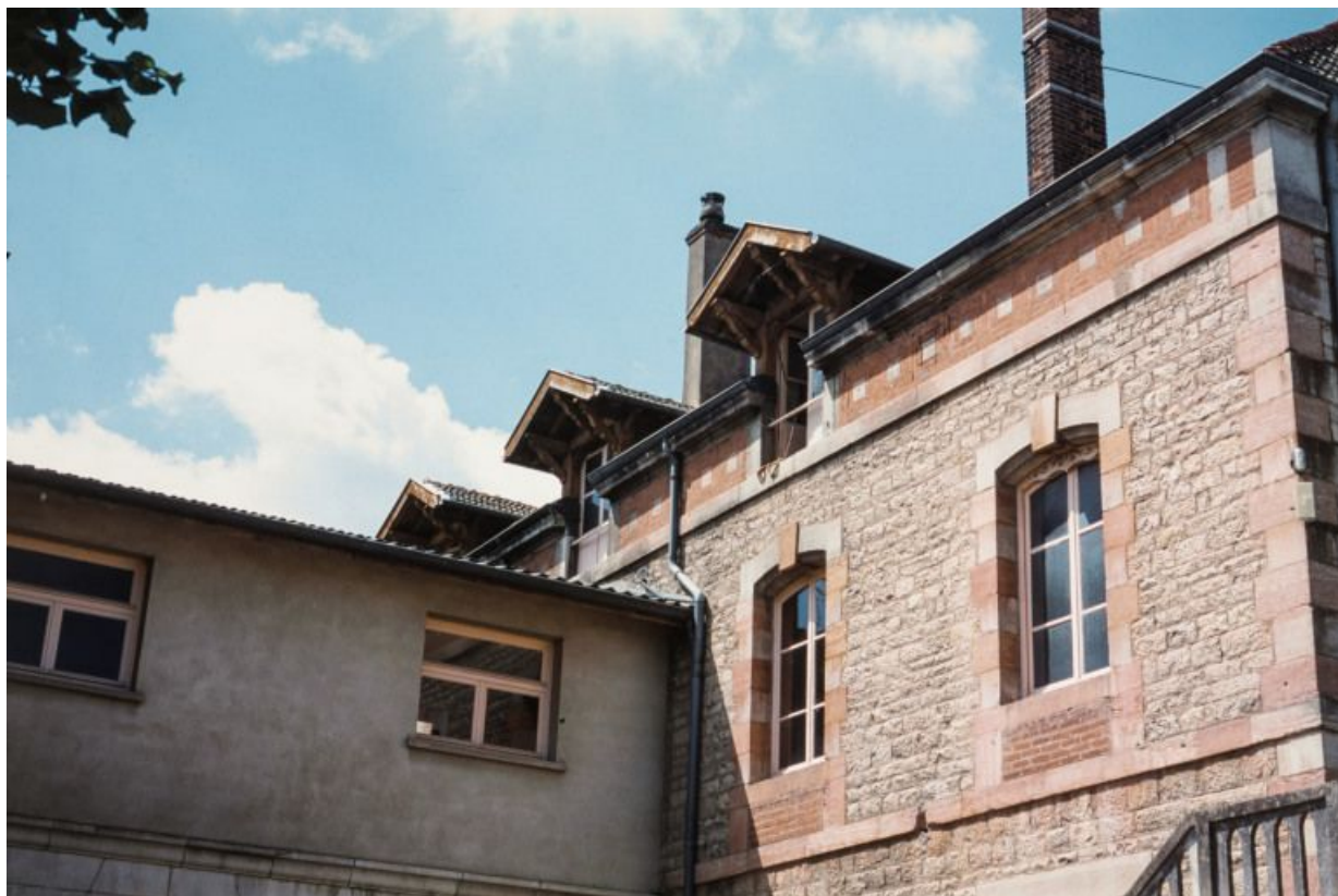
Façade postérieure, détail de 3 lucarnes. 71, Cuisery Hôpital
