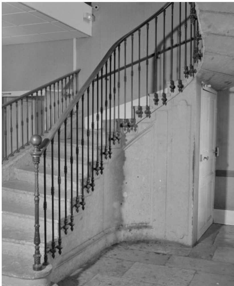
Escalier principal. 71, Cuisery Hôpital
