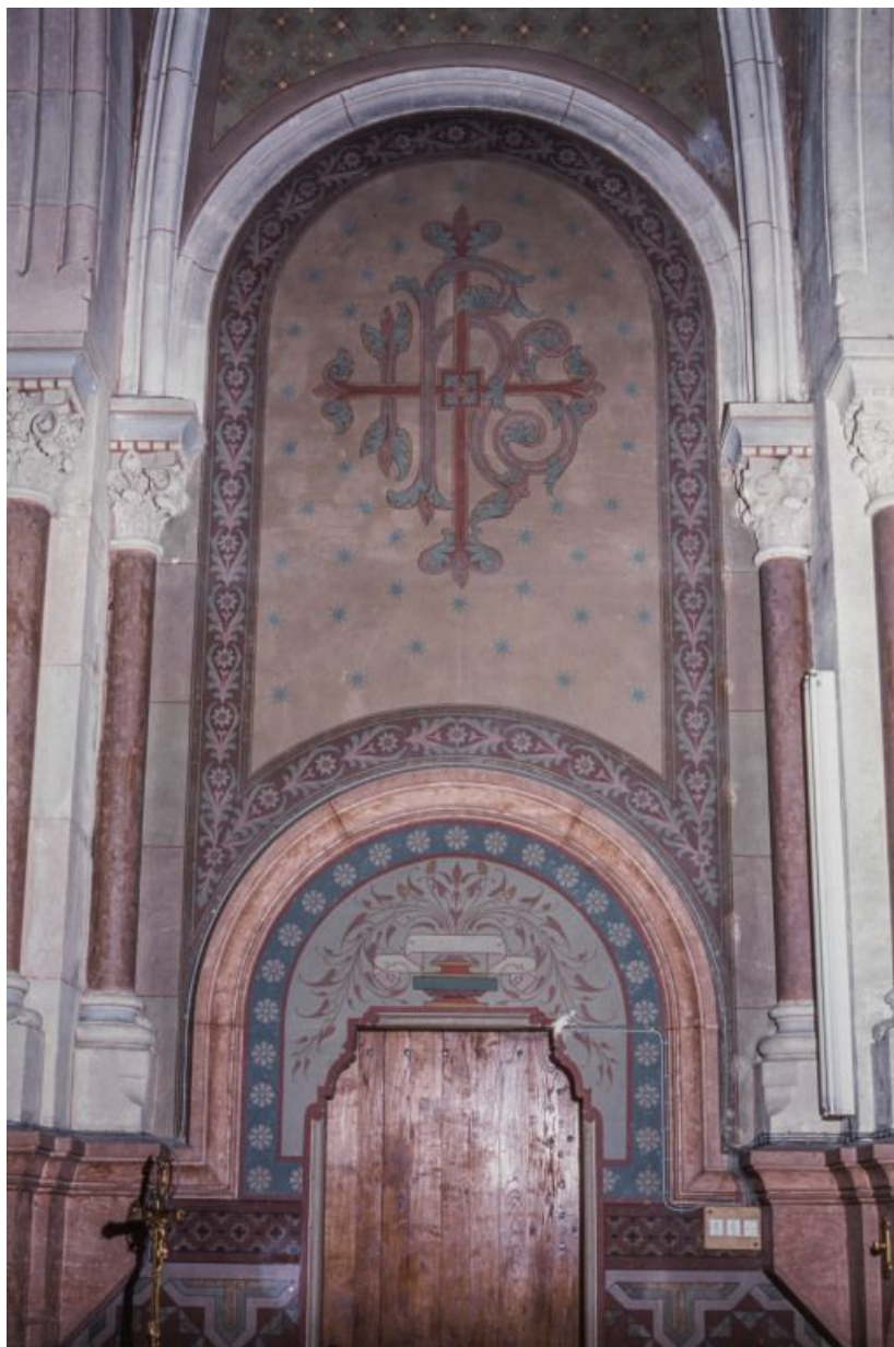
Chapelle, mur du transept droit.
