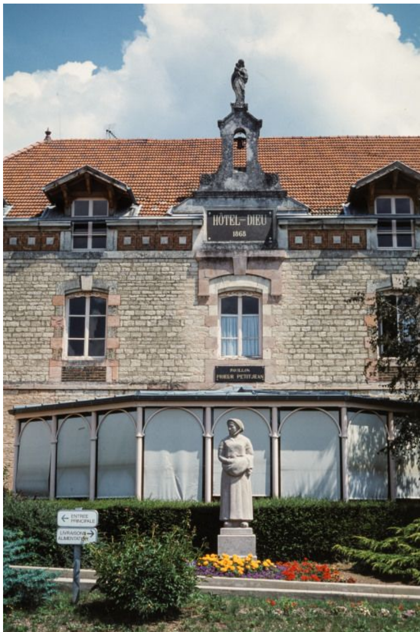
Façade antérieure, pavillon Prieur Petitjean.
