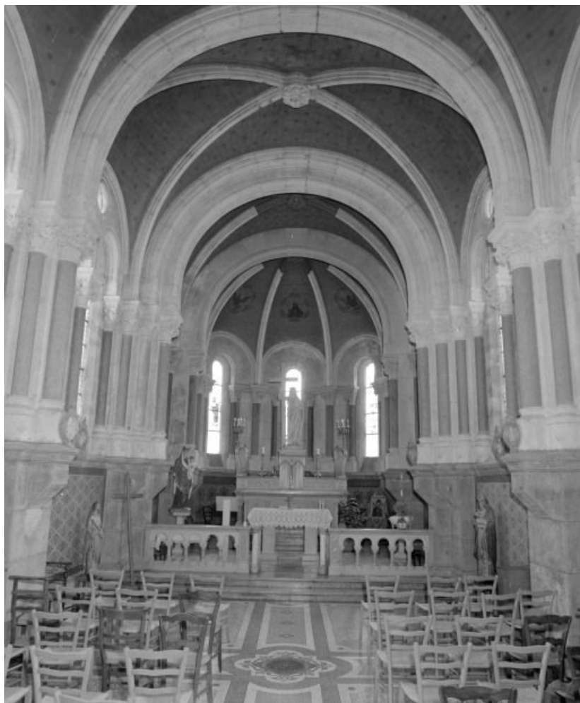
Chapelle, vue d'ensemble de la nef depuis l'entrée.
