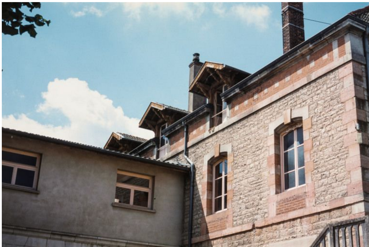
Façade postérieure, détail de 3 lucarnes. 71, Cuisery Hôpital
