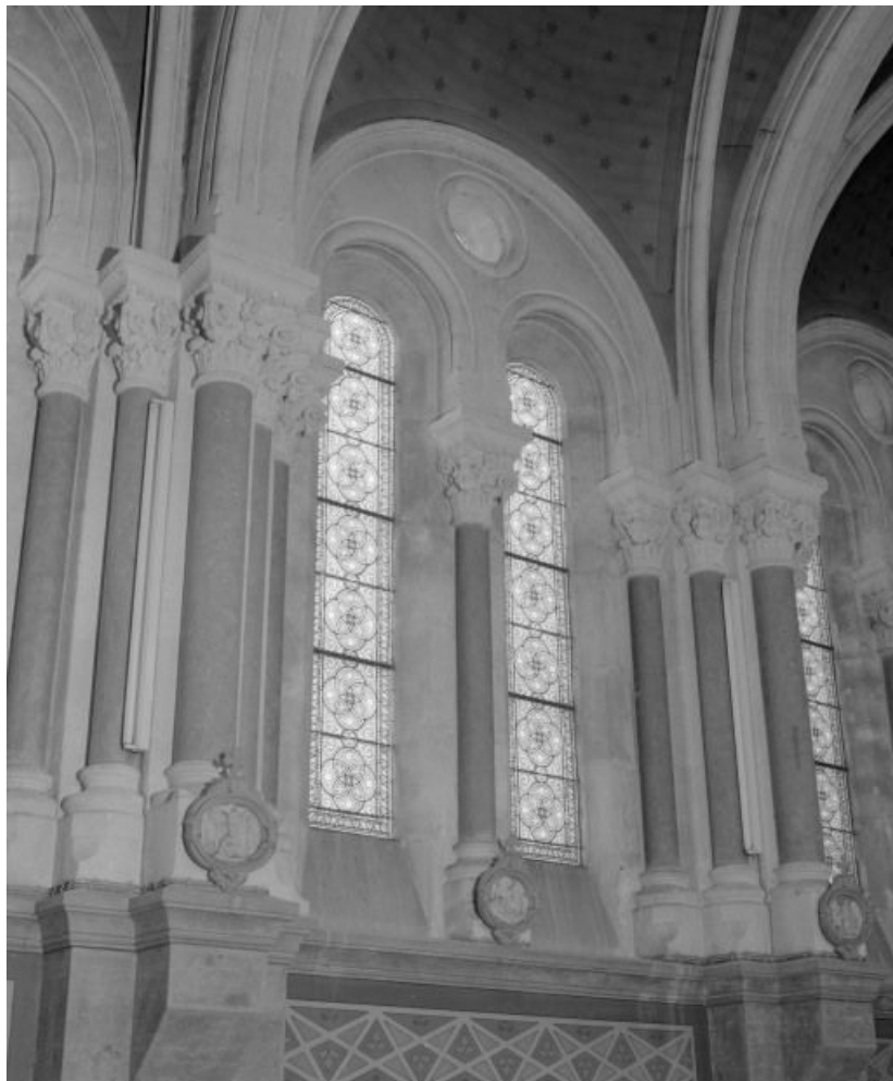
Chapelle, détail d'une baie du bas-côté gauche.
