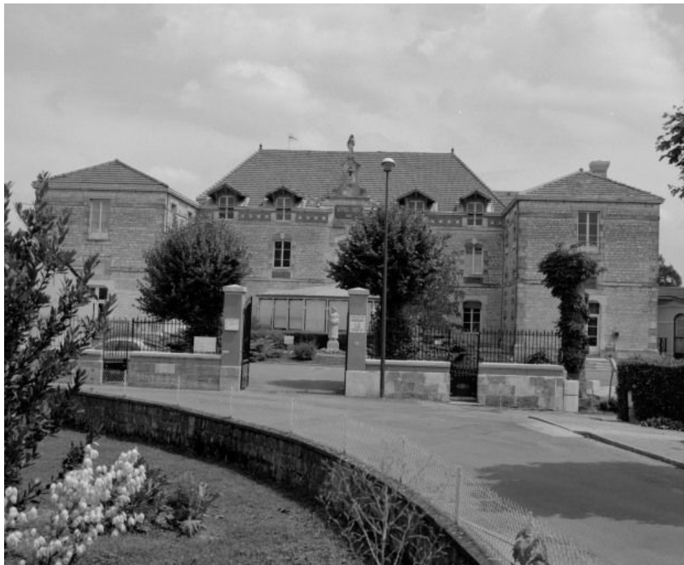
Façade antérieure : vue d'ensemble depuis la rue. 71, Cuisery Hôpital
