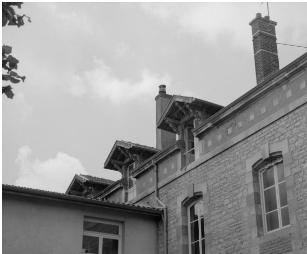
Façade postérieure, détail de 3 lucarnes. 71, Cuisery Hôpital
