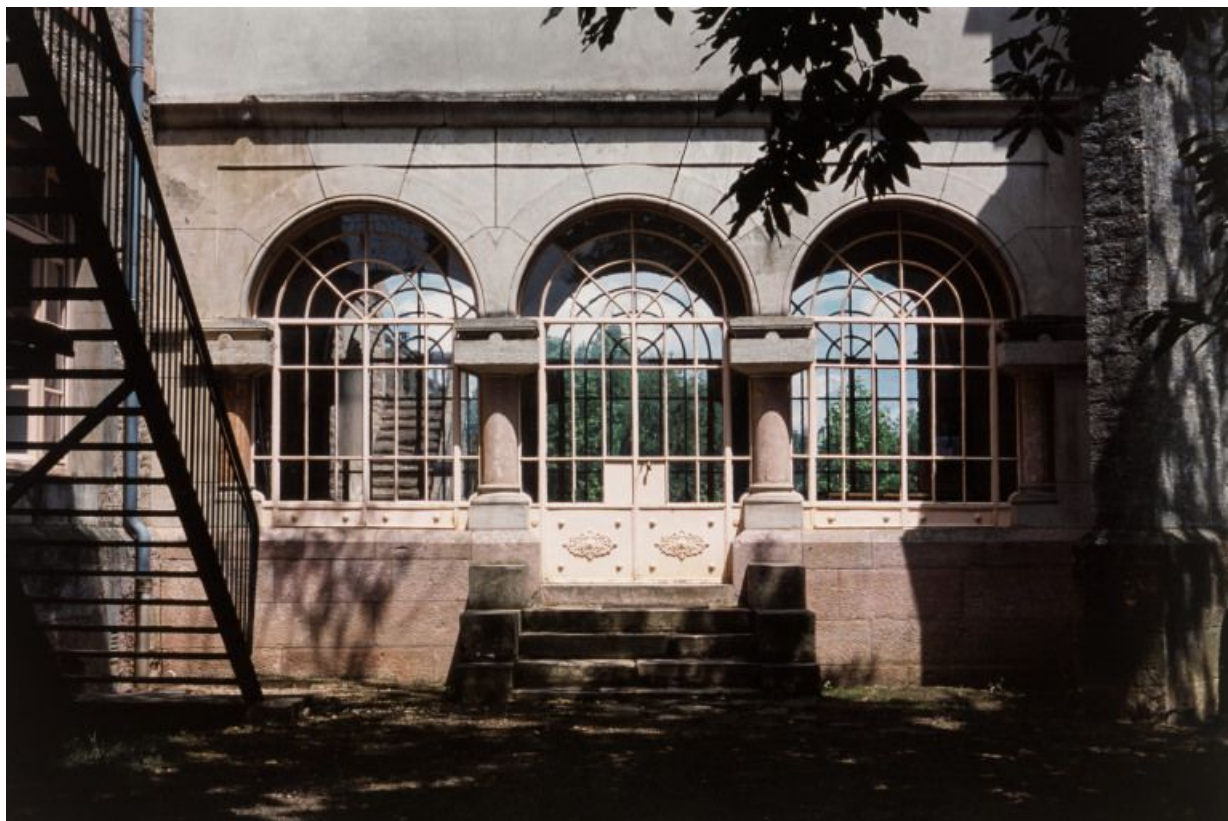
Galerie de liaison vers la chapelle.
