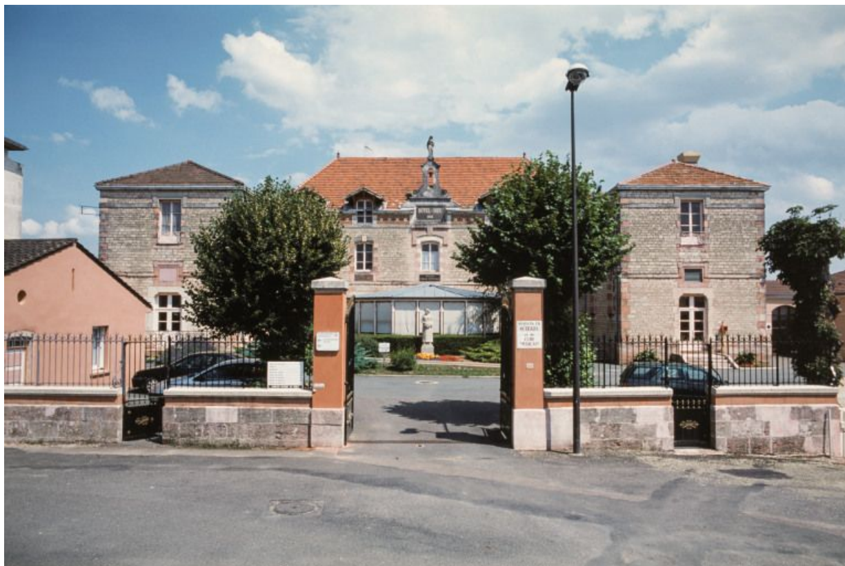
Façade antérieure : vue d'ensemble depuis la rue. 71, Cuisery Hôpital
