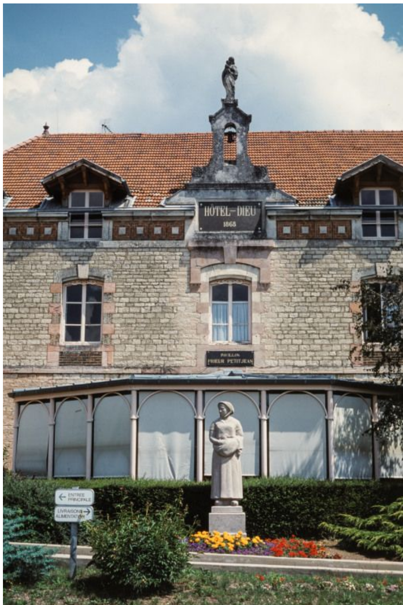
Façade antérieure, pavillon Prieur Petitjean.
