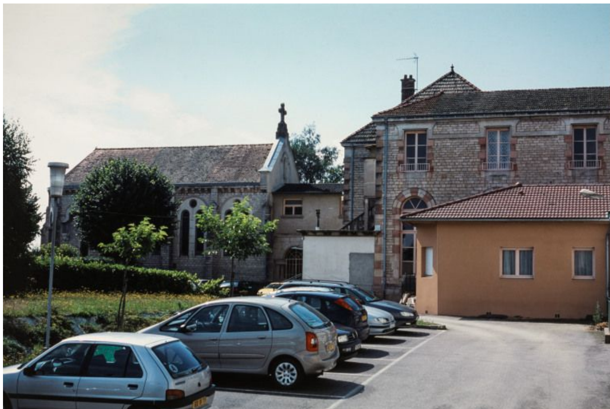
Façade postérieure, vue d'ensemble avec la chapelle. 71, Cuisery Hôpital
