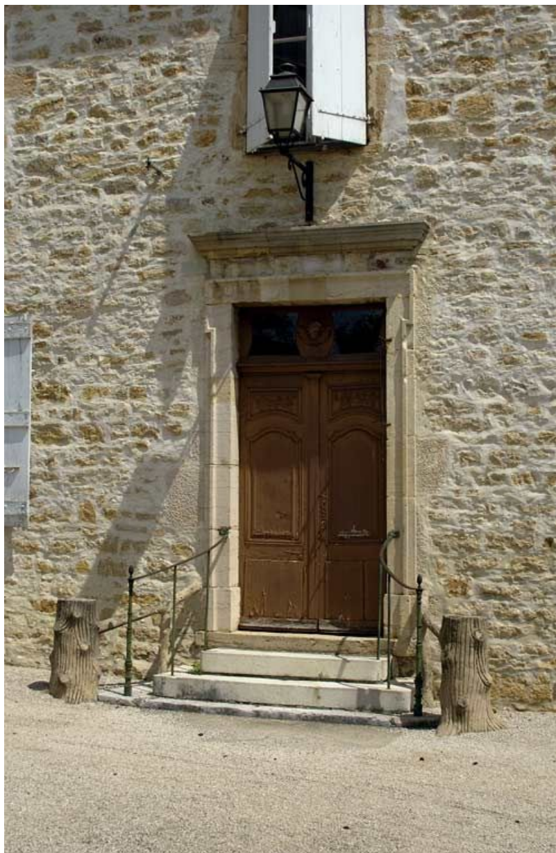
Façade antérieure, détail de l'ancienne porte d'entrée.
