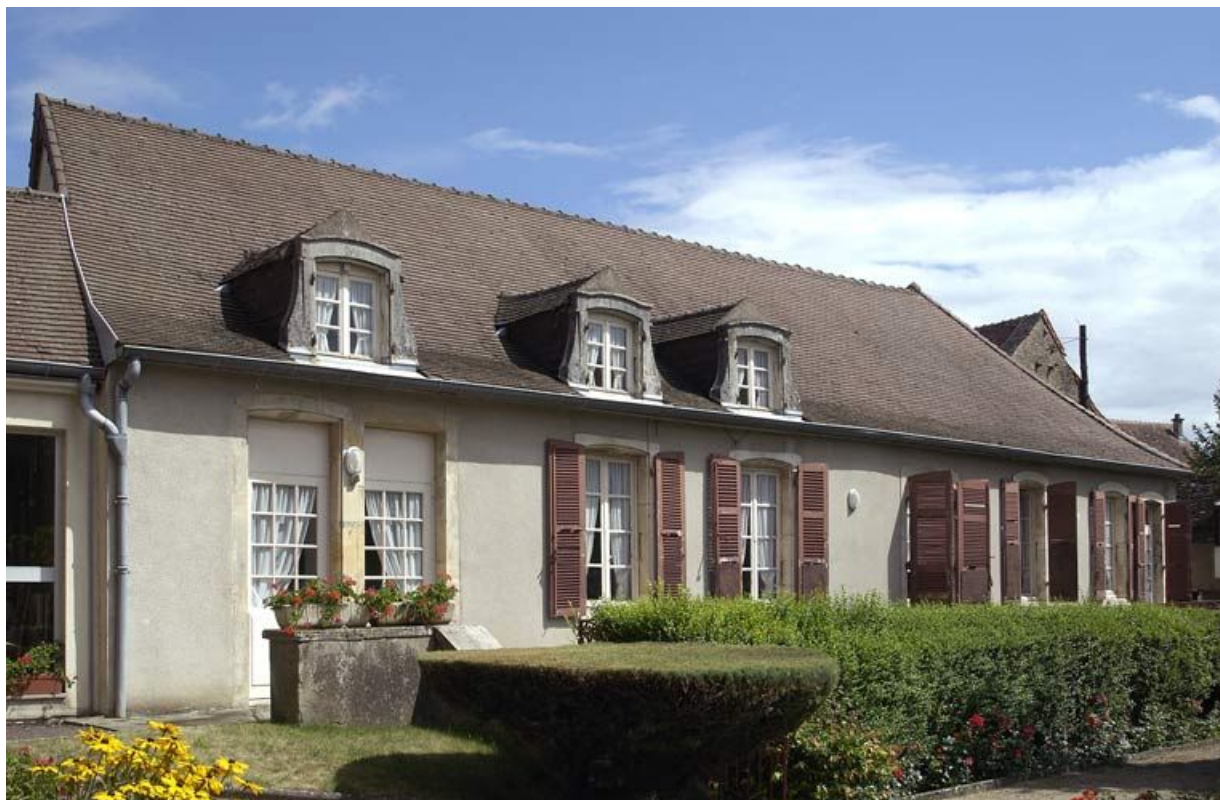
Façade antérieure du bâtiment ancien, vue d'ensemble depuis la cour. 71, Buxy Maréchaux
