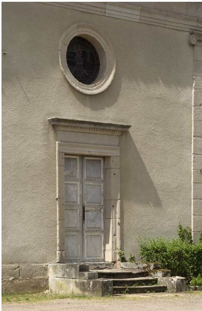
Porte de la chapelle surmontée d'un oculus.
