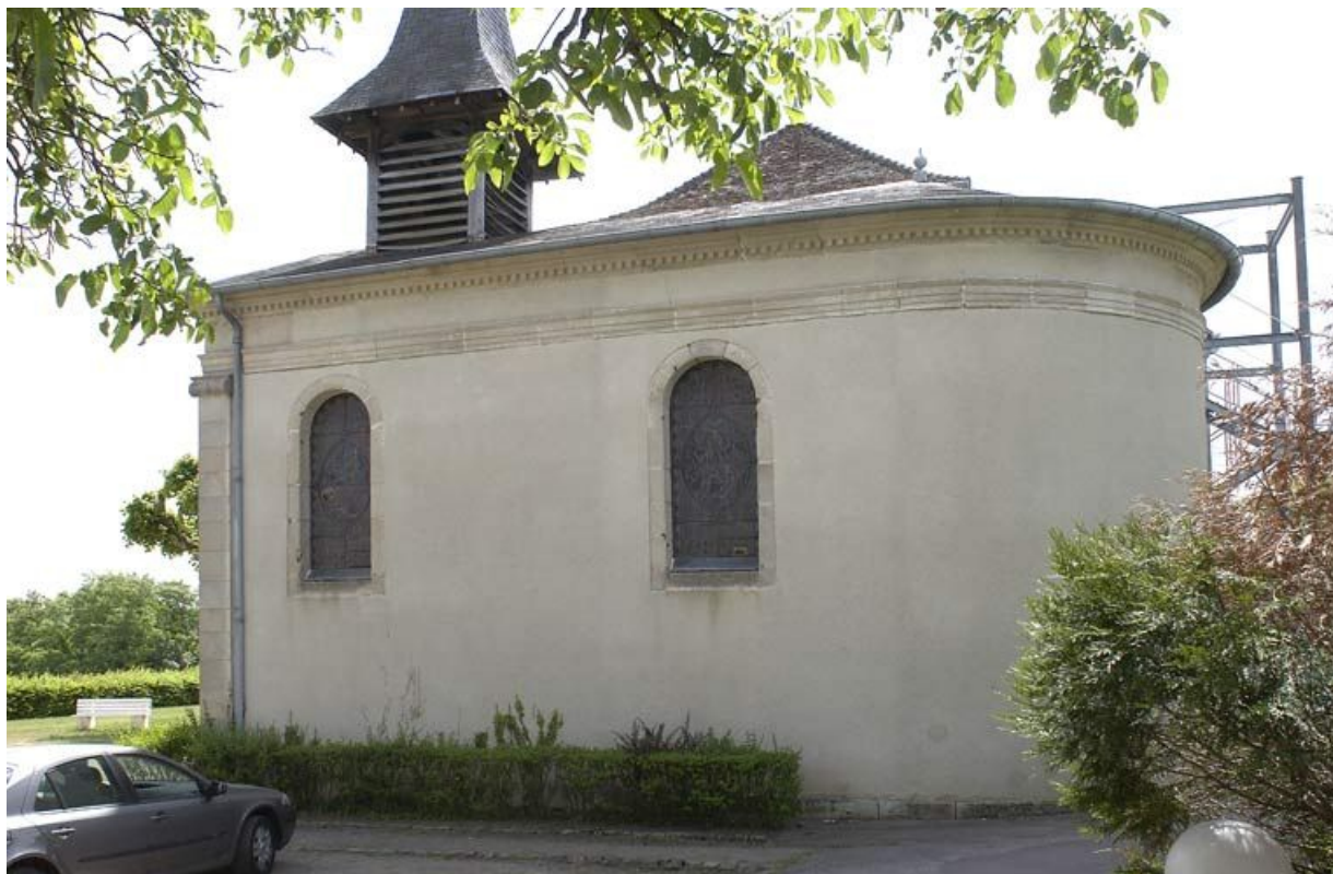
Façade sud et chevet de la chapelle.
