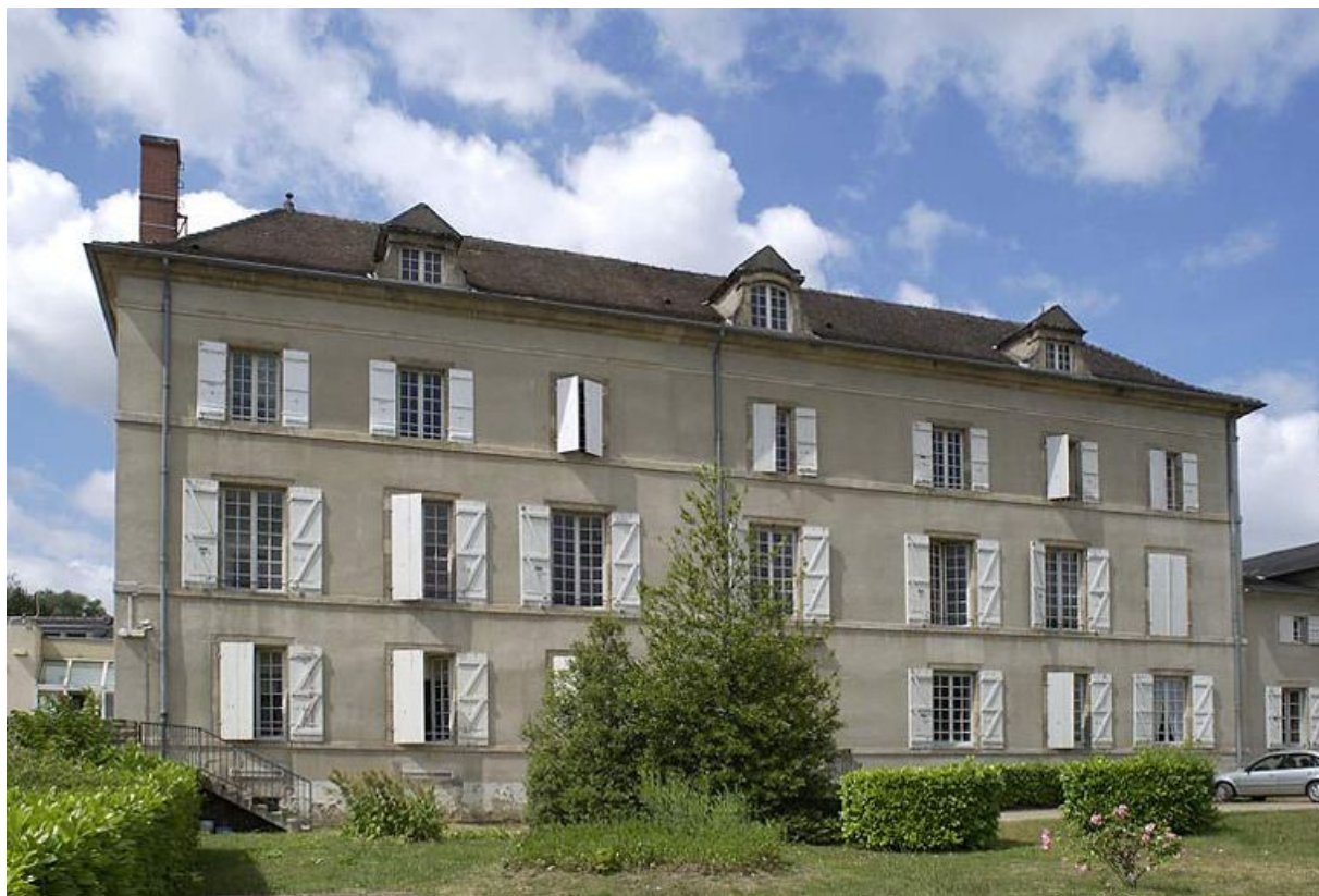
Vue d'ensemble de la façade antérieure.
