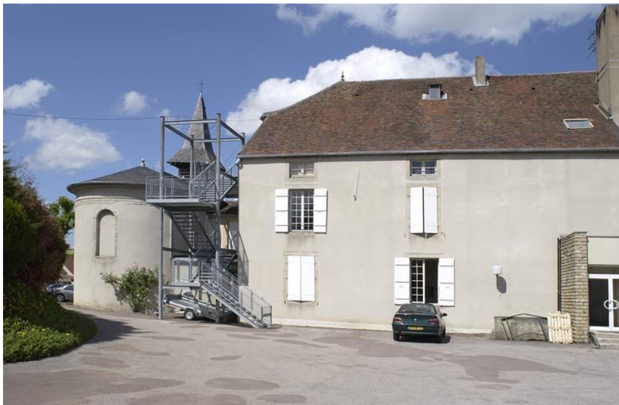
Partie gauche de la façade postérieure et chevet de la chapelle.
