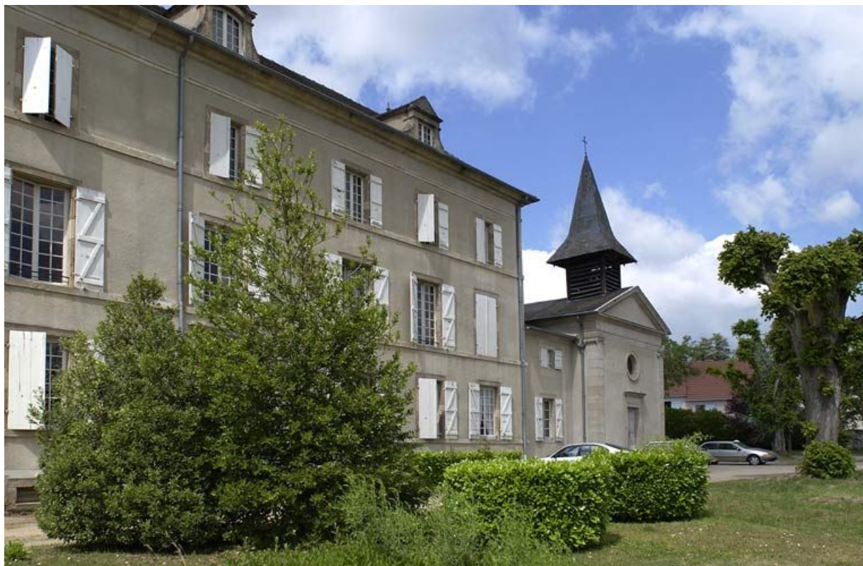
Partie droite de la façade antérieure et chapelle.
