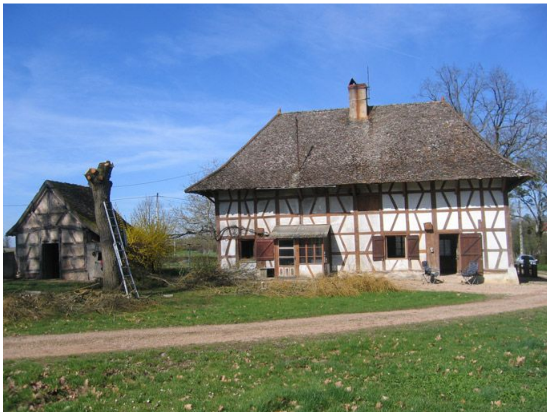
Vue d'ensemble de la façade de l'habitation.
