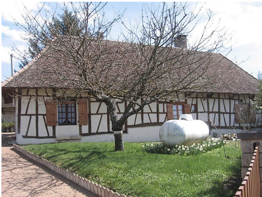
Vue d'ensemble de la façade de l'habitation.
