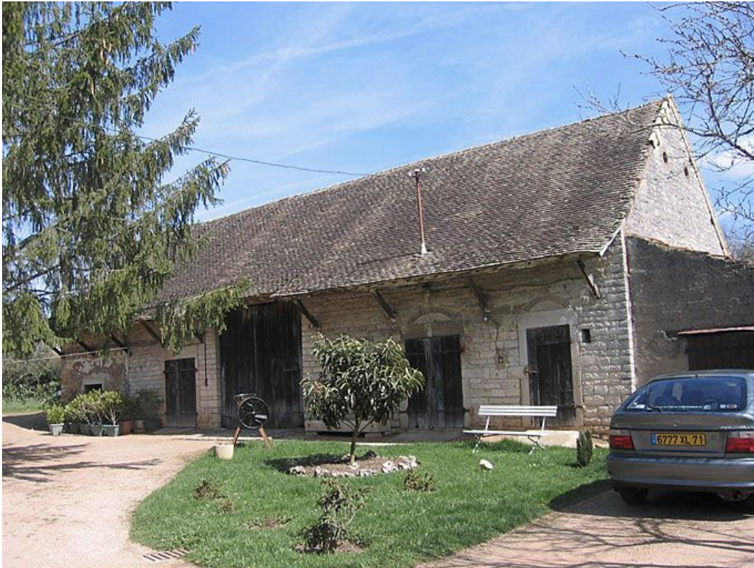
Vue d'ensemble de la façade du bâtiment des dépendances. 71, Baudrières
