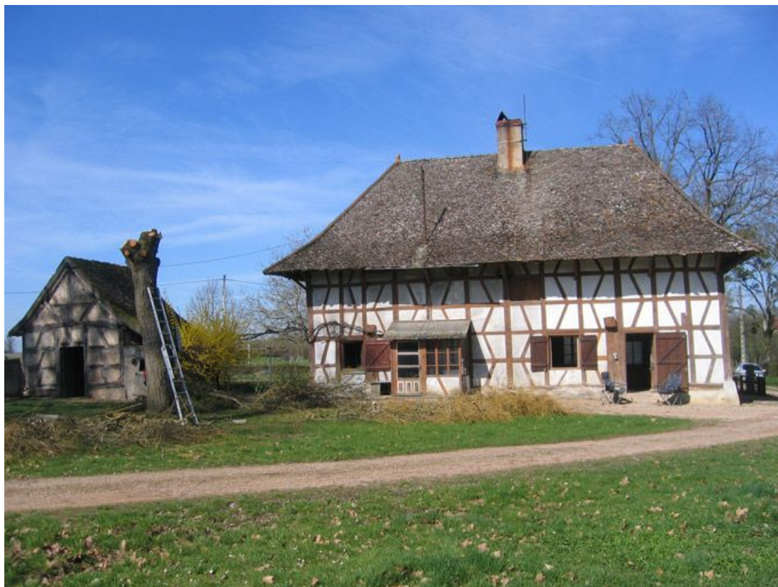
Vue d'ensemble de la façade de l'habitation.
