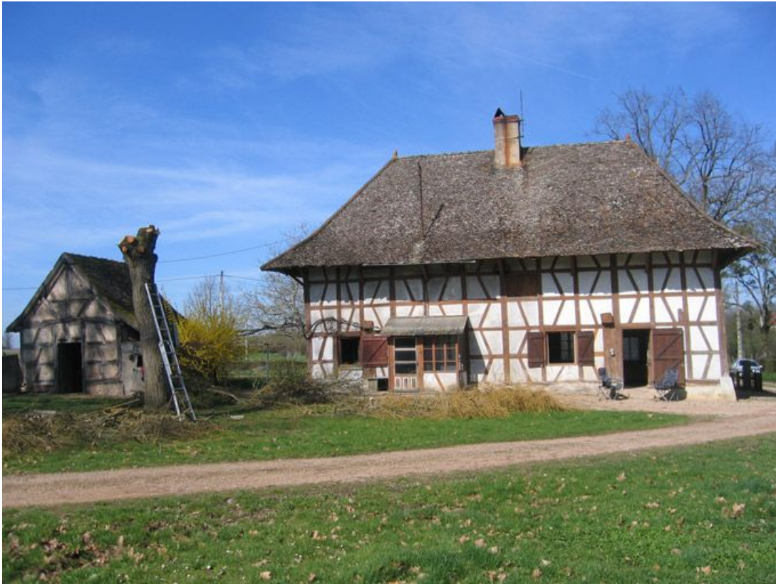
Vue d'ensemble de la façade de l'habitation.
