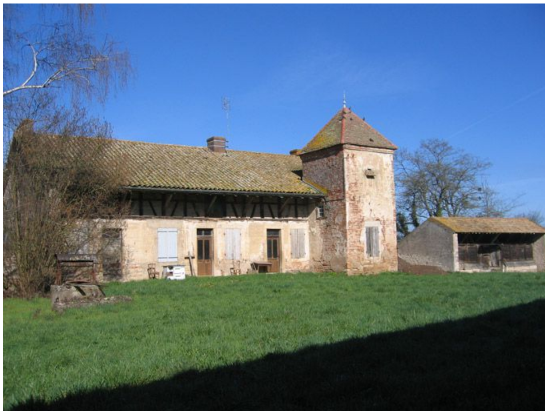
Vue d'ensemble de la façade de l'habitation.
