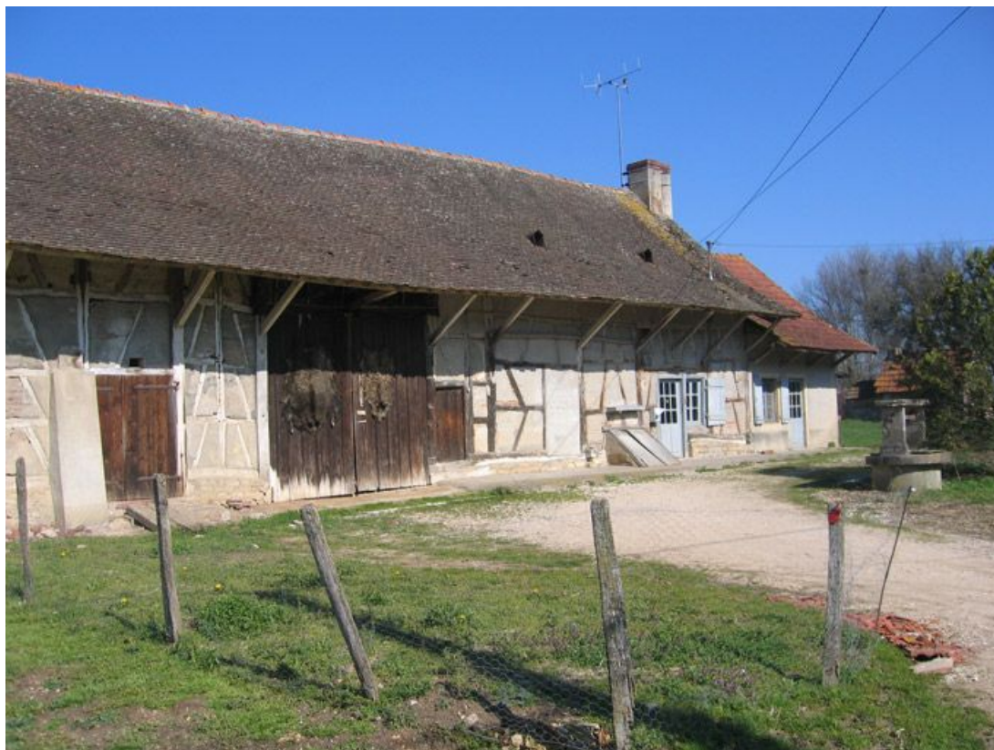
Vue d'ensemble de la façade.
