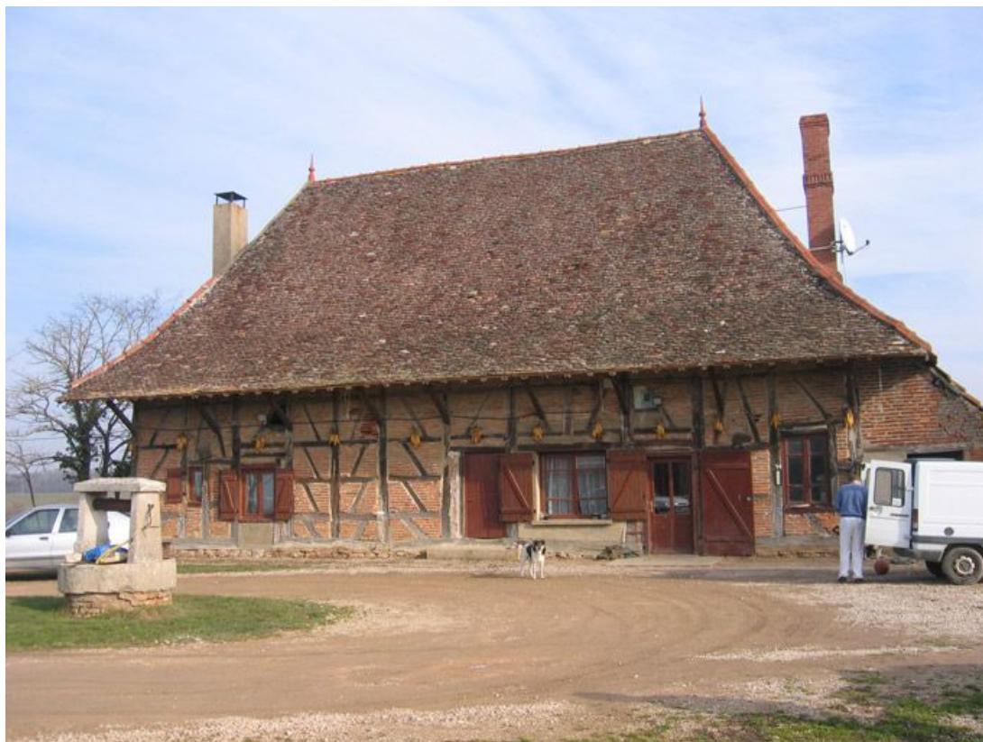
Vue d'ensemble de la façade de l'habitation.
