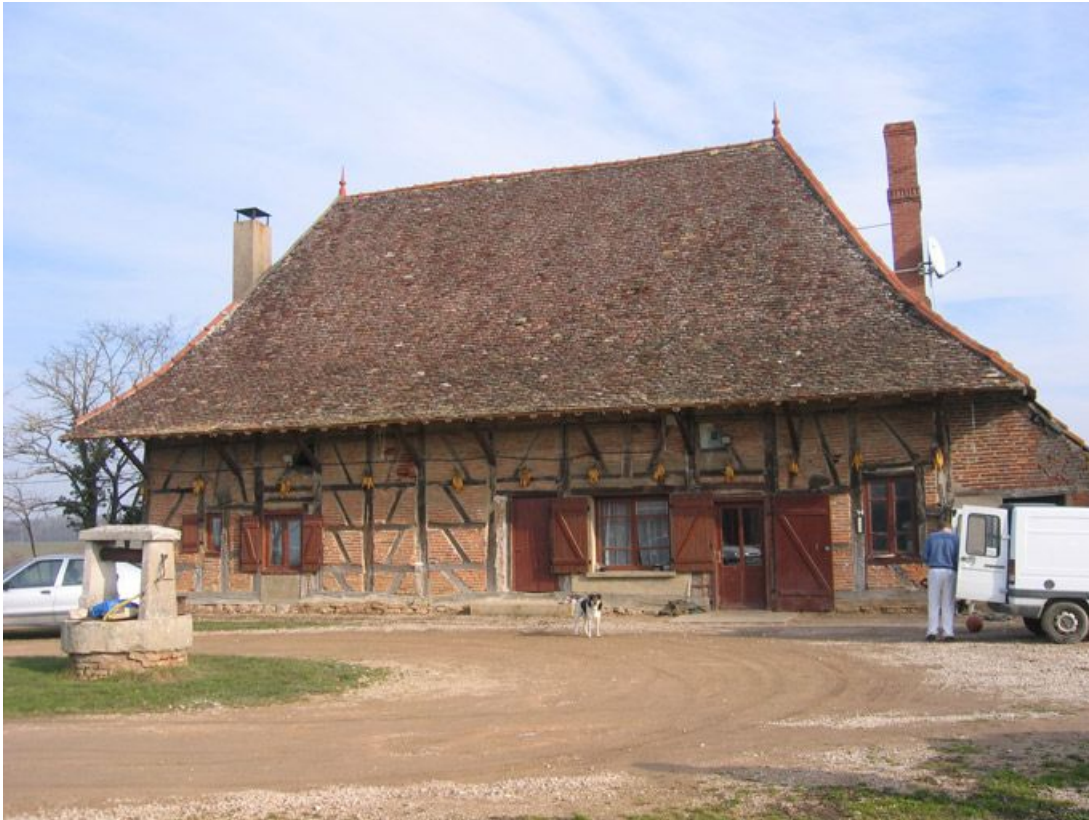
Vue d'ensemble de la façade de l'habitation. 71, Tronchy
