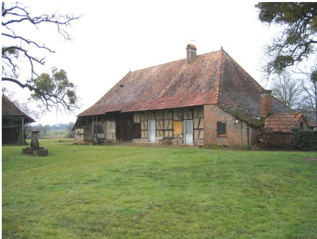
Vue d'ensemble de la façade.
