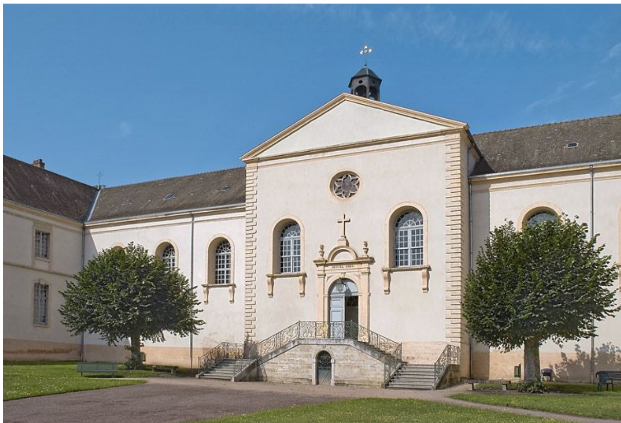
Façade antérieure du bâtiment principal.
