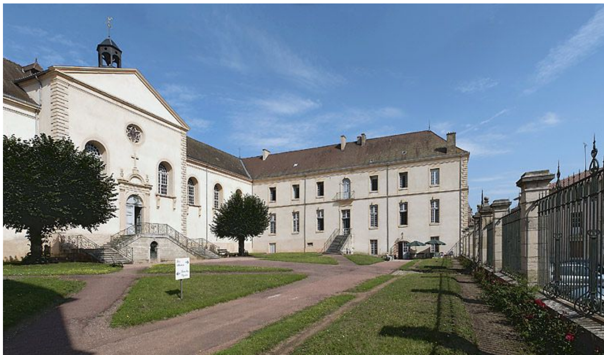
Vue d'ensemble de la façade principale et de l'aile droite.
