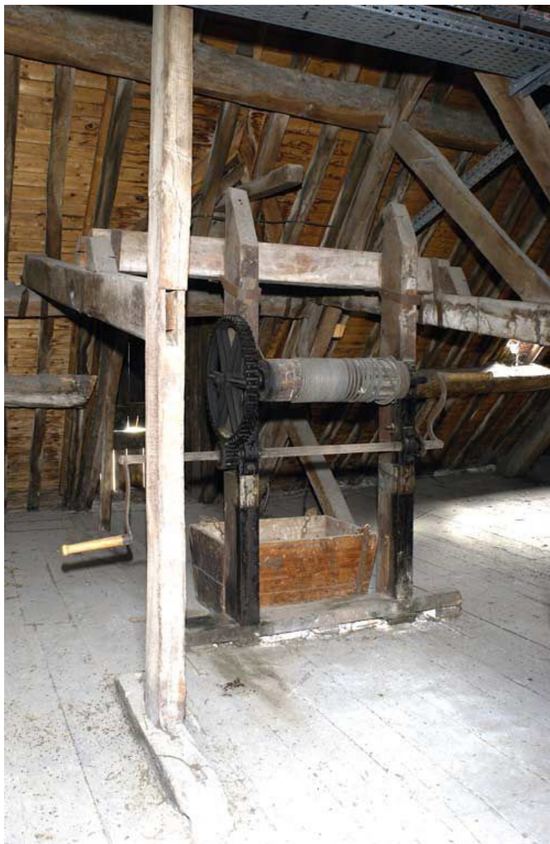
Grenier de l'aile gauche, instrument de levage du linge à sécher.
