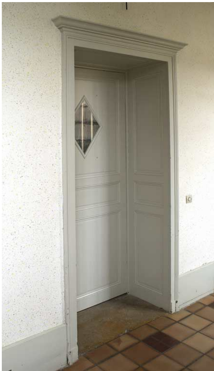
Porte d'une ancienne salle (aile gauche, premier étage).
