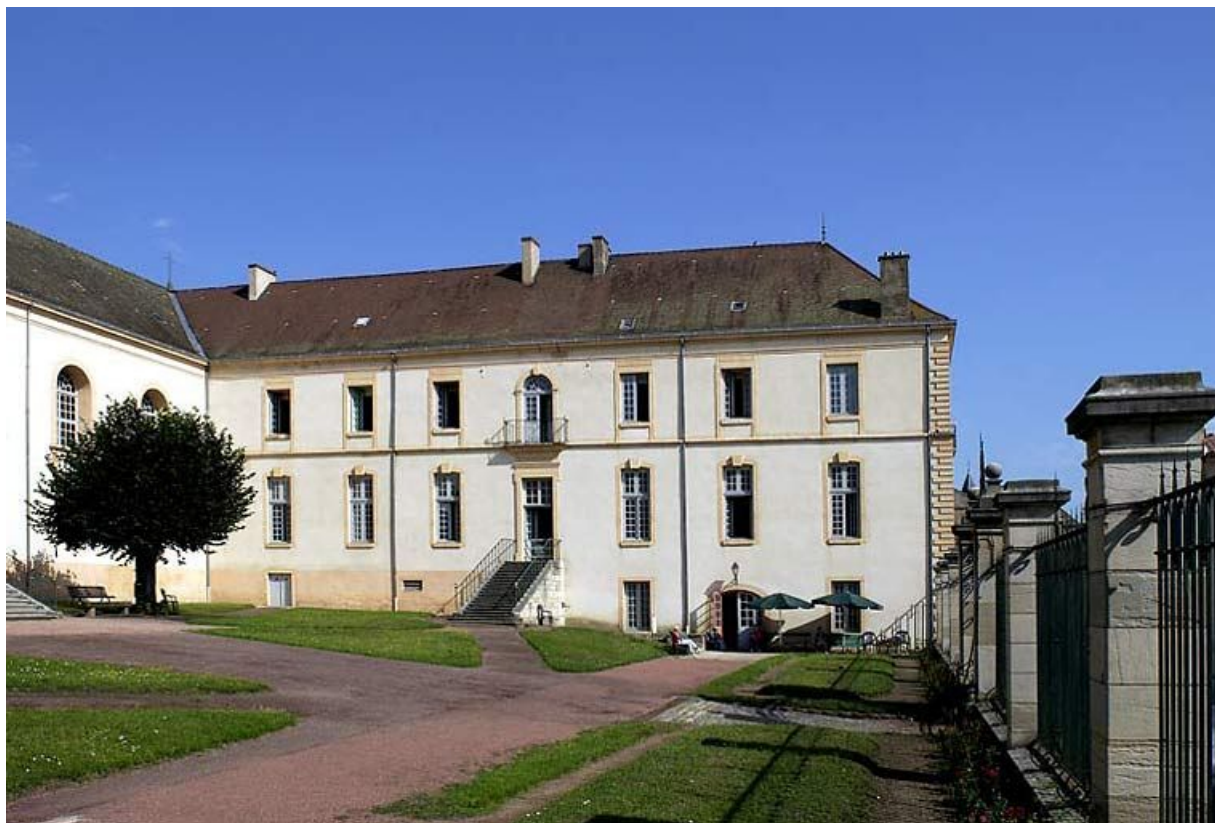
Aile droite, vue d'ensemble de la façade antérieure.
