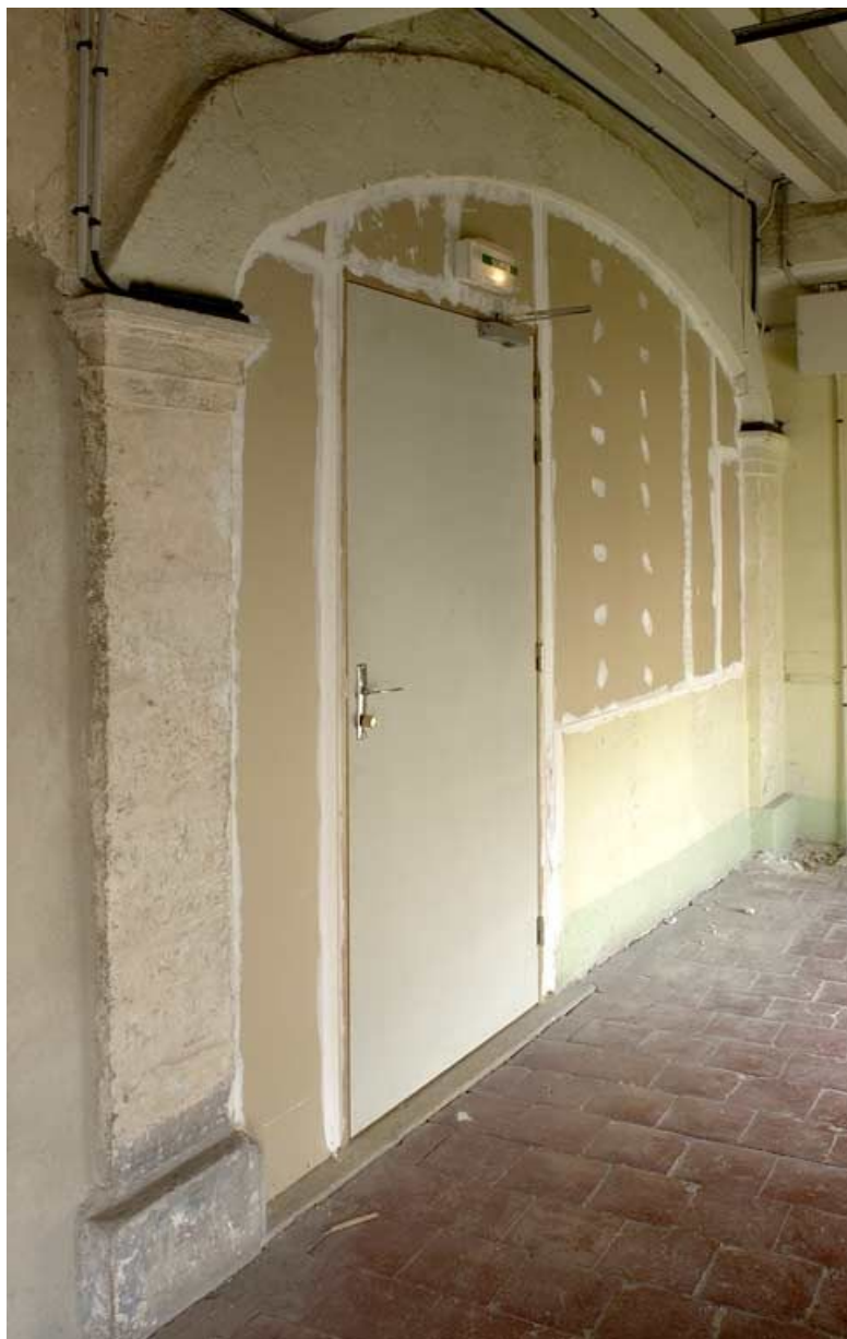
Etage de comble de l'aile gauche, détail d'une ancienne porte condamnée. 71, Cluny, 13 place de Hôpital
