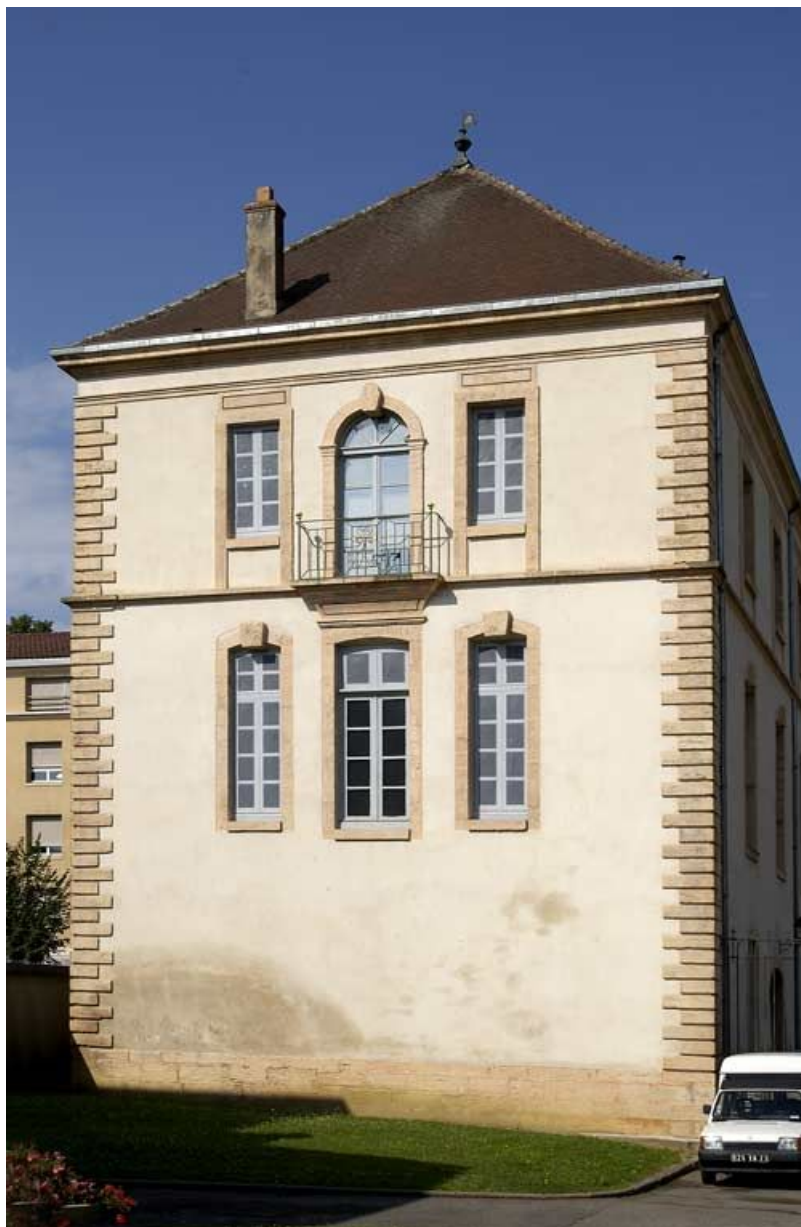
Aile gauche, vue rapprochée des percements du pignon.
