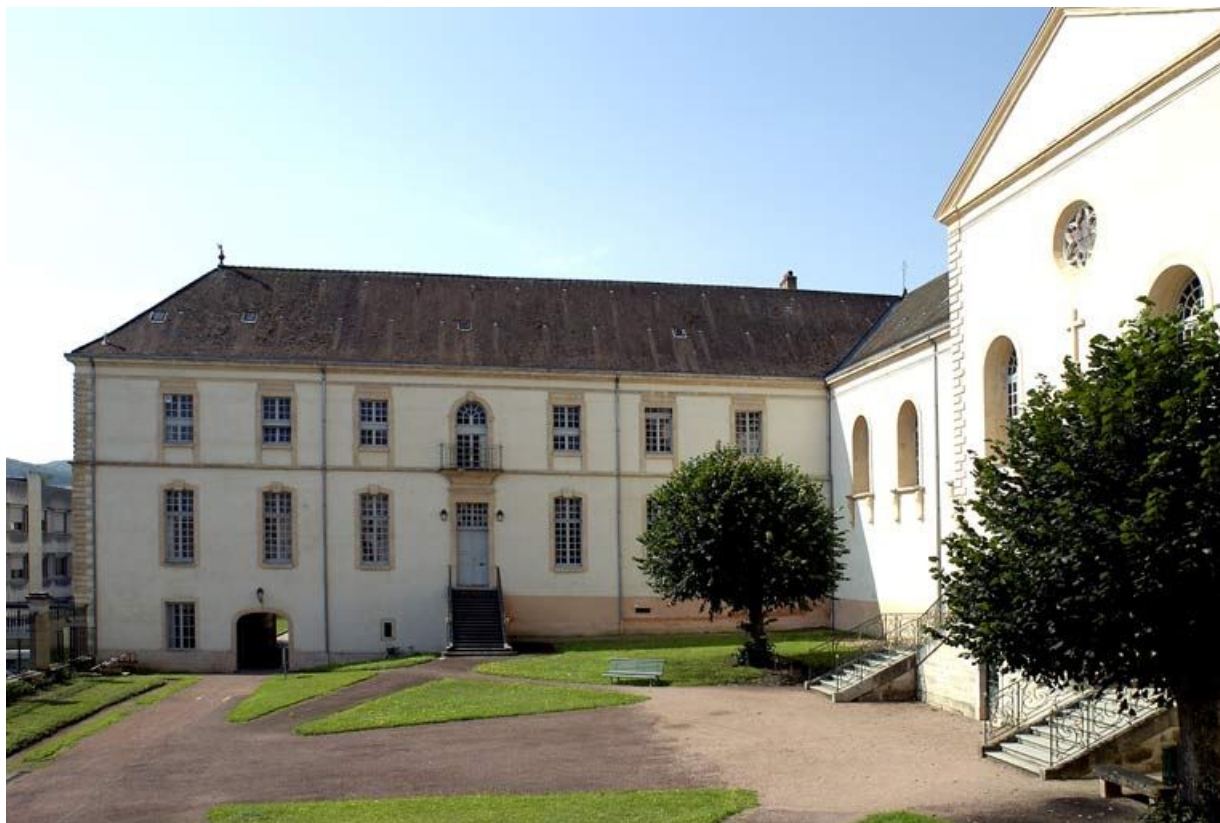
Aile gauche et bâtiment principal.
