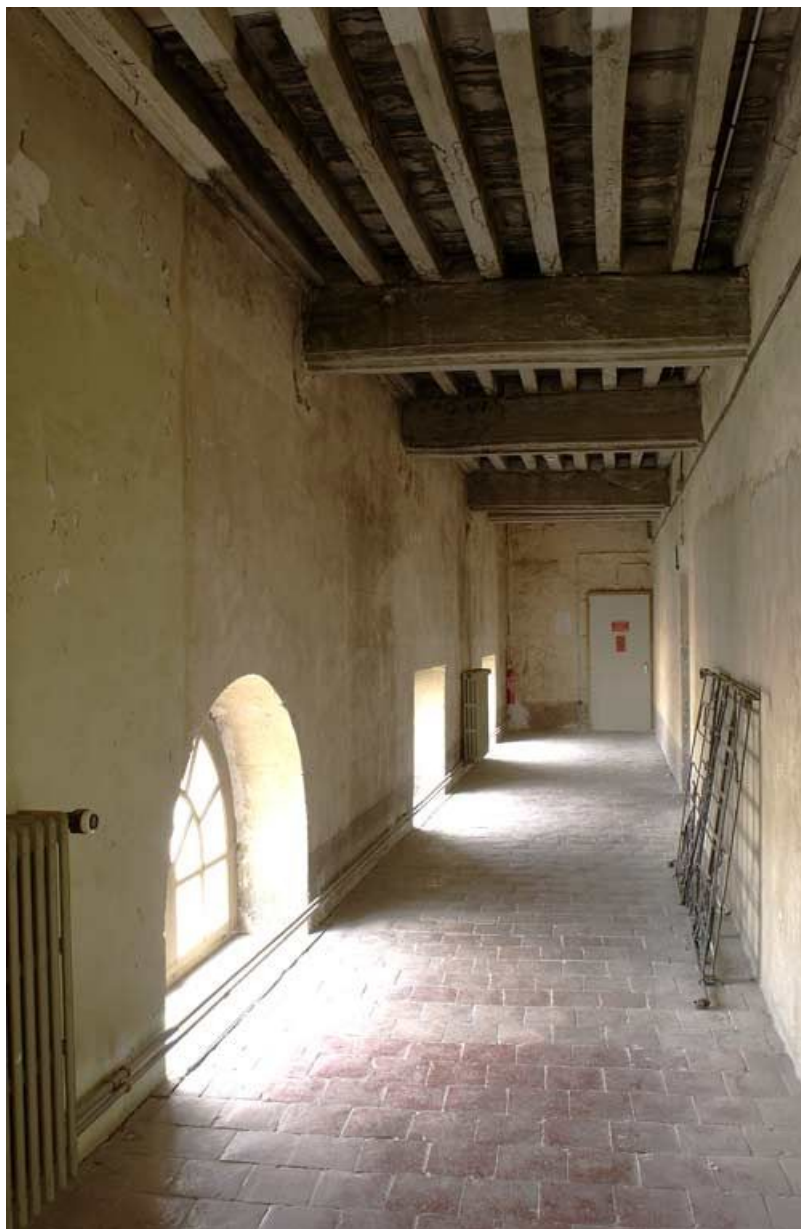
Etage de comble de l'aile gauche, vue d'ensemble.
