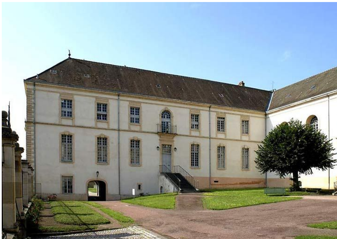
Aile gauche (sud), façade antérieure.
