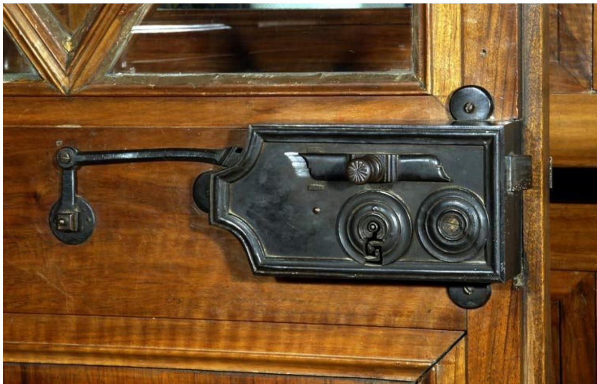
Apothicaiererie, détail de la serrure de la porte d'entrée.
