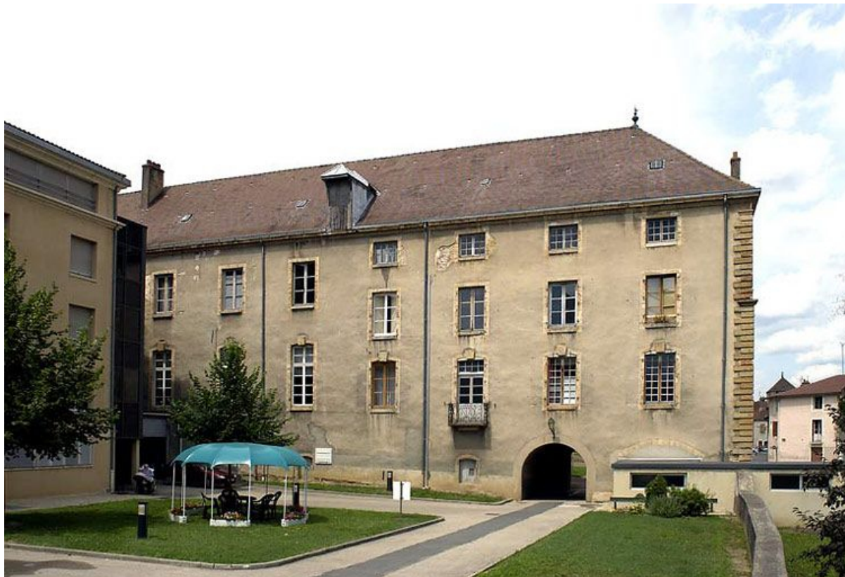
Aile gauche, façade postérieure.
