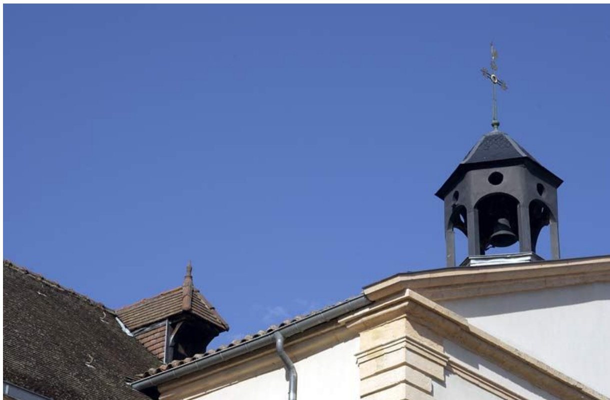
Détail du clocheton de la chapelle.
