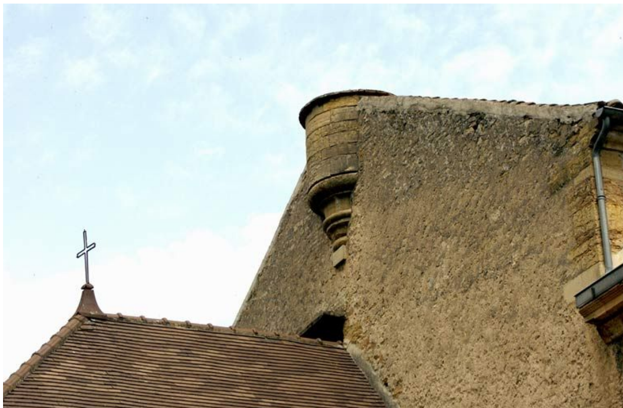
Abside de la chapelle, détail de la tourelle d'escalier.
