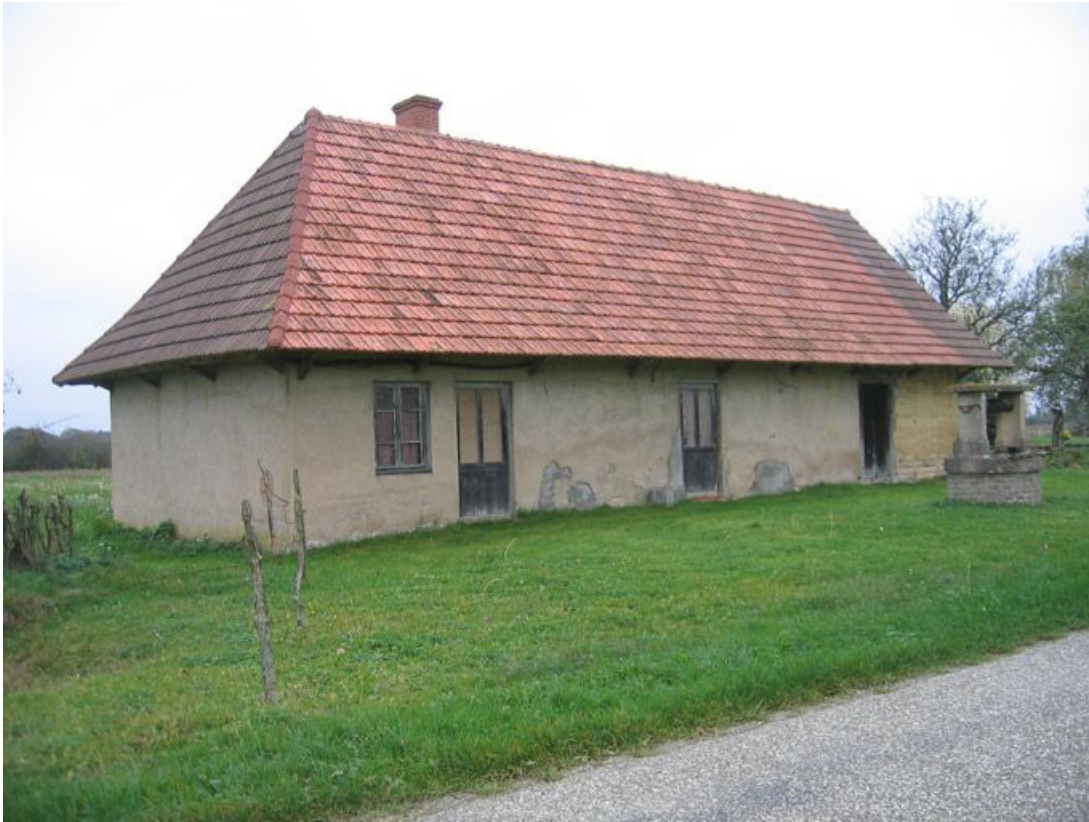
Vue d'ensemble de la façade de l'habitation.
