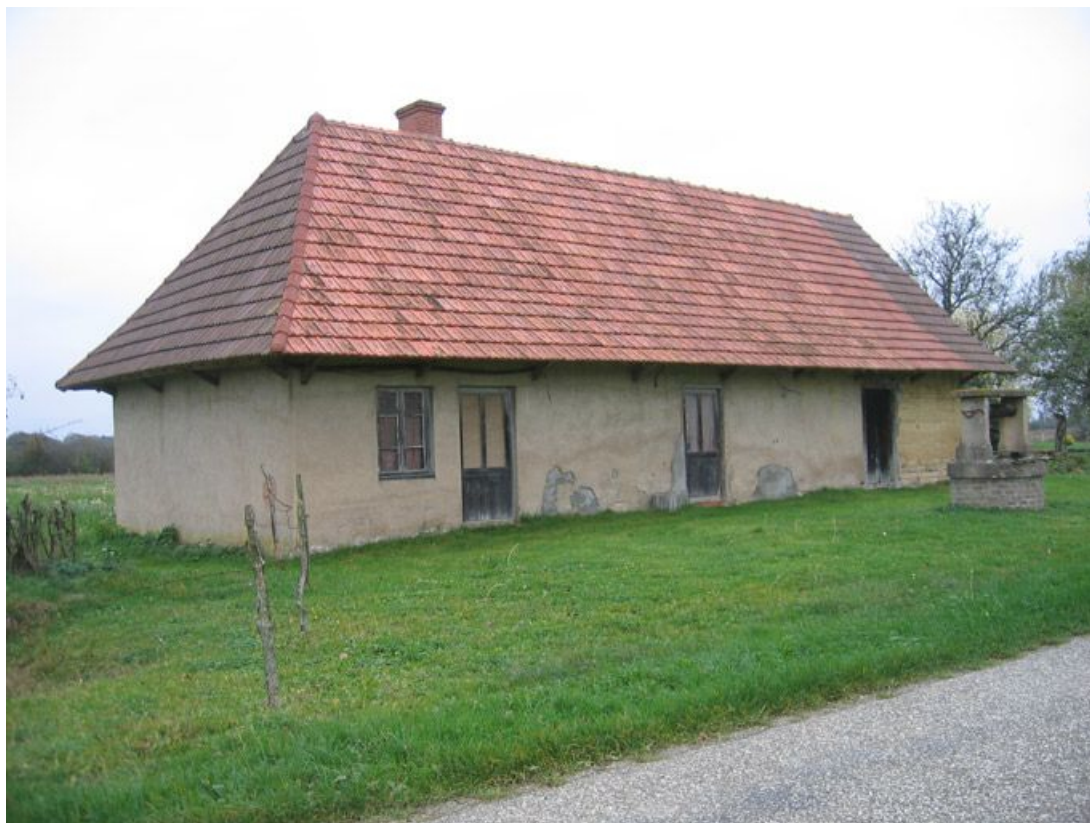
Vue d'ensemble de la façade de l'habitation.
