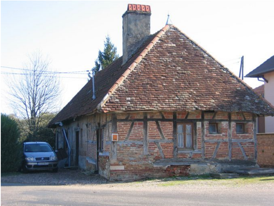
Vue d'ensemble de la façade.
