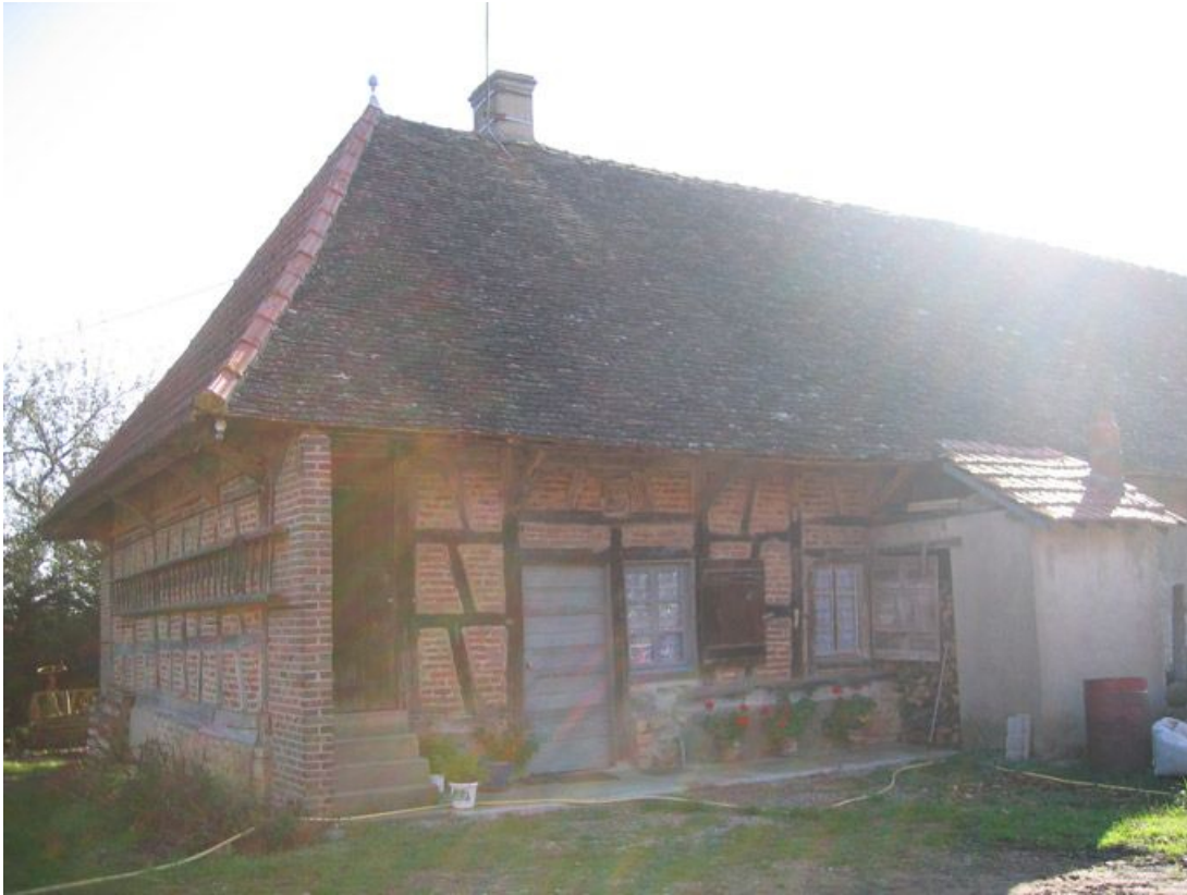
Vue d'ensemble de la façade de l'habitation.
