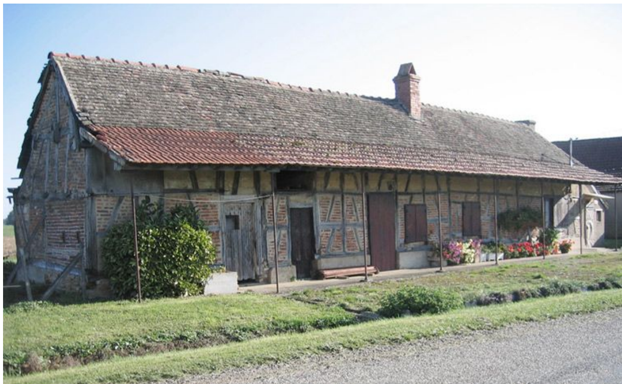
Vue d'ensemble de la façade.
