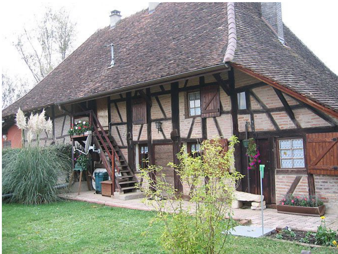
Vue d'ensemble de la façade de l'habitation.
