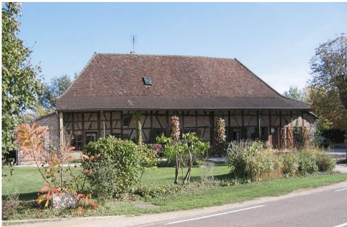
Vue d'ensemble de la façade.
