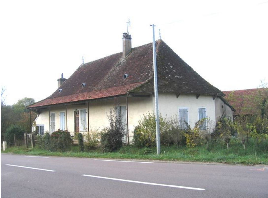
Vue d'ensemble de la façade de l'habitation.
