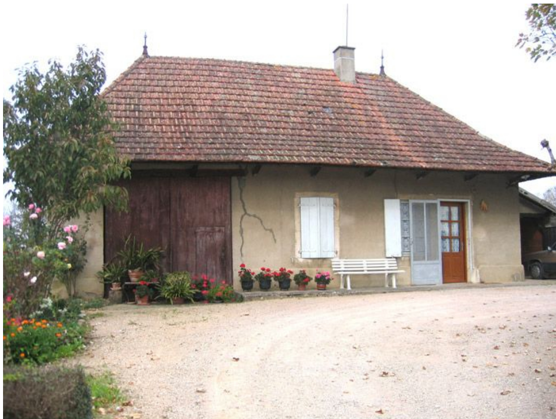
Vue d'ensemble de la façade.
