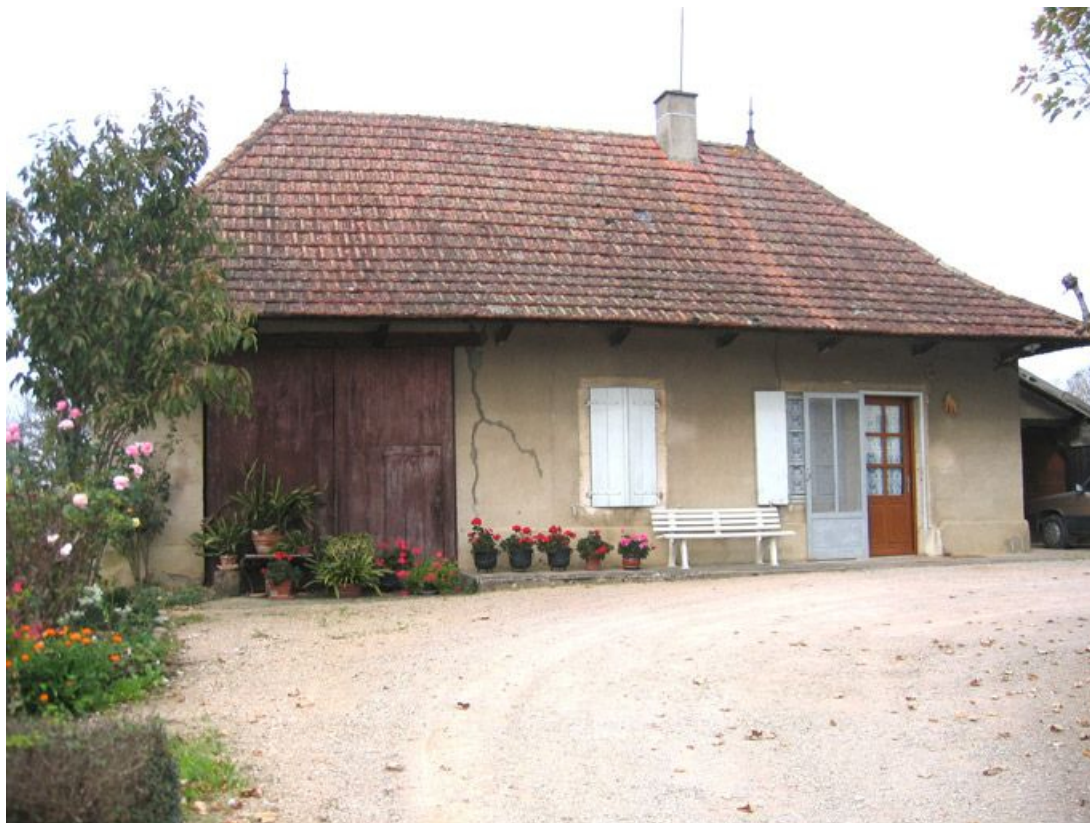
Vue d'ensemble de la façade.
