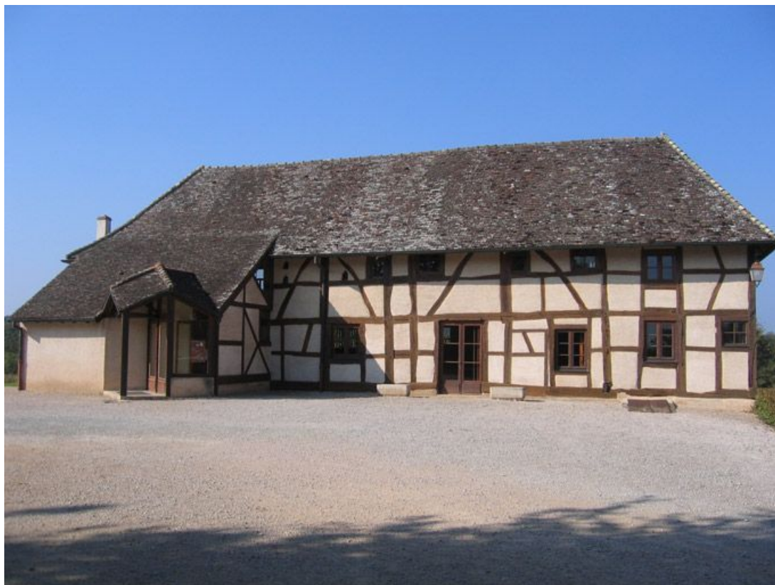
Vue d'ensemble de la façade.
