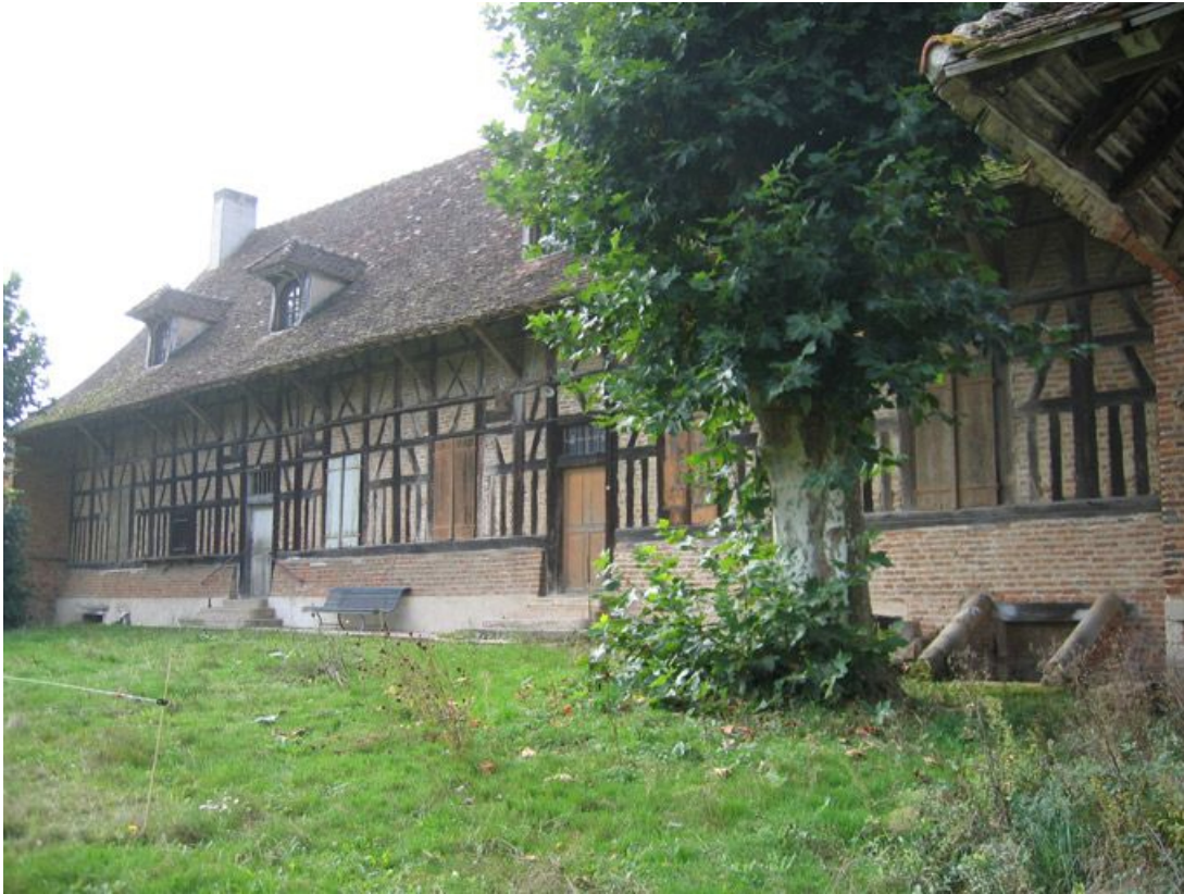
Vue d'ensemble de la façade de la deuxième maison.
