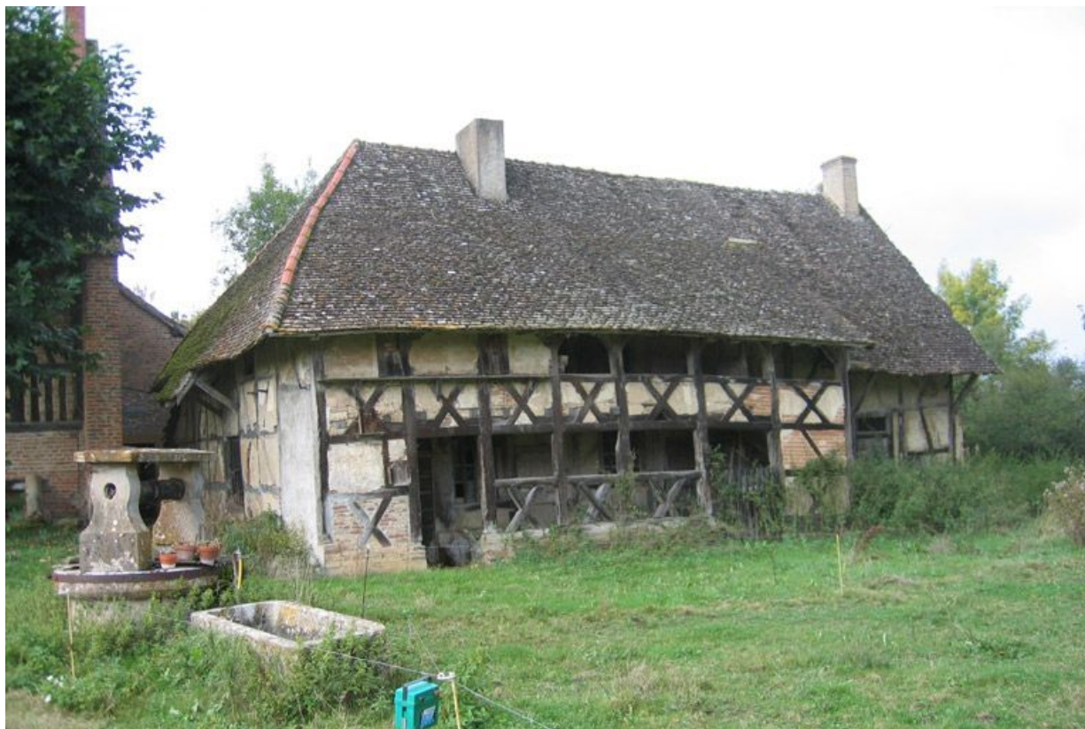
Vue d'ensemble de la façade de la première maison.
