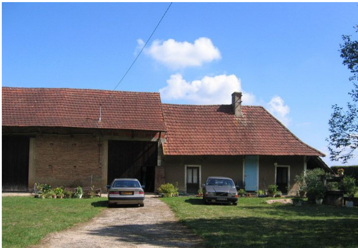
Vue d'ensemble de la façade antérieure.
