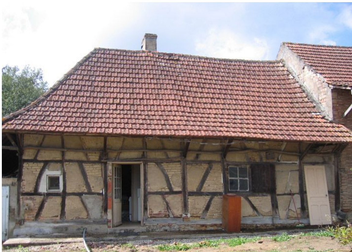
Vue d'ensemble de la façade postérieure.
