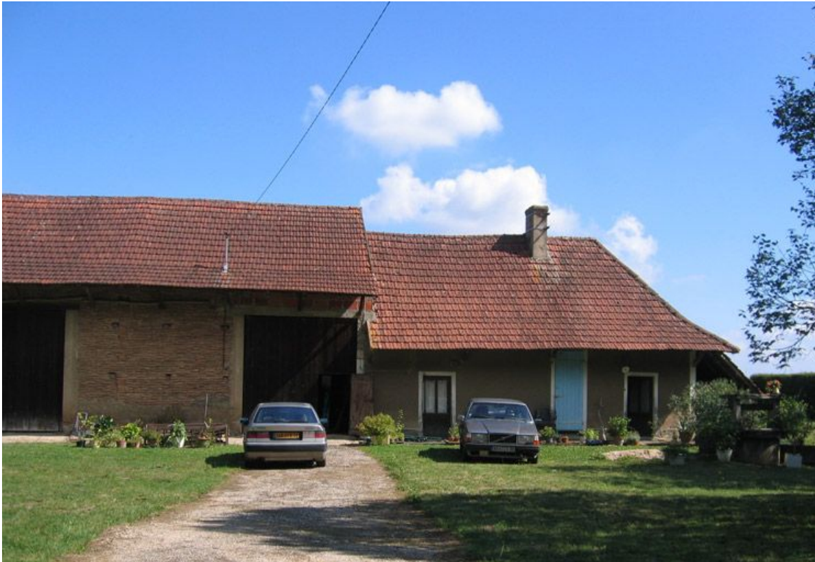
Vue d'ensemble de la façade antérieure.
