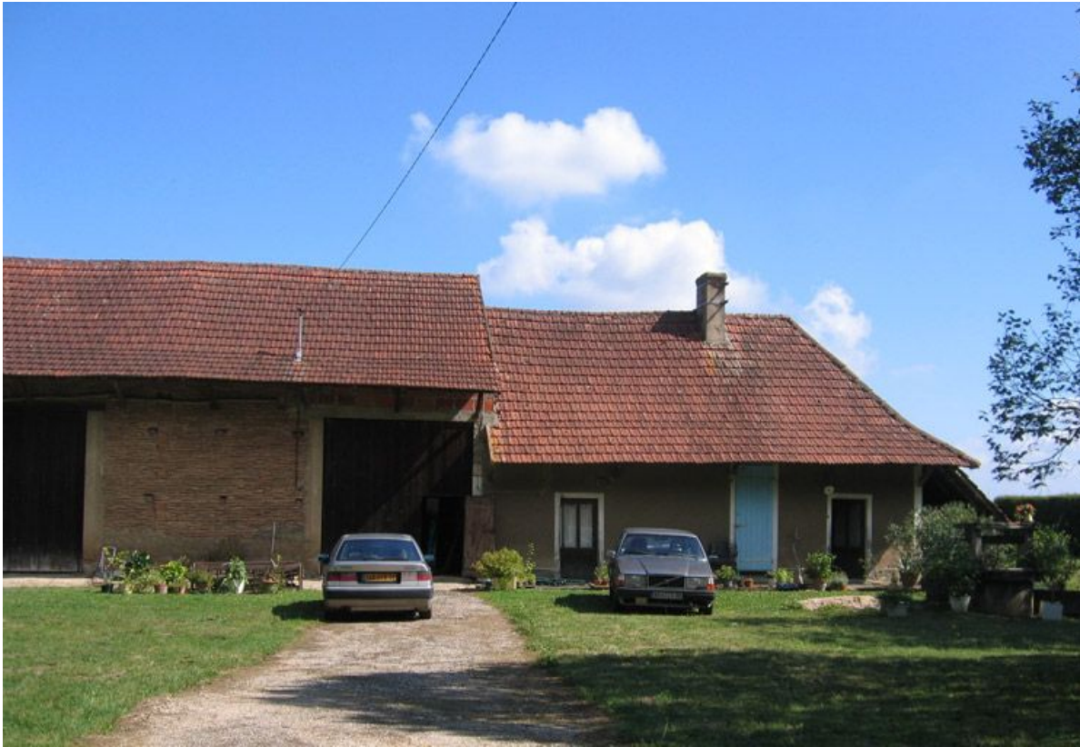
Vue d'ensemble de la façade antérieure.
