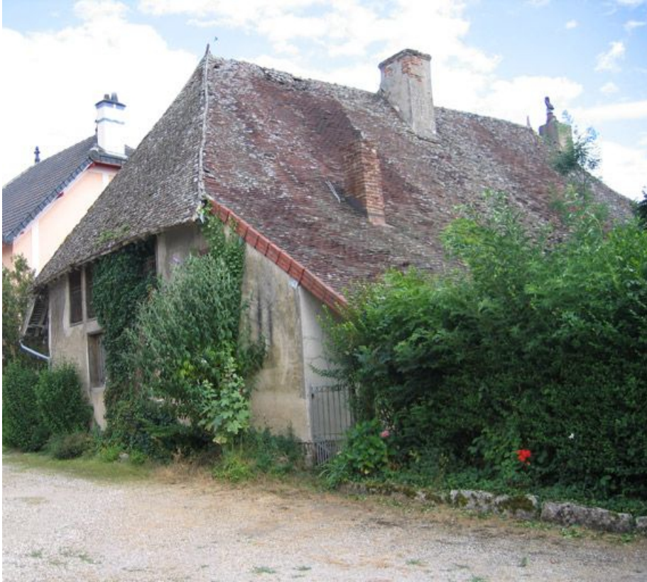
Vue d'ensemble de la façade postérieure.
