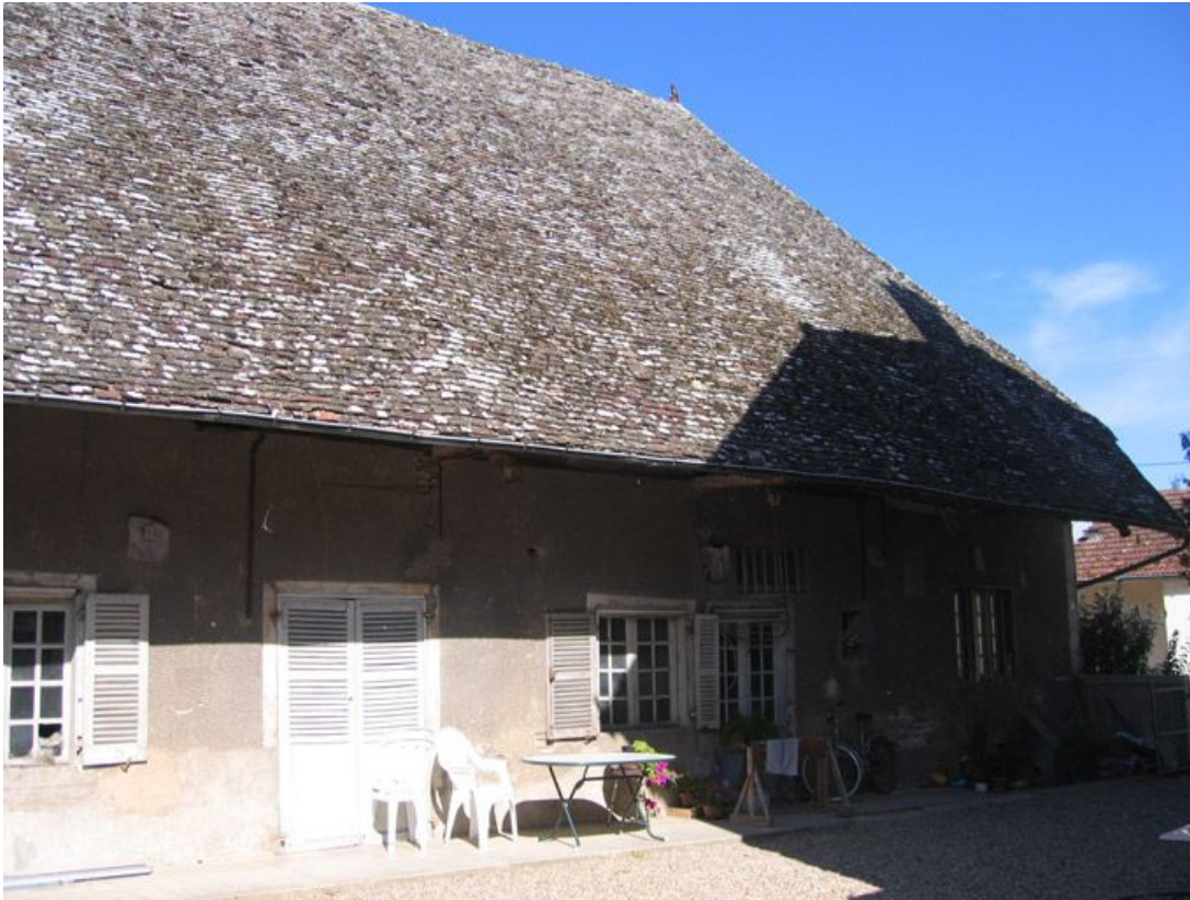
Vue d'ensemble de la façade antérieure.
