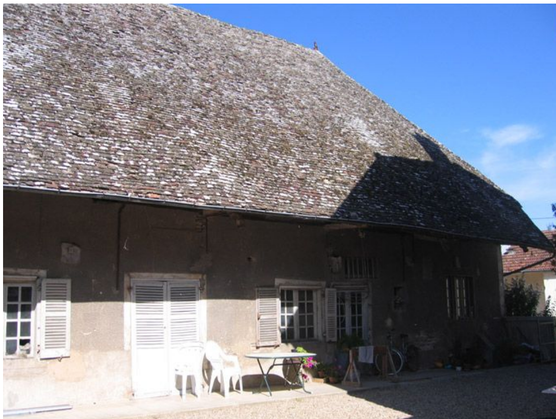
Vue d'ensemble de la façade antérieure.
