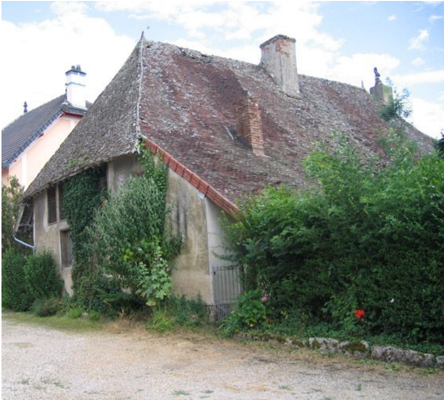
Vue d'ensemble de la façade postérieure.
