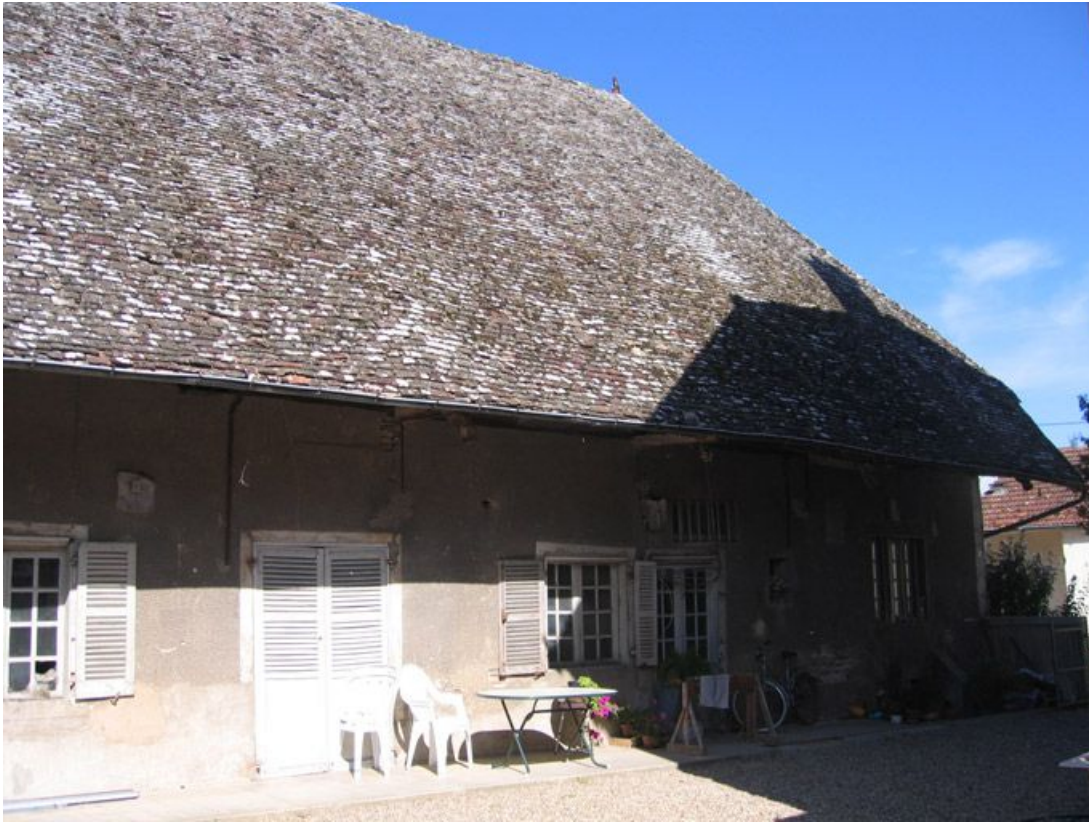
Vue d'ensemble de la façade antérieure.
