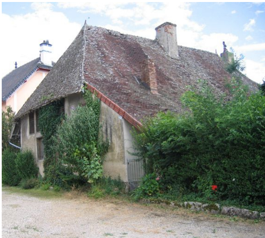
Vue d'ensemble de la façade postérieure.
