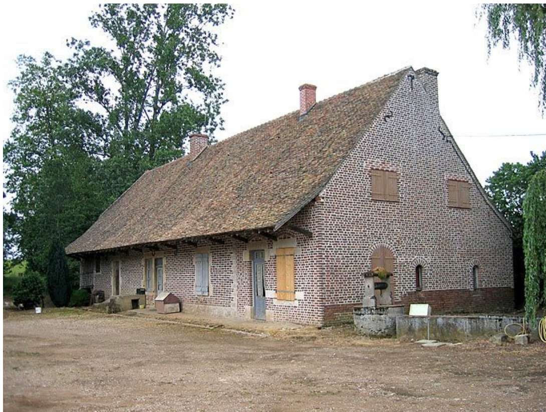
Vue d'ensemble de la façade de 3/4 droit.
