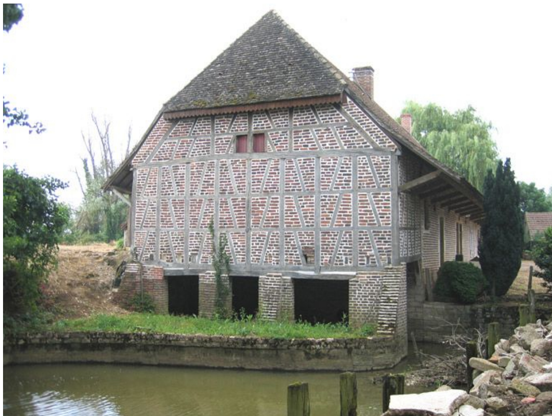
Vue d'ensemble de 3/4 gauche.
