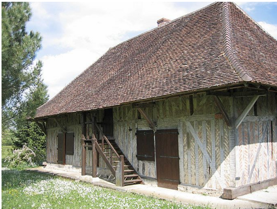
Vue d'ensemble de la façade.
