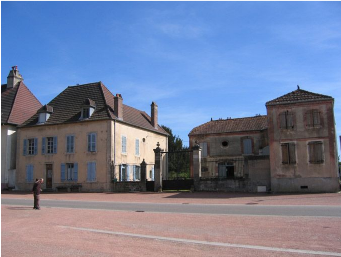
Vue d'ensemble de la façade.
