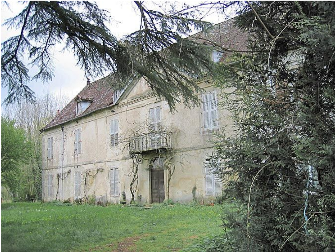
Vue d'ensemble de la façade de l'habitation.
