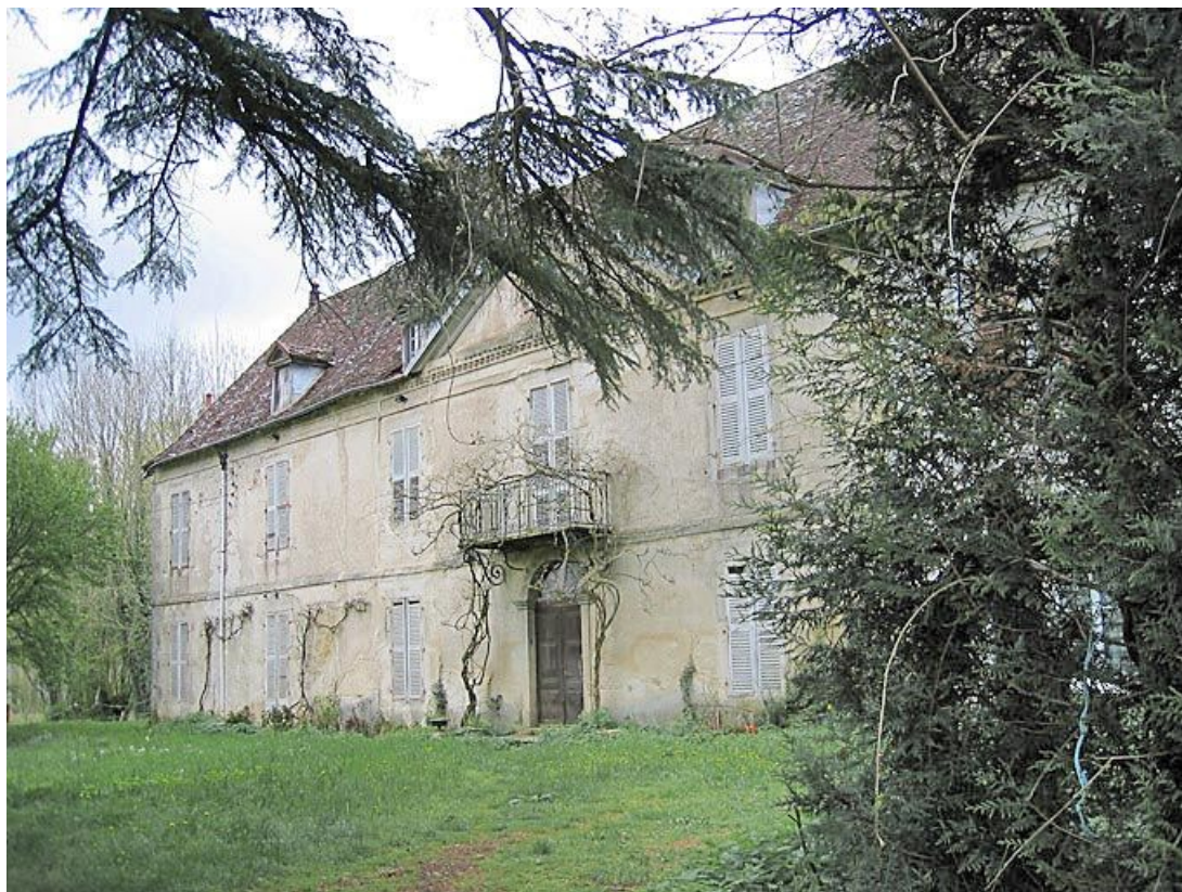
Vue d'ensemble de la façade de l'habitation.
