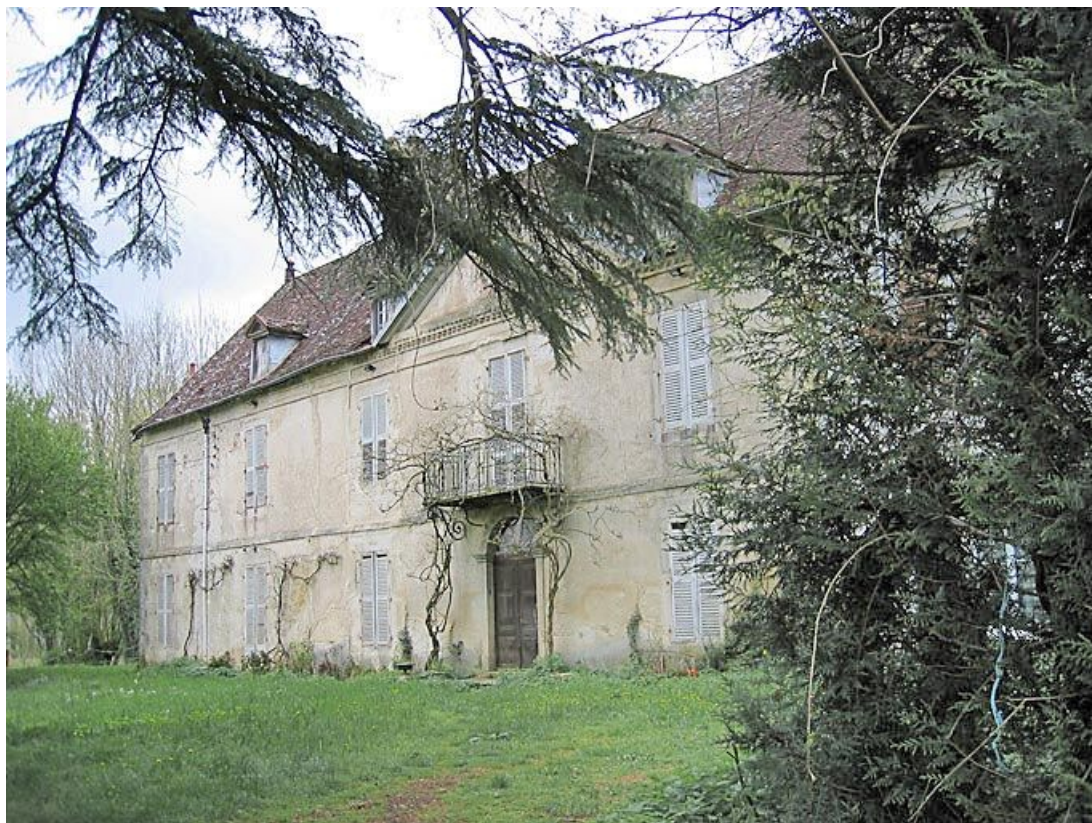
Vue d'ensemble de la façade de l'habitation.
