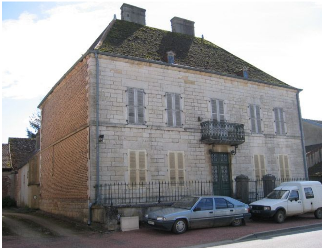
Vue d'ensemble de la façade.
