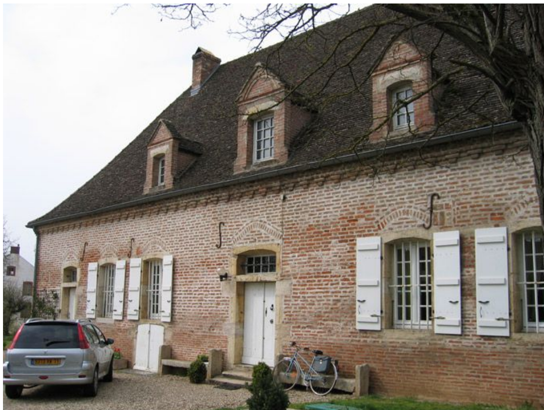
Vue d'ensemble de la façade de l'habitation.
