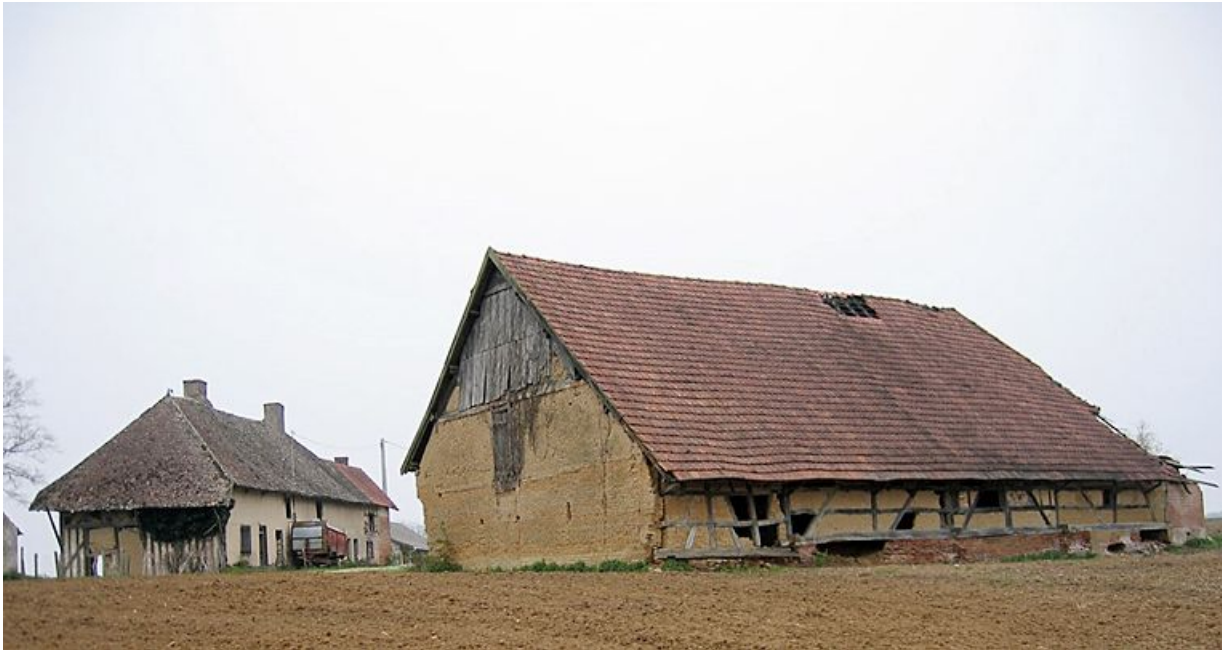
Vue d'ensemble de la façade du bâtiment des dépendances.
