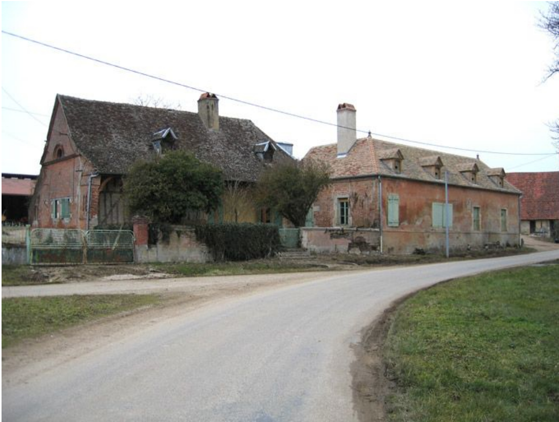
Vue d'ensemble de la façade.
