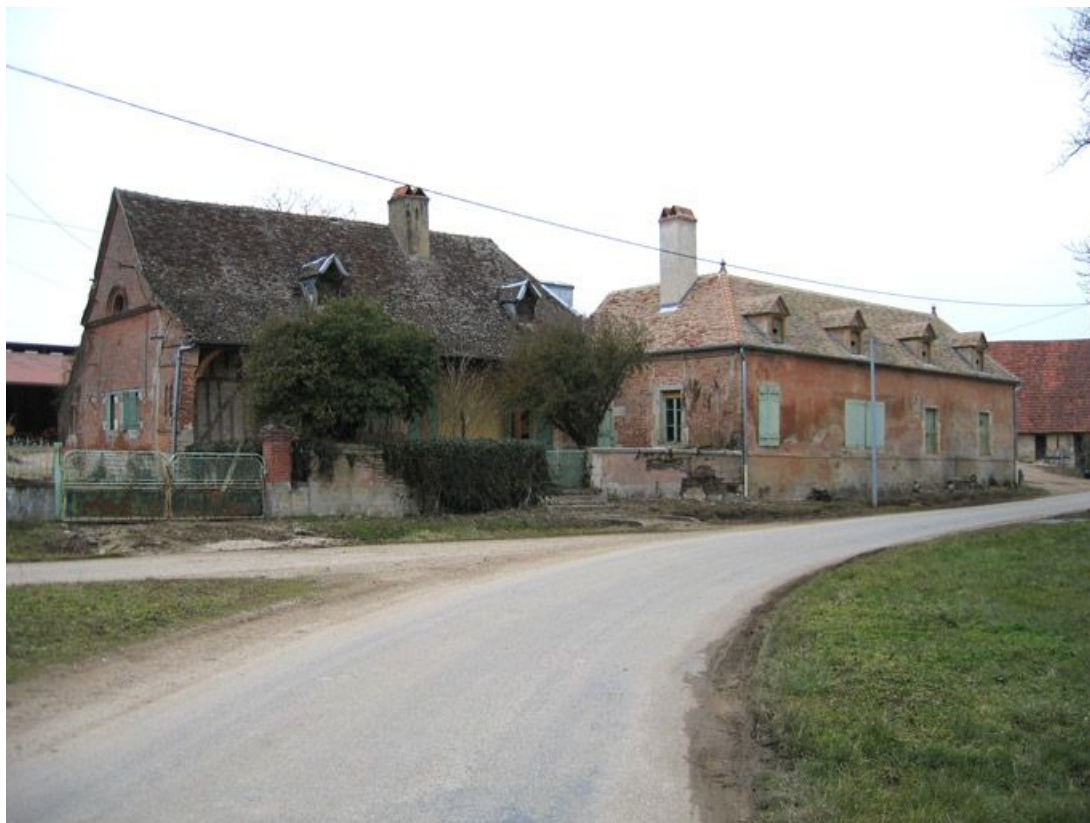
Vue d'ensemble de la façade.
