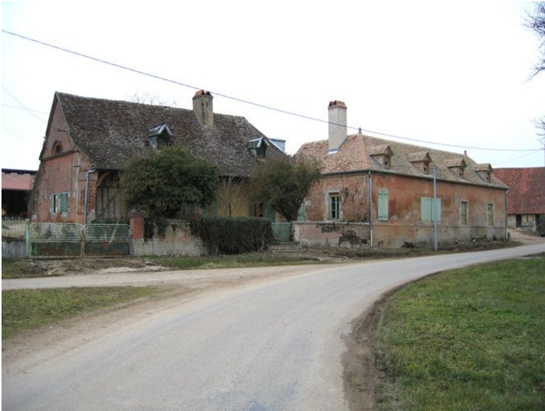
Vue d'ensemble de la façade.
