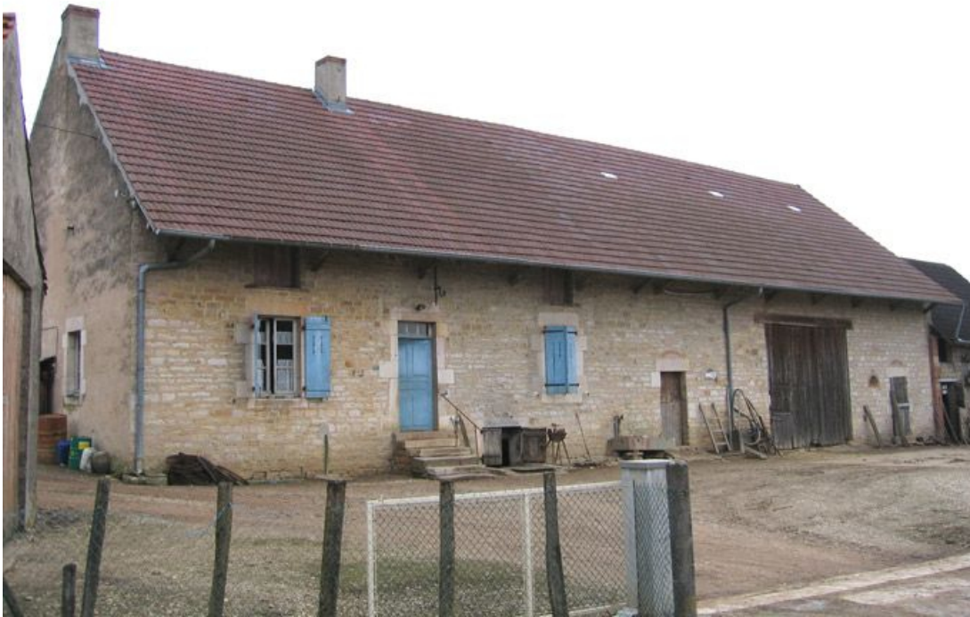
Vue d'ensemble de la façade.
