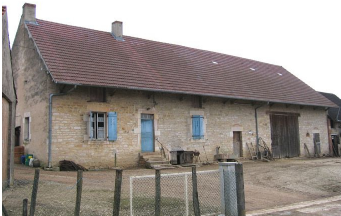
Vue d'ensemble de la façade.
