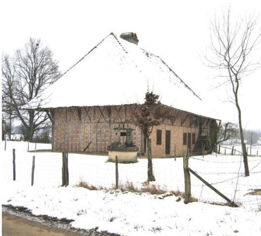
Vue d'ensemble de la façade de l'habitation.
