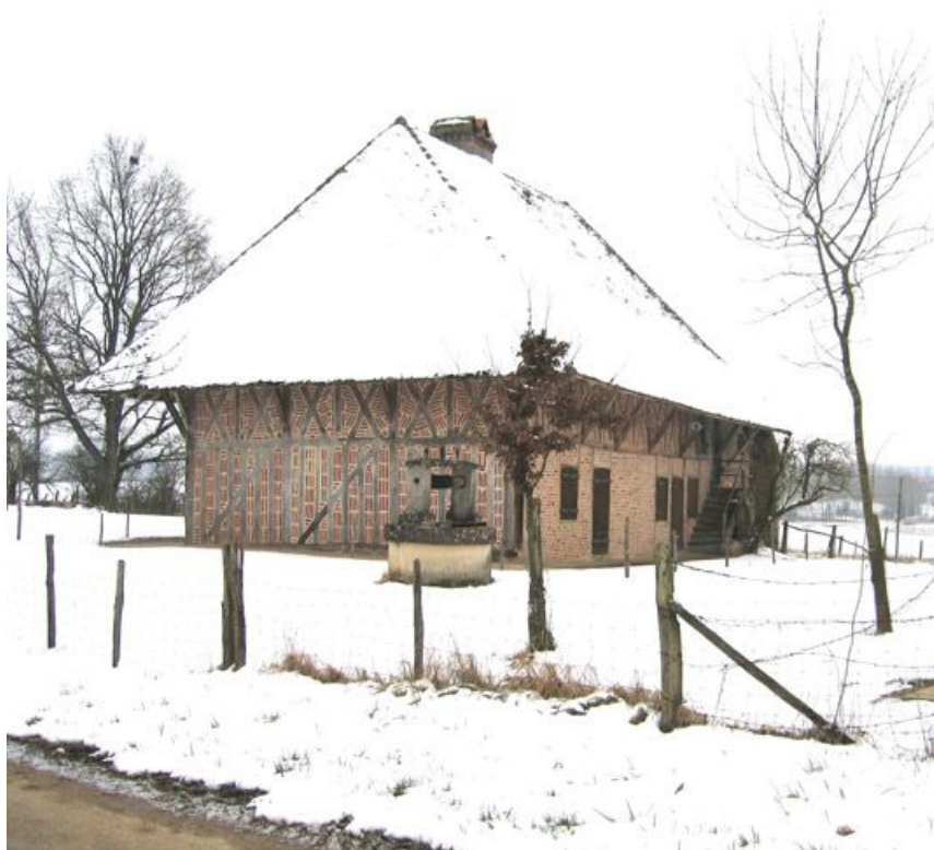
Vue d'ensemble de la façade de l'habitation.
