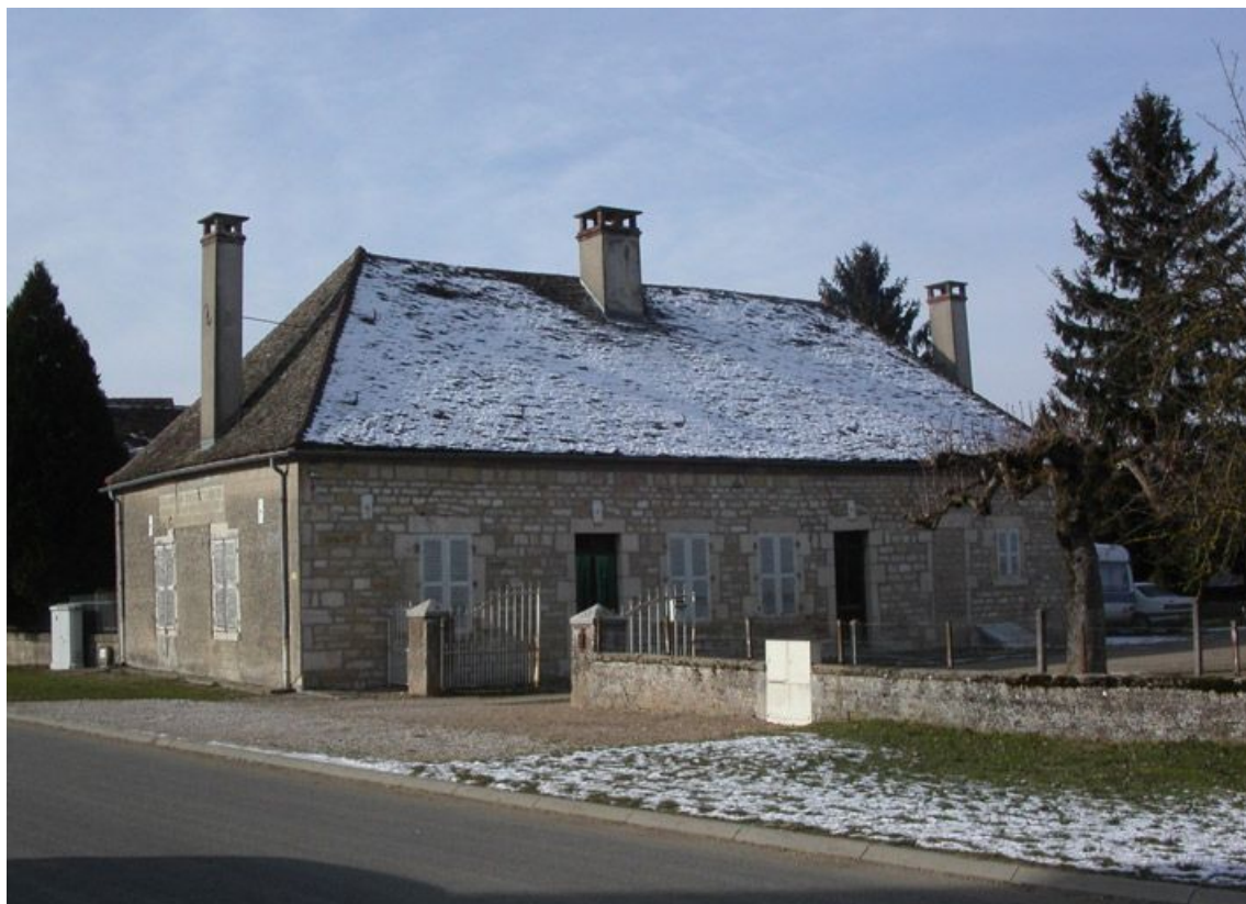
Vue d'ensemble de la façade.
