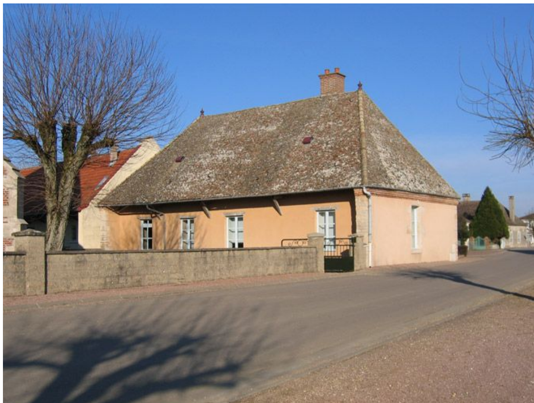
Vue d'ensemble de la façade.
