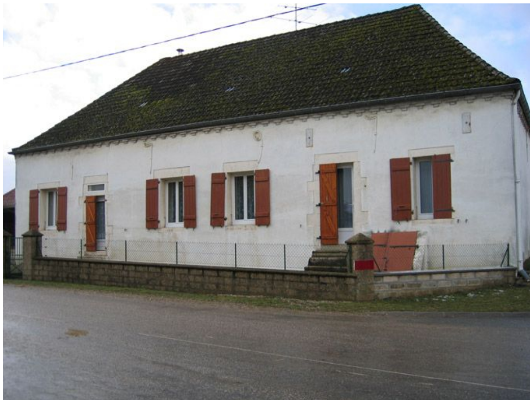
Vue d'ensemble de la façade.
