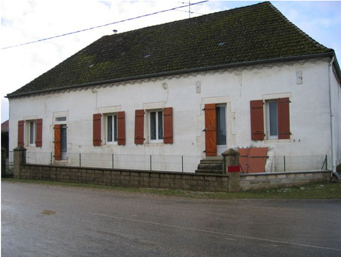
Vue d'ensemble de la façade.
