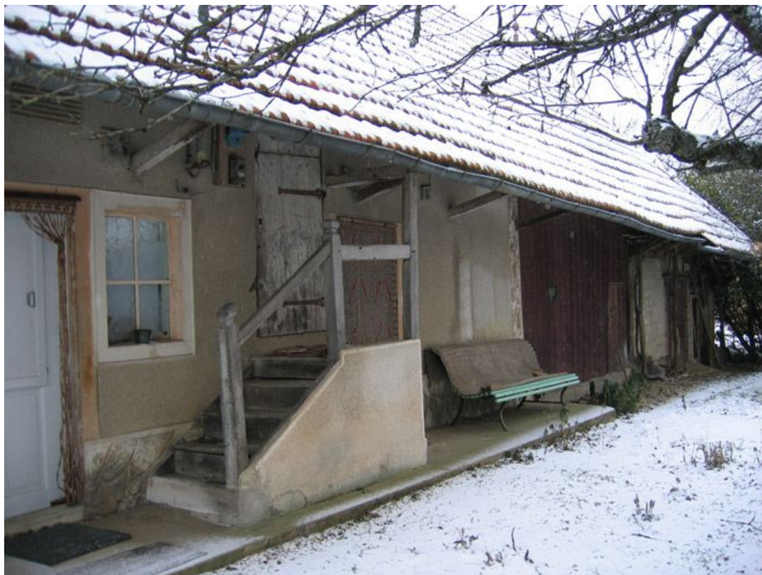
Vue d'ensemble de la façade.
