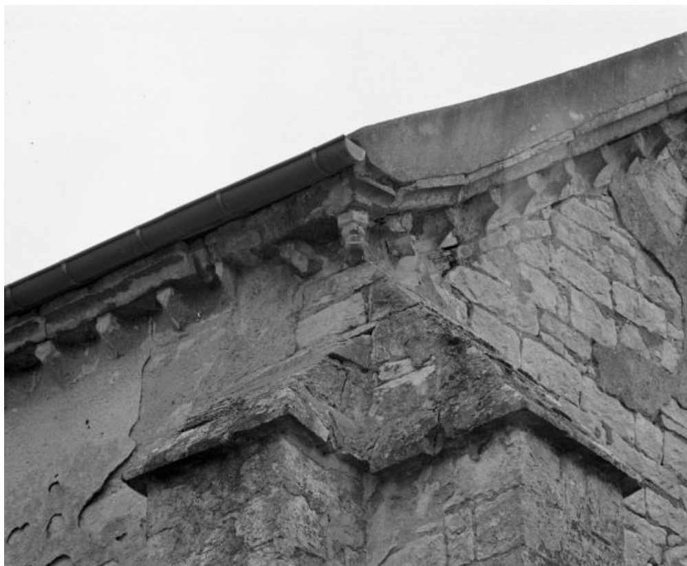
Façade : détail de l'angle gauche du pignon.
