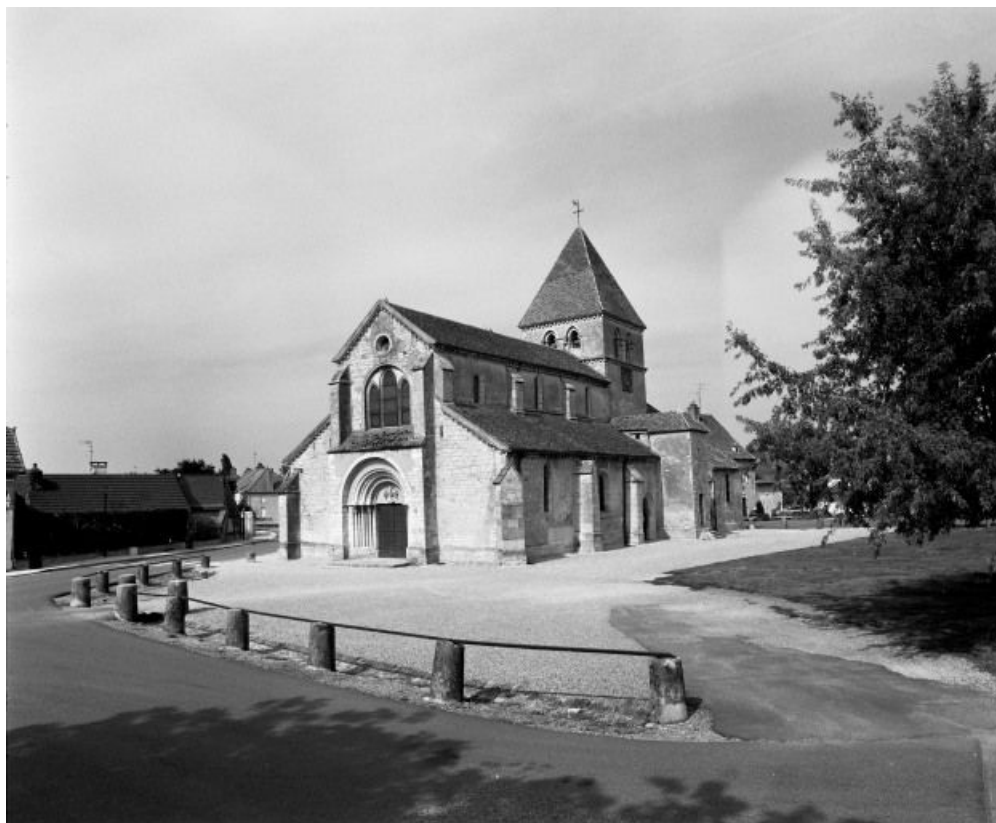
Vue d'ensemble : façade et élévation droite.
