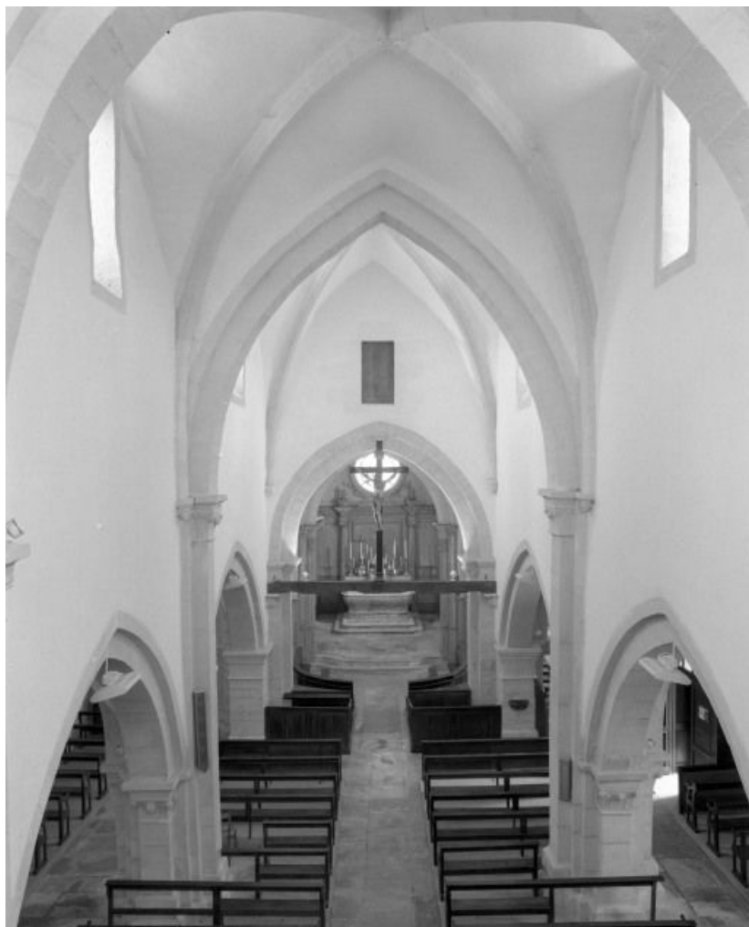
Vue d'ensemble depuis la tribune.
