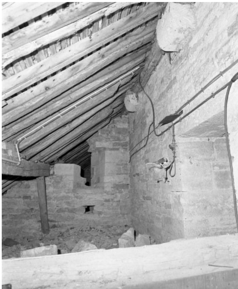
Mur gauche du clocher et mur postérieur de la chapelle gauche, vue prise du comble.
