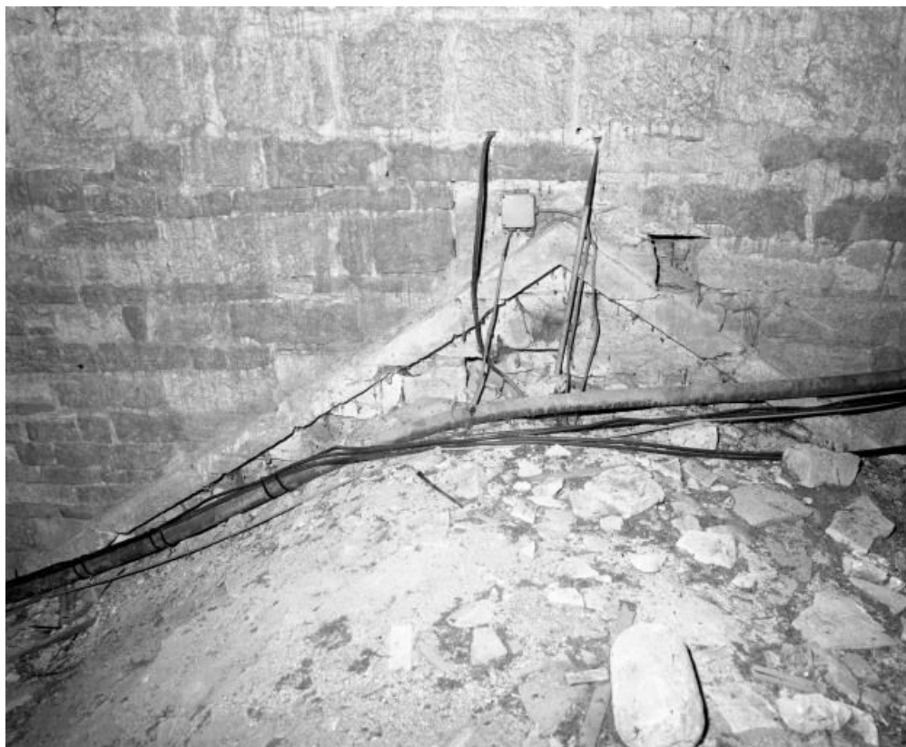
Rampants du pignon de l'ancien toit du choeur contre le mur postérieur du clocher. Vue prise dans le comble du choeur. 71, Saint-Loup-Géanges Joseph Delissey, lieudit : Saint-Loup-de-la-Salle
