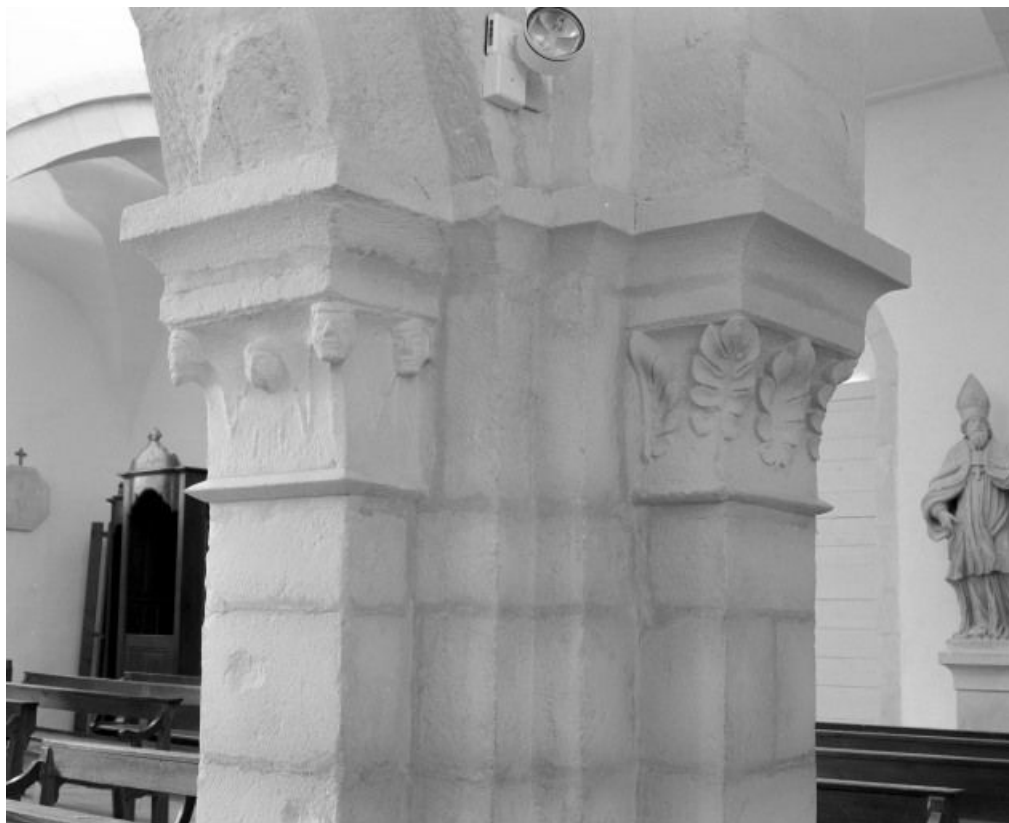
Bas-côté gauche, 2e travée, chapiteaux du pilier postérieur droit (n° 26 sur le plan de localisation). 71, Saint-Loup-Géanges Joseph Delissey, lieudit : Saint-Loup-de-la-Salle
