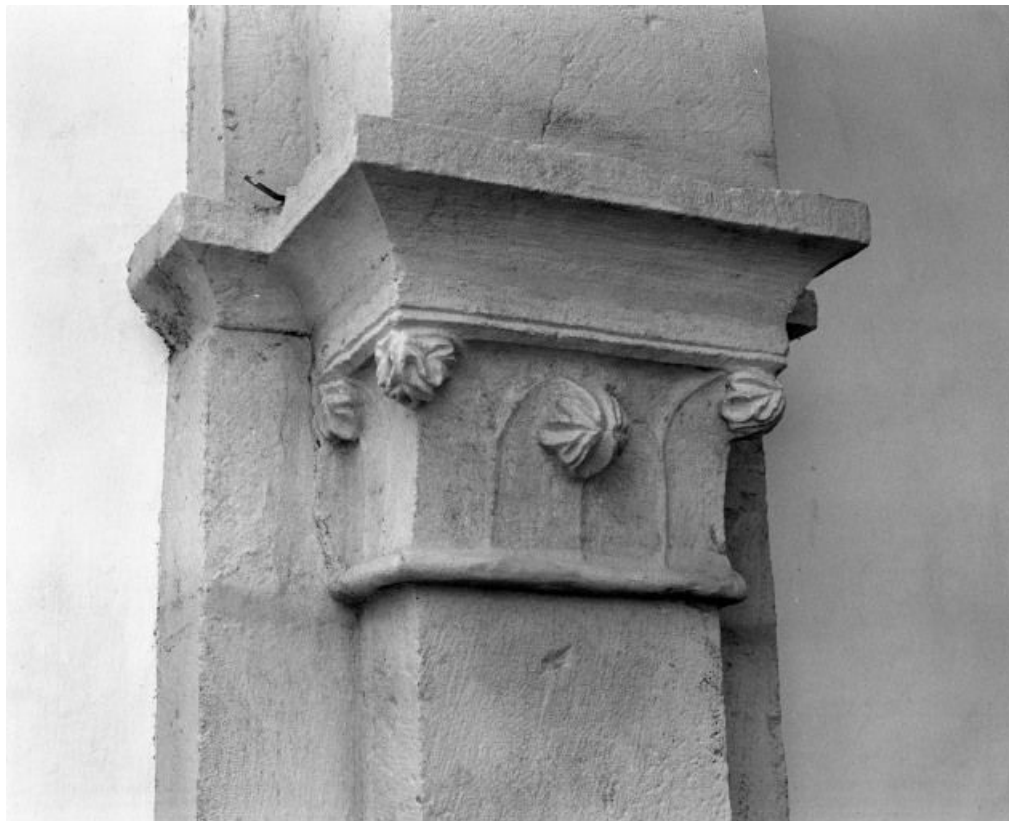
Bas-côté droit, chapiteau droit de l'arcade entre les 1ère et 2e travées (n° 20 sur le plan de localisation). 71, Saint-Loup-Géanges Joseph Delissey, lieudit : Saint-Loup-de-la-Salle
