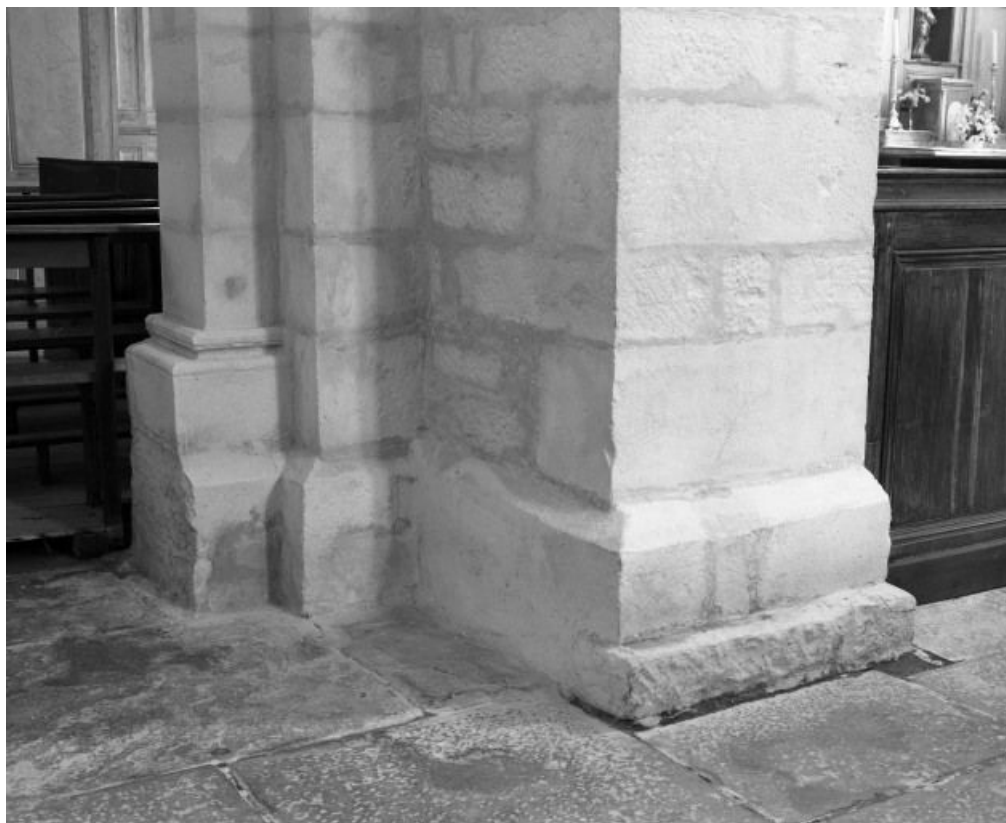
Travée sous clocher, base du pilier antérieur gauche, vue prise du bas-côté (n° 6 sur le plan de localisation). 71, Saint-Loup-Géanges Joseph Delissey, lieudit : Saint-Loup-de-la-Salle
