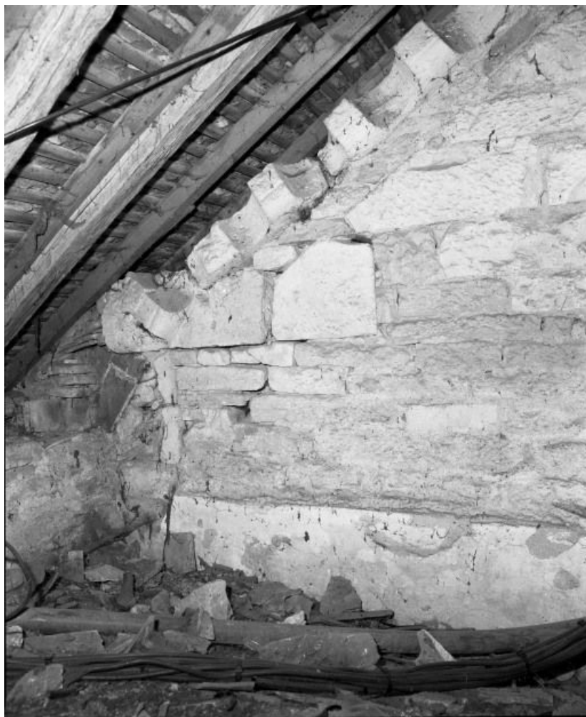
Partie inférieure du rampant du bas-côté droit, vue prise du comble de la sacristie.
