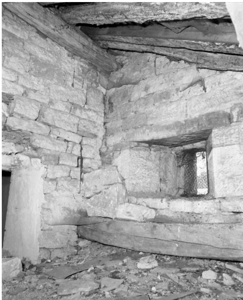
Bas-côté gauche, jour antérieur, vue prise du comble.
