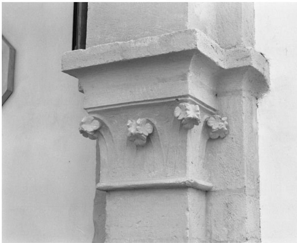
Bas-côté droit, chapiteau droit de l'arcade entre les 2e et 3e travées (n° 19 sur le plan de localisation). 71, Saint-Loup-Géanges Joseph Delissey, lieudit : Saint-Loup-de-la-Salle
