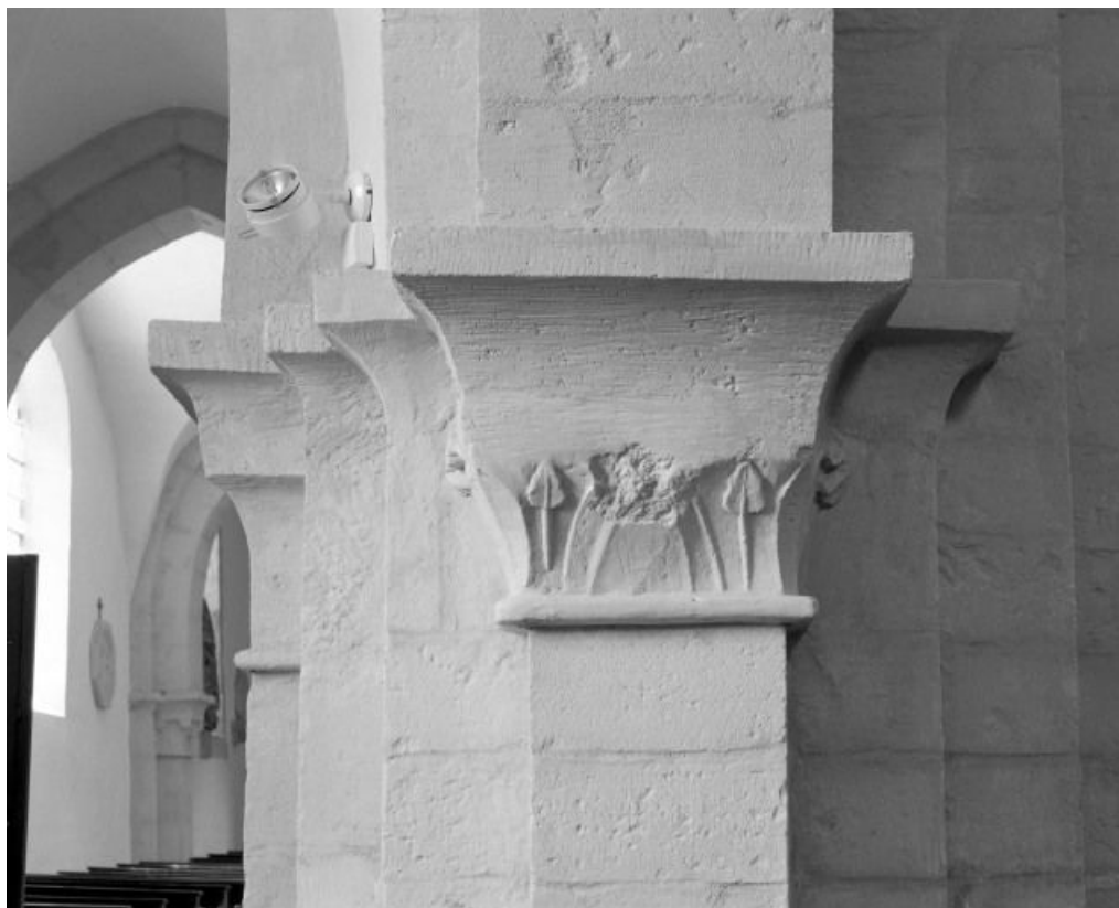
Avant-choeur sous clocher, arcade droite, chapiteau antérieur (n° 3 sur le plan de localisation). 71, Saint-Loup-Géanges Joseph Delissey, lieudit : Saint-Loup-de-la-Salle
