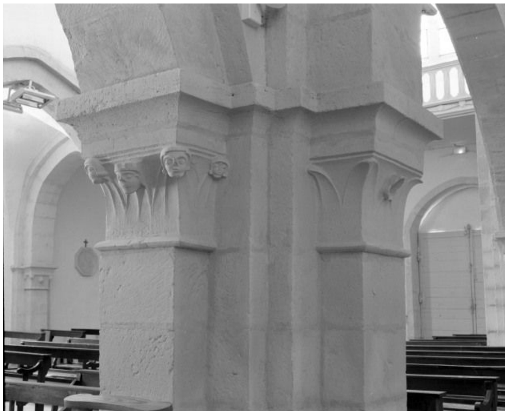
Bas-côté gauche, 3e travée, chapiteaux du pilier antérieur droit (n° 23 sur le plan de localisation). 71, Saint-Loup-Géanges Joseph Delissey, lieudit : Saint-Loup-de-la-Salle
