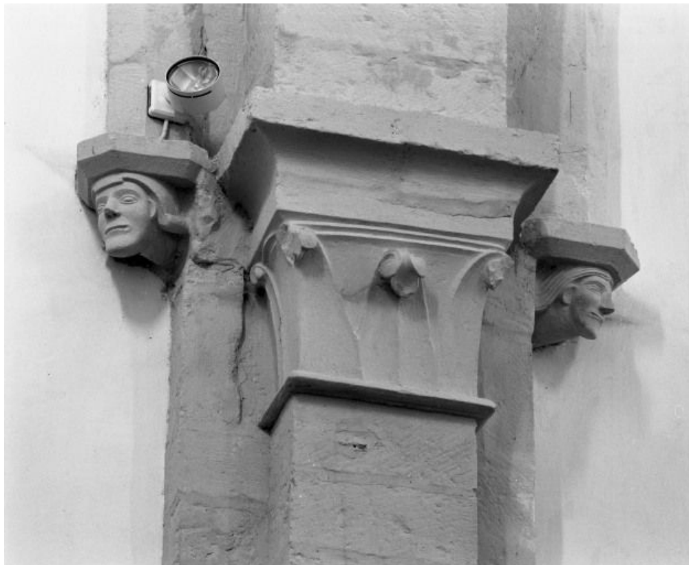
Nef, culots et chapiteau à droite entre les 2e et 3e travées (n° 7 sur le plan de localisation). 71, Saint-Loup-Géanges Joseph Delissey, lieudit : Saint-Loup-de-la-Salle
