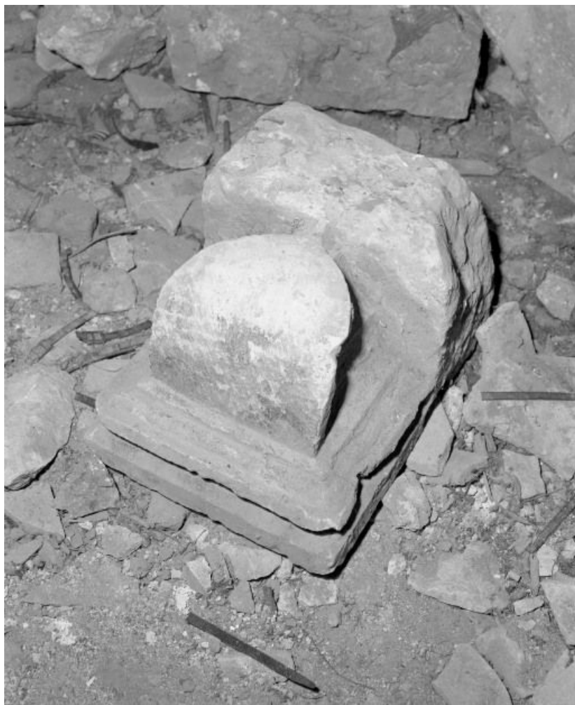
Console avec armoiries peintes (déposée dans le comble).
