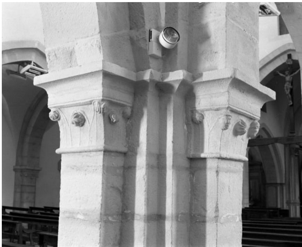
Bas-côté droit, 1ère travée, chapiteau du pilier postérieur gauche (n° 22 sur le plan de localisation). 71, Saint-Loup-Géanges Joseph Delissey, lieudit : Saint-Loup-de-la-Salle
