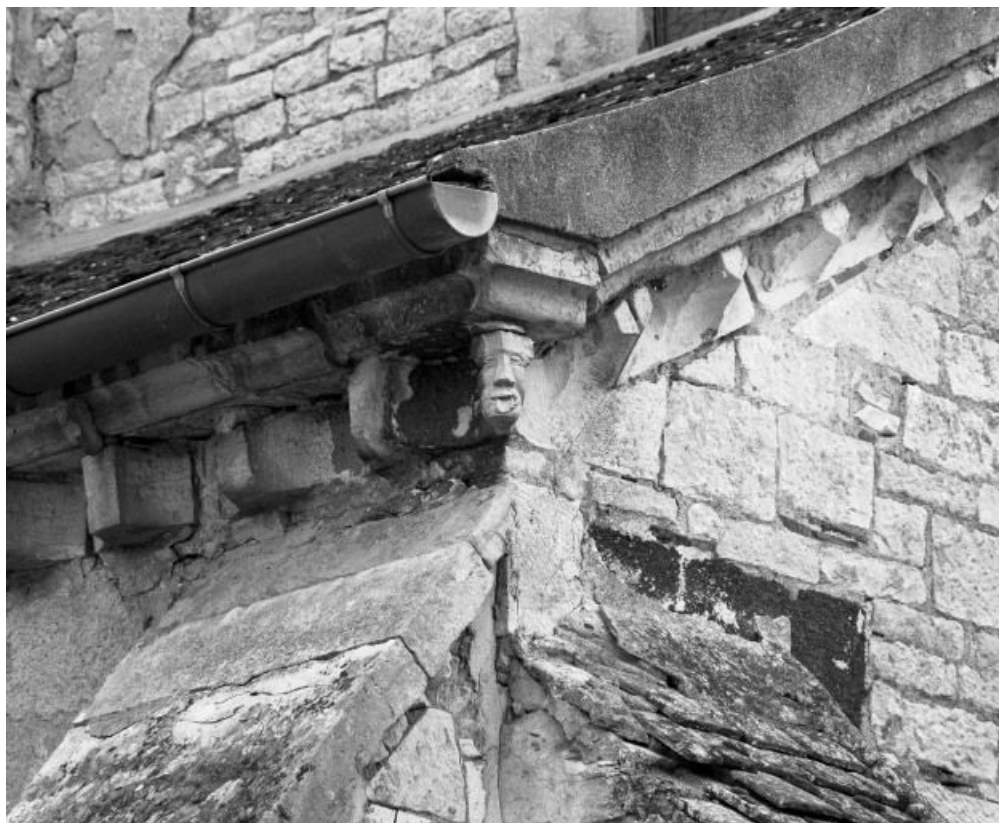
Façade : détail de l'angle du bas-côté gauche.
