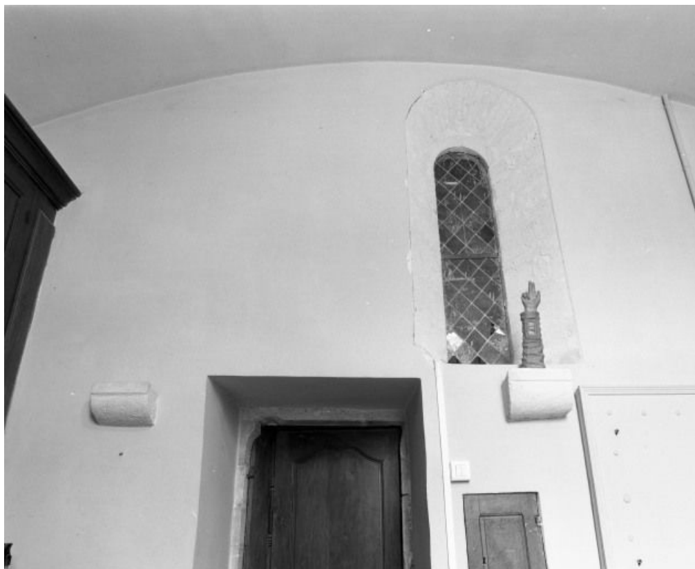
Sacristie, porte et fenêtre donnant sur le chœur (mur nord).
