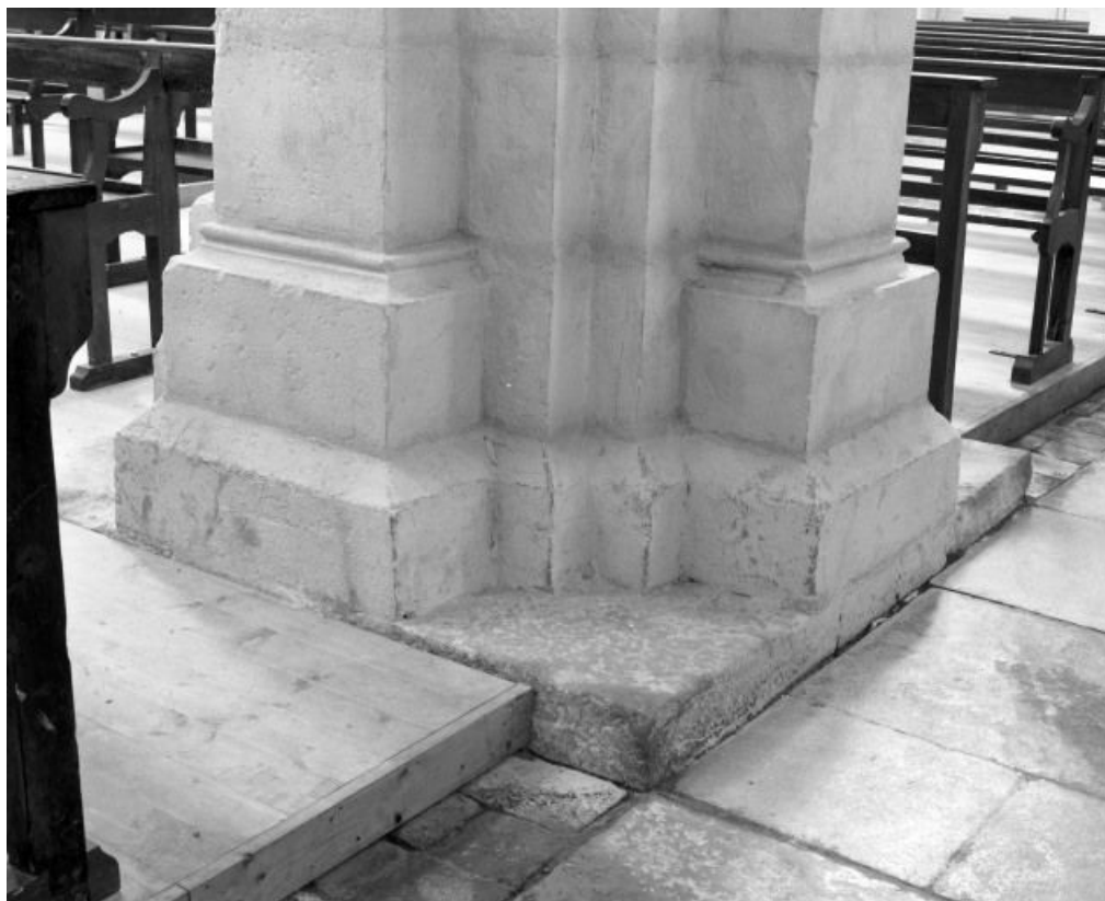
Bas-côté gauche, 3e travée, base du pilier antérieur droit (n° 24 sur le plan de localisation). 71, Saint-Loup-Géanges Joseph Delissey, lieudit : Saint-Loup-de-la-Salle
