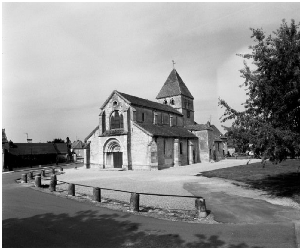
Vue d'ensemble : façade et élévation droite.
